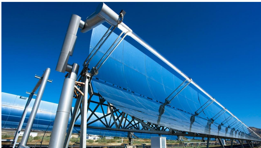
Σχήμα 2-1: Κοιλοπαραβολικοί ηλιακοί συλλέκτες, DLR/Ernsting
