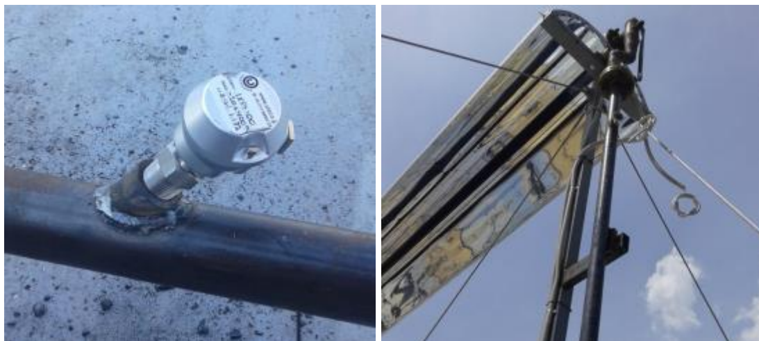
Σχήμα 7-9: Αισθητήρες θερμοκρασίας του θερμικού λαδιού
