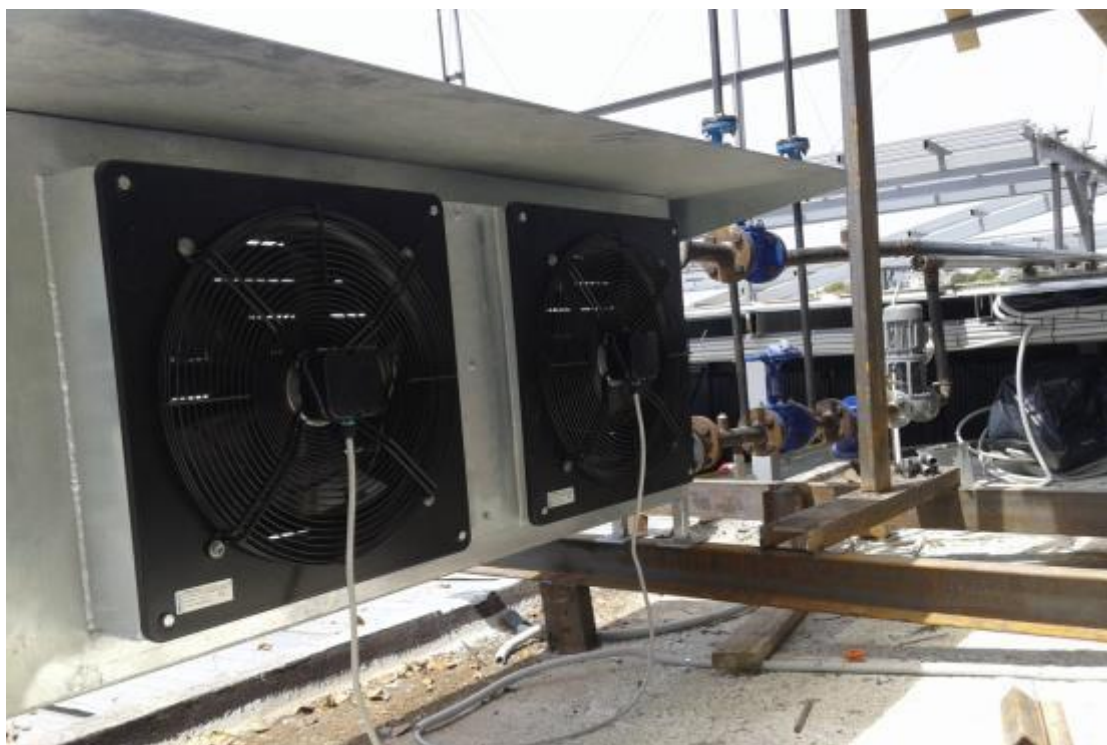
Σχήμα 7-7: Ψύκτης θερμικού λαδιού
