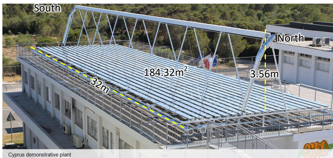
Σχήμα 8-5: Ηλιακός συλλέκτης Fresnel [110]
