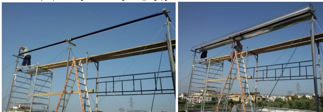
Σχήμα 7-3: Τοποθέτηση σωλήνων κενού και δευτερεύοντος ανακλαστήρα
