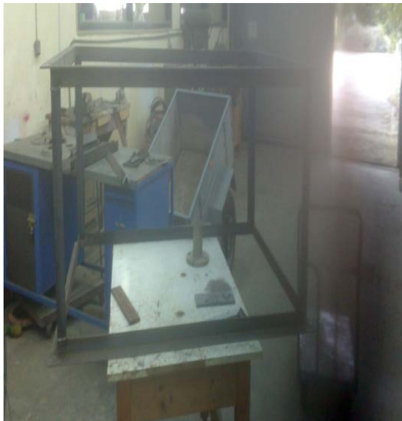
Σχήμα 2.16:Κατασκευή πλαισίου τμήματος του settling chamber
