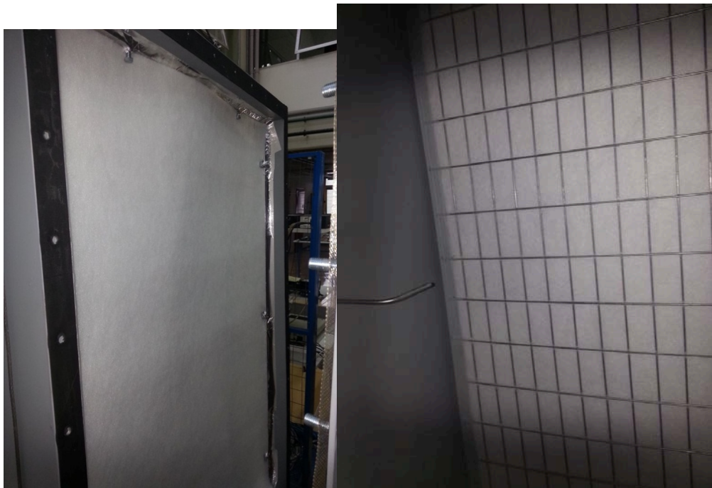
Σχήμα 2.30: Τοποθέτηση φίλτρου αέρα στο settling chamber
