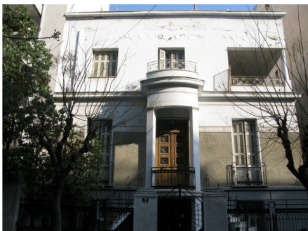
Εικόνα 34: Κτήριο επί της οδού Ραβινέ 15 στο Κολωνάκι πριν από την κατεδάφισή του – Πηγή: monumenta.org
