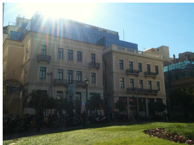
Εικόνα 24: Άποψη από τα δίδυμα κτήρια στην οδό Κολοκοτρώνη - Πηγή: Internet
