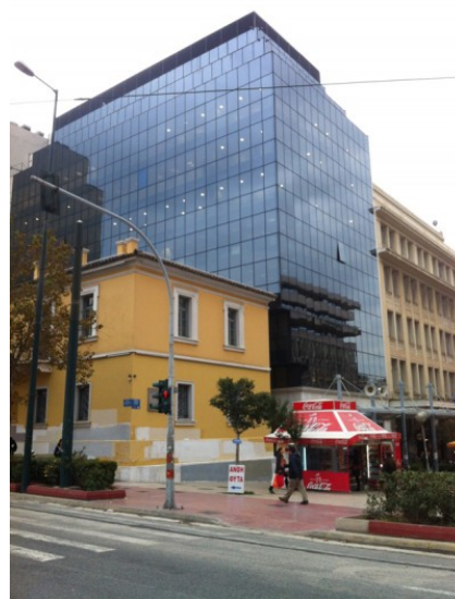
Εικόνα 21: Κτήριο επί της οδού Πανεπιστημίου & Κοραή. Κατοικία οικογένειας Σούτσων – Πηγή: Internet
