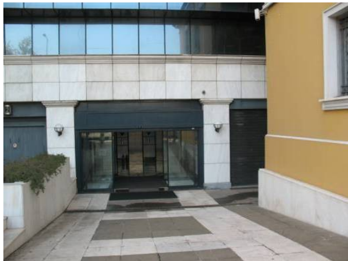
Εικόνα 23: Ο ακόλυπτος ο οποίος σύμφωνα με τις διαβεβαιώσεις των ιδιοκτητών και του αρχιτέκτονα τους θα διαμορφώνονταν σε κήπο, όπως ήταν τον 19 ο αιώνα, έγινε είσοδος του πάρκινγκ! – Πηγή: Γ. Μ. Σαρηγιάννης
