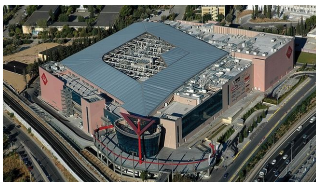
Εικόνα 9: Athens Mall: Το μεγαλύτερο αυθαίρετο της χώρας. Κατασκευάστηκε με το Ν.3207/2003: Ρύθμιση θεμάτων Ολυμπιακής Προετοιμασίας και άλλες διατάξεις.", ο οποίος υπερδιπλασίασε τους όρους εκμετάλλευσης περιοχής του Αμαρουσίου.
