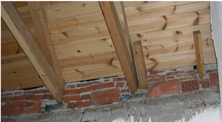
Εικόνα 1.26: Απόληξεις ζευκτών και έλλειψη σύνδεσης με την υποκείμενη κατασκευή [27]
