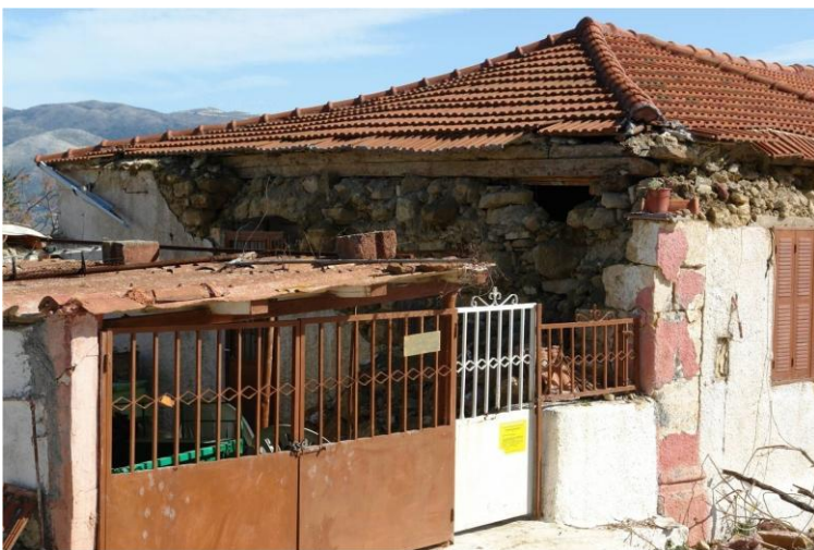
Εικόνα 2.3: Τμηματική κατάρρευση τοιχοποιίας, Κεφαλονιά, 2014 [27]
