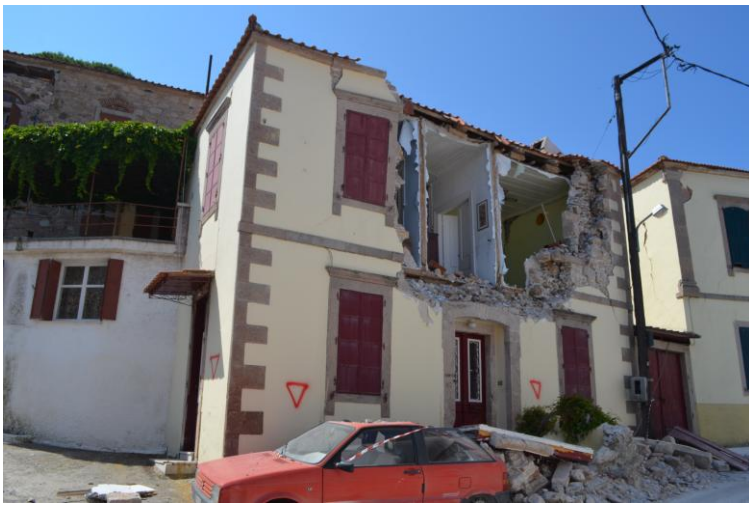
Εικόνα 2.1(αριστερά), Εικόνα 2.2α( δεξιά): Κατάρρευση τοιχοποιίας εκτός του επιπέδου της, Βρίσσα ,Λέσβος 2017 [27]
