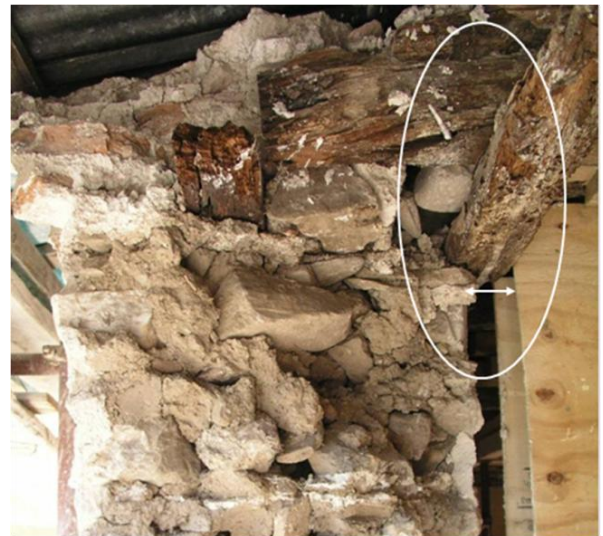
Εικόνα 2.12: Αστοχία σύνδεσης [27]
