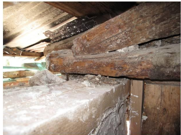
Εικόνα 1.26: Απόληξεις ζευκτών και έλλειψη σύνδεσης με την υποκείμενη κατασκευή [27]
