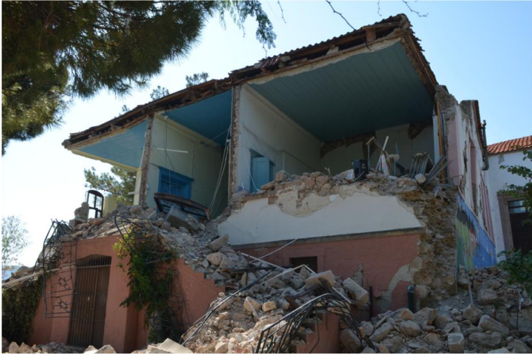
Εικόνα 2.1(αριστερά), Εικόνα 2.2α( δεξιά): Κατάρρευση τοιχοποιίας εκτός του επιπέδου της, Βρίσσα ,Λέσβος 2017 [27]
