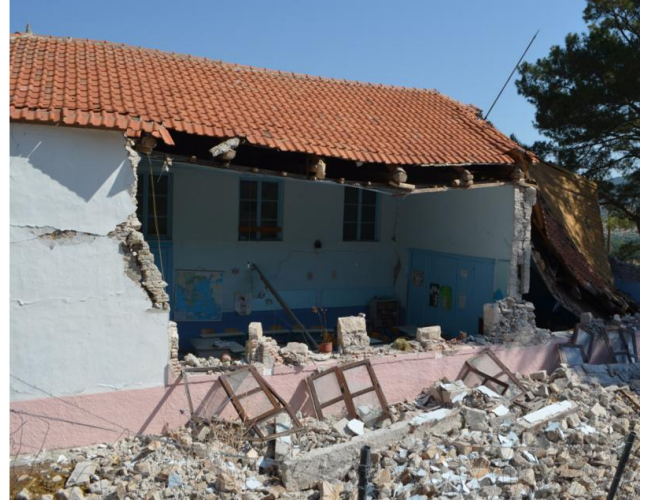
Εικόνα 2.1(αριστερά), Εικόνα 2.2α( δεξιά): Κατάρρευση τοιχοποιίας εκτός του επιπέδου της, Βρίσσα ,Λέσβος 2017 [27]
