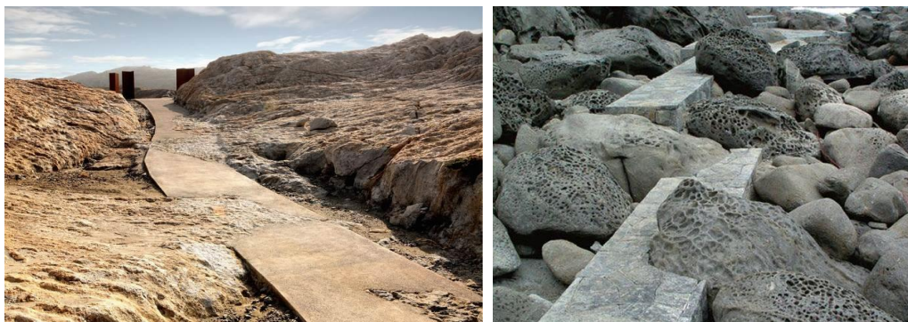
Εικόνα 49: Παραδείγματα σχηματισμού μονοπατιών με κονίαμα πάνω σε πέτριωμα
