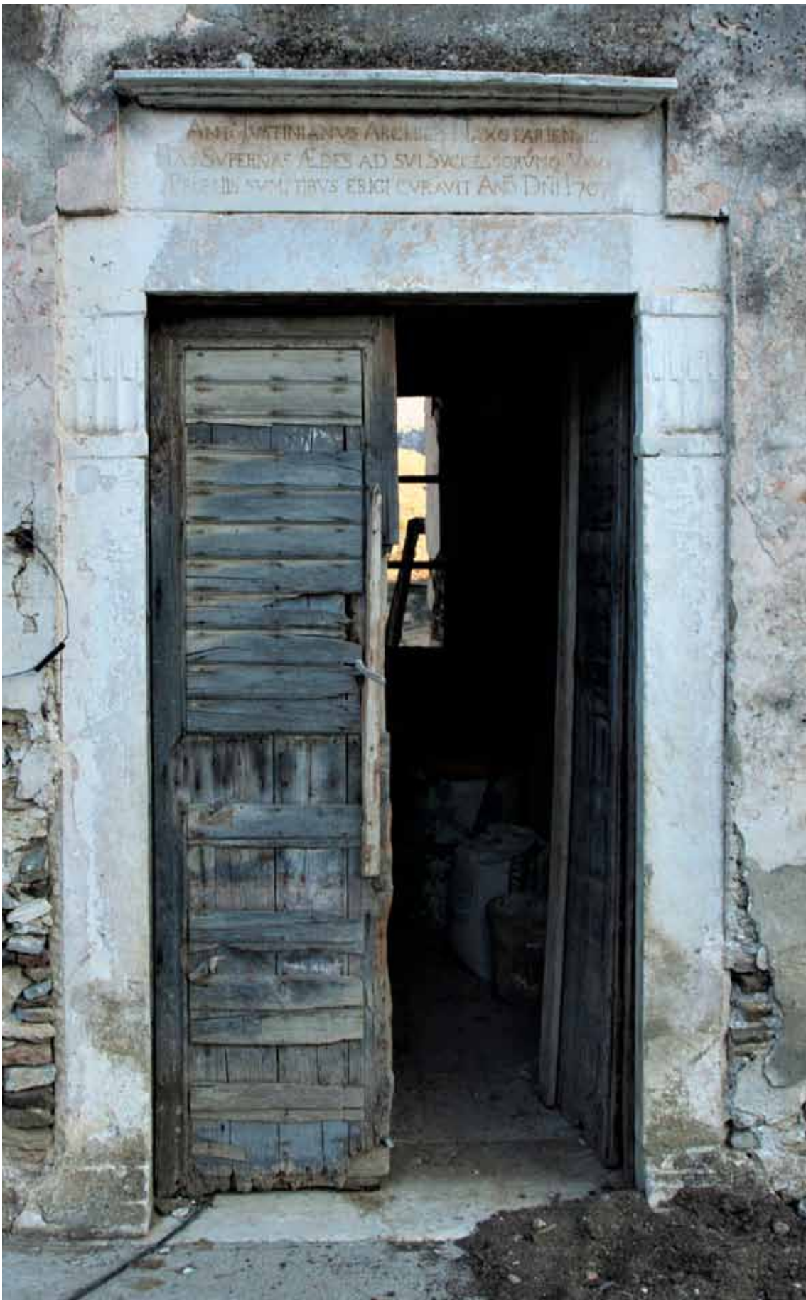
Φ.61. Η κεντρική θύρα της έπαυλης με το μαρμάρινο περιθύρωμα και την κτητική επιγραφή στο υπέρθυρο της
