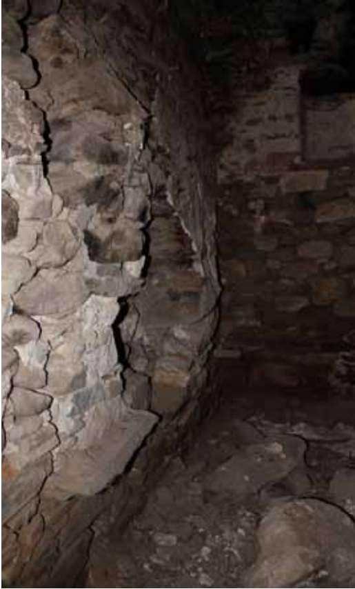
Φ.89. Ο νότιος τοίχος του χώρου 105 έχει παραμορφωθεί και έχει καταρρεύσει μέρος του.
