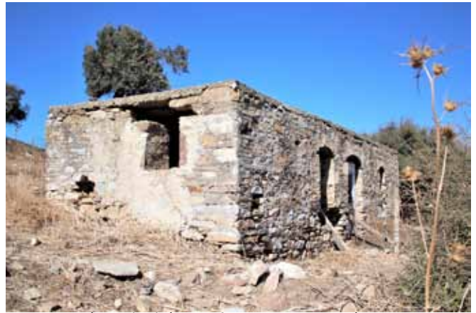
εικ. 65. Κτίσμα (Κ2) όπου πλέον χρησιμοποιείται ως στάβλος
