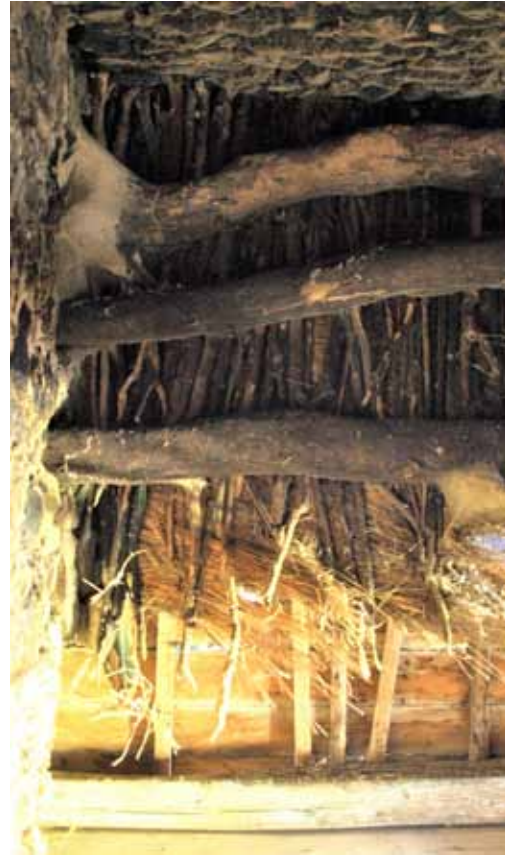
Φ.96. Κάτω απο το νεώτερο πάτωμα διακρίνεται η παλαιά κατασκευή της οροφής του δώματος.
