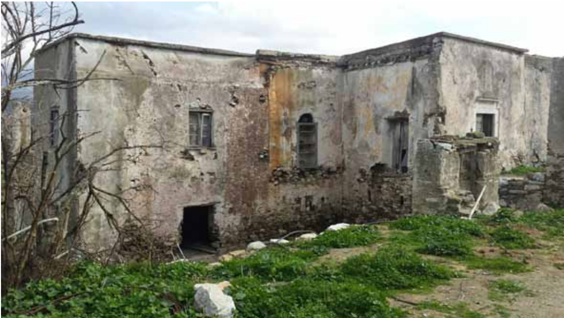
Φ.49. Δυτική όψη της έπαυλης. Διακρίνονται οι δοκοθήκες του πατώματος και της οροφής, όπως επίσης και το ερμάριο με την θύρα που έχουν εμφανιστεί στην όψη, μετά την κατάρρευση τμήματος του ορόφου (μαγειρείο)
