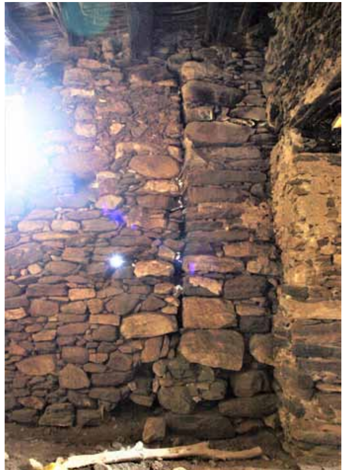
εικ. 36. Κατασκευαστικός αρμός στον χώρο 108 του ισογείου όπου διακρίνεται η αρχική φάση Α
