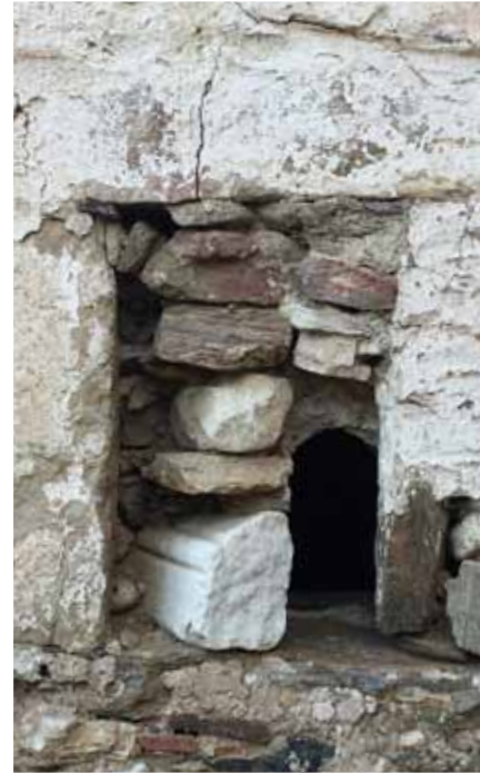
εικ 21. Παράθυρο που έχει μετατραπεί σε τυφεκιοθυρίδα (Τ.101) που βρίσκεται στον χώρο 104 του ισόγειου
