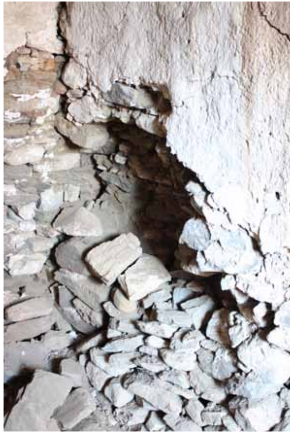
Φ.90. Άποψη του ίδιου τοίχου από τον χώρο 106 παρατηρούμε τη ανύπαρκτη σύνδεση με τον εγκάρσιο τοίχο.
