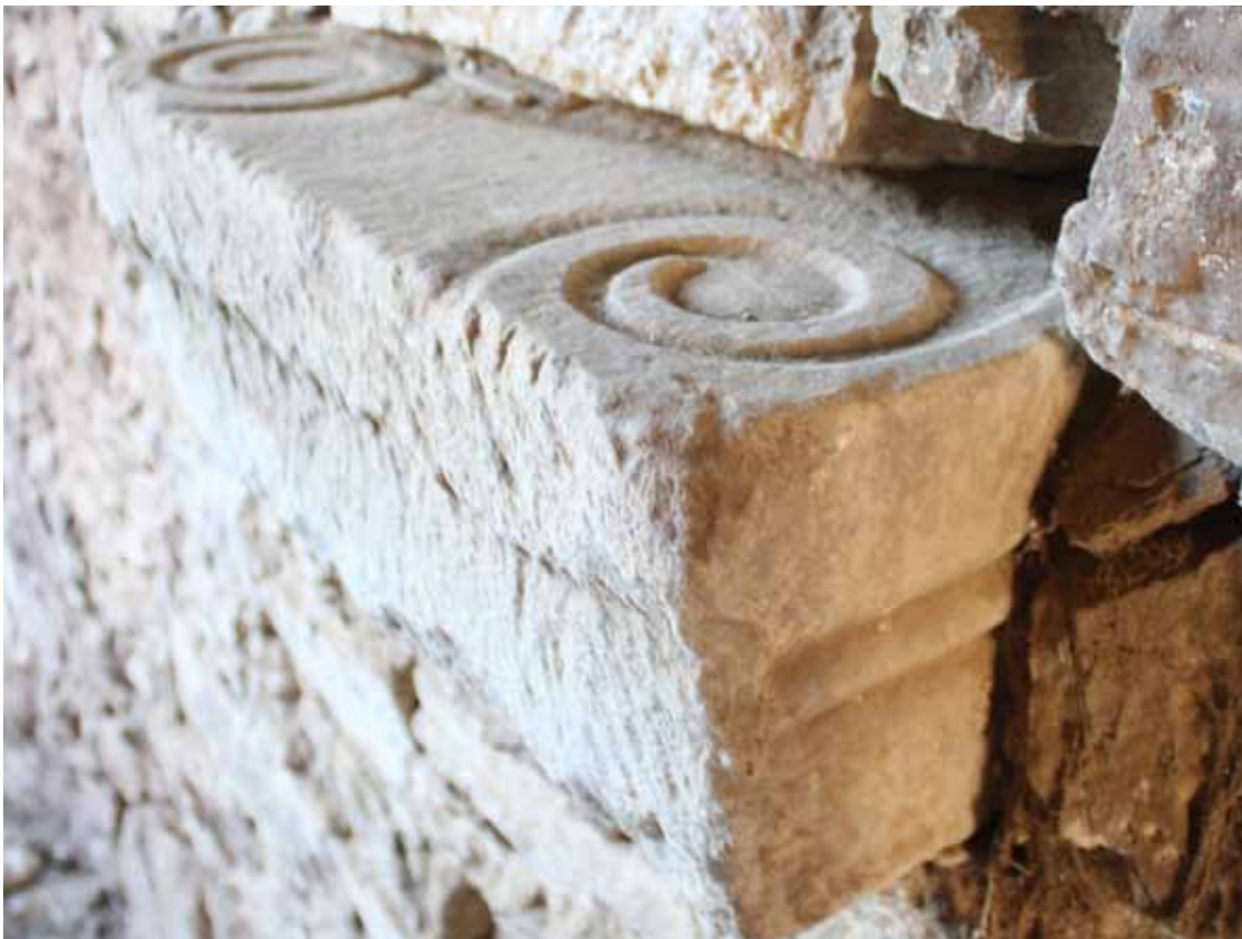
Φ.84. Αρχιτεκτονικό μέλος σε δεύτερη χρήση στην βάση τόξου στον χώρο 101 του ισογείου
