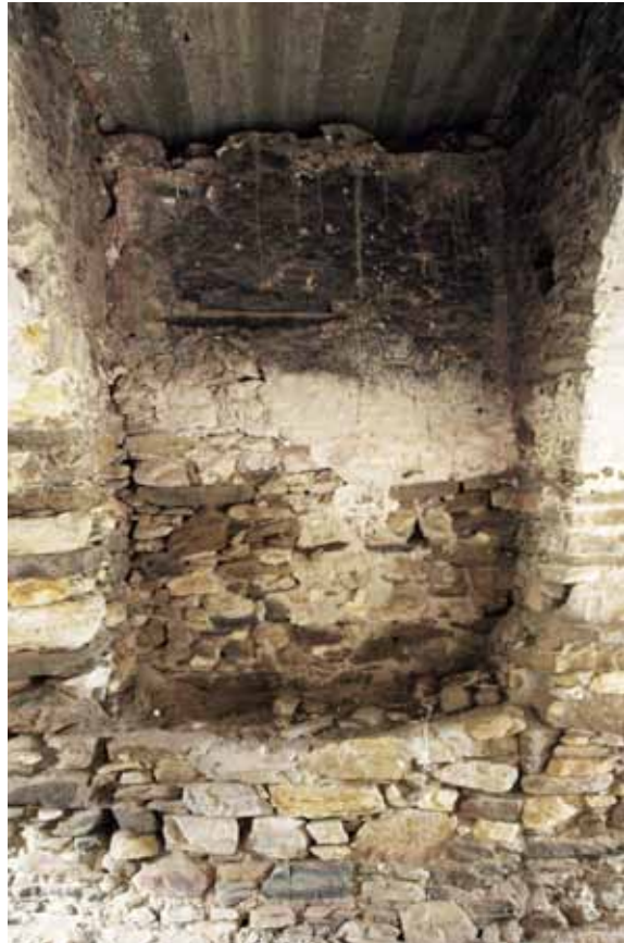
Φ.86. Αριστερά, στον βόρειο τοίχο της στοάς, διακρίνεται δίπλα στο τόξο ο κατασκευαστικός αρμός όπου βοήθησε στην επίλυση των κατασκευαστικών φάσεων
