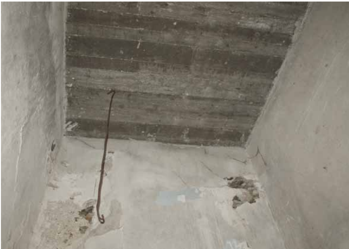
Φ.64. Διακρίνεται στον χώρο 201 η οροφή από εμφανές σπλισμένο σκυρόδεμα.
