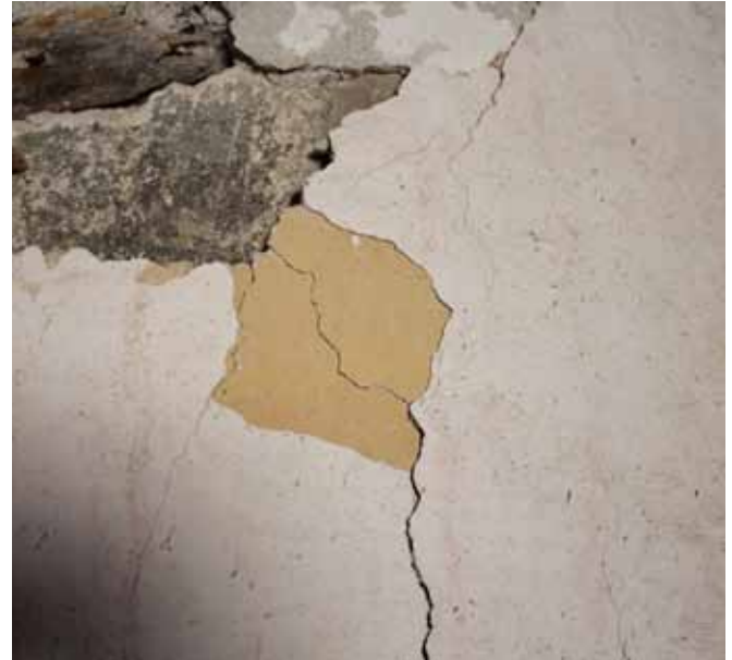
εικ. 24 Σημειωτική εμφάνιση αρχικού χρώματος (ώχρα) στον χώρο 102 του ισόγειου
