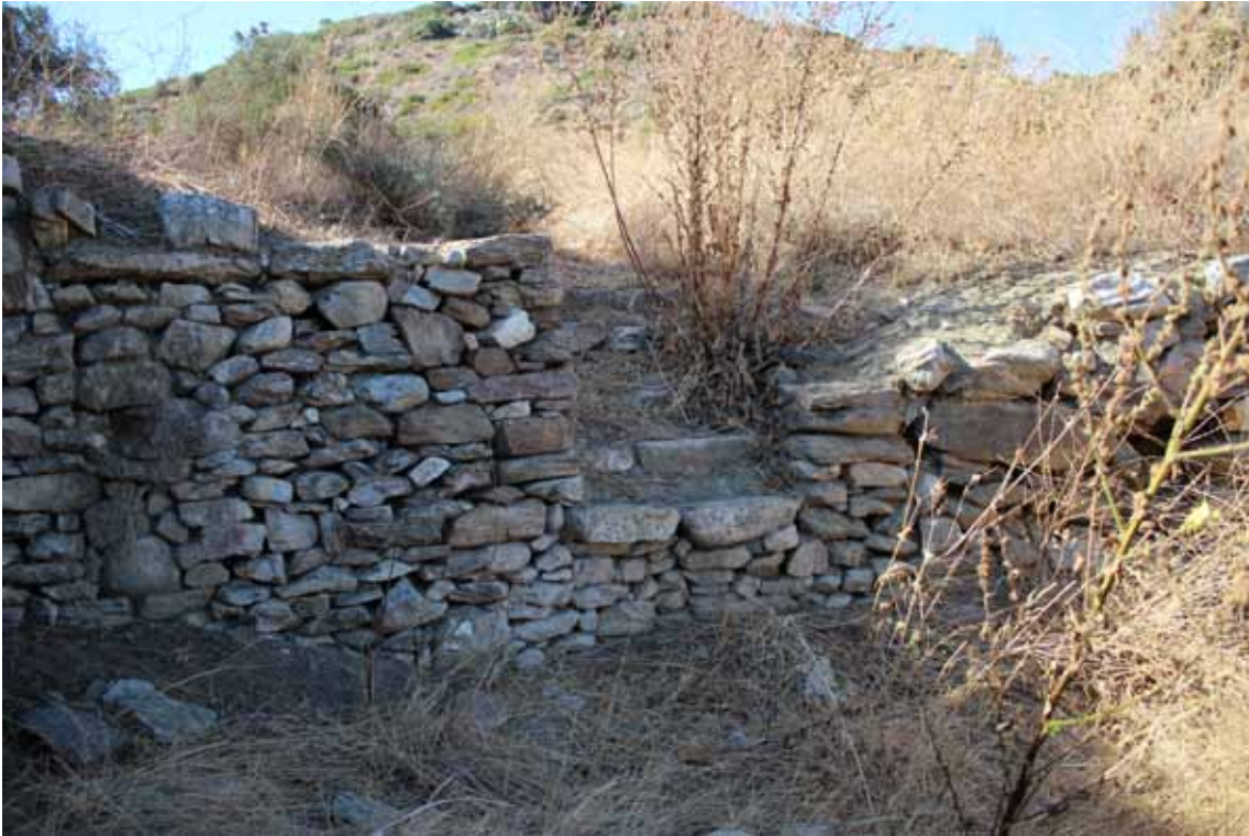
Φ.31. Άποψη των κλιμάκων διαμορφωμένες στο εσωτερικό των αναβαθμών. Αριστερά διακρίνεατι η κατάληξη του υδράυλακα
