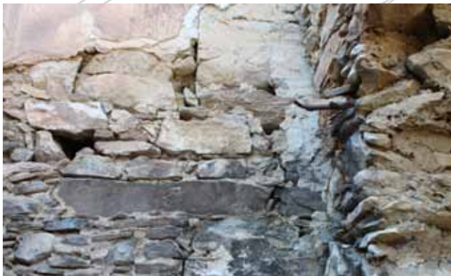
εικ. 42. Κατασκευαστικός αρμός της νοτιοανατολικής γωνίας της πορηγούμενης Ε φάσης
