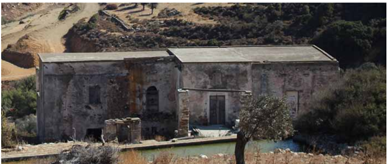
εικ. 44. Δυτική όψη του κτιρίου όπου διακρίνεται η επικάλυψη από οπλισμένο σκυρόδεμα.
