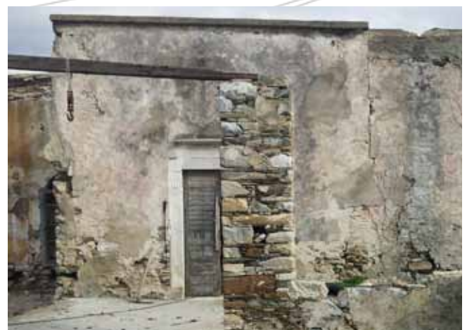
εικ. 41. Δυτική όψη όπου διακρίνεται ο κατασκευαστικός αρμός της πυργοειδής προσθήκης της Ε φάσης
