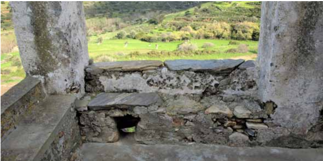
Φ.81. Τα λίθινα καθίσματα και μία απο τις υδρορρόες για την αποροή των ομβρίων υδάτων
