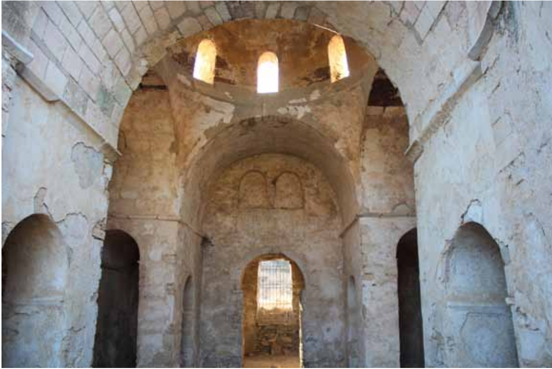
Φ.42. Άποψη από το εσωτερικό του ναού
