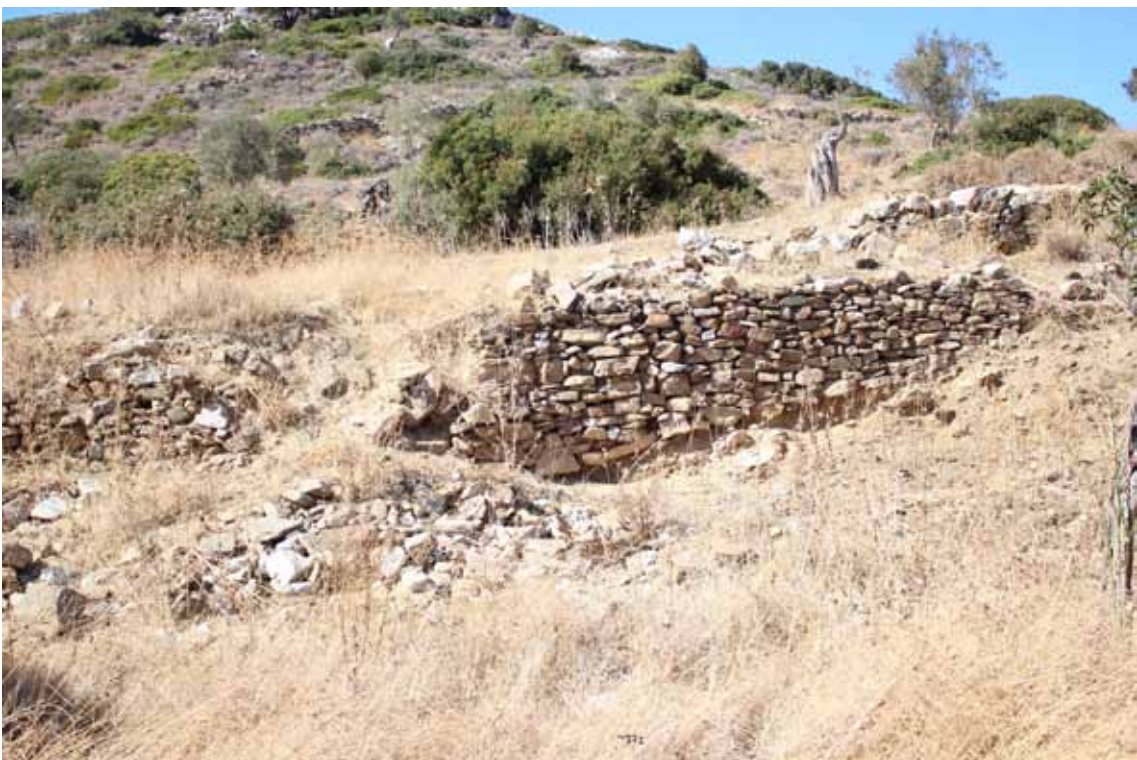
Φ.28. Άποψη των κατεστραμένων αναβαθμών.
