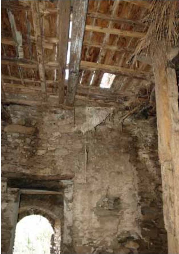
Φ.95. Ο χώρος 105 όπου διακρίνεται νεώτερο πάτωμα του ορόφου που είναι υπό κατάρρευση.
