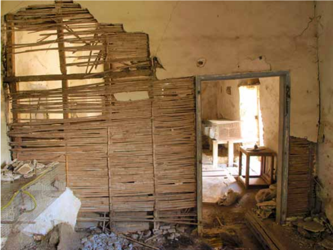
Φ.74. Στον χώρο 205 διακρίνεται το μεταγενέστερο μεσοχώρισμα απο παγδατί όπου παρατηρείται η αποκόλλησι μεγάλου τμήματος του επιχρίσματος και βρίσκεται σε κακή κατάσταση
