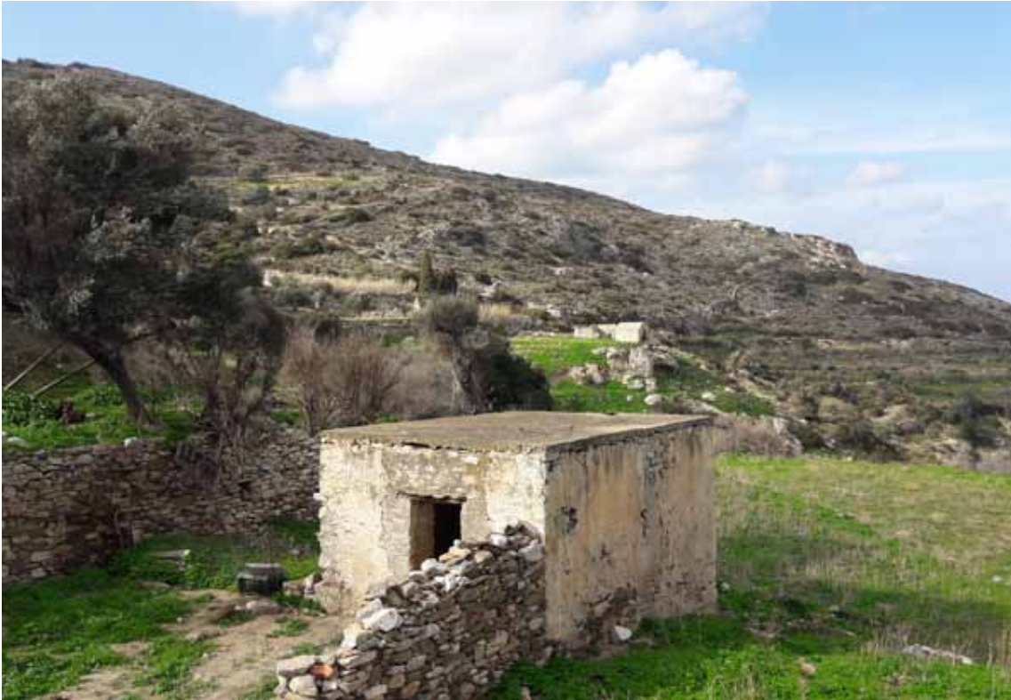
Φ. 19. Ο περιστεριώνας. Έχει αντικατασταθεί το δώμα με πλάκα από οπλισμένο σκυρόδεμα
