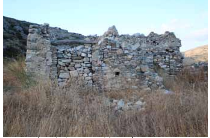
εικ. 64. Κτίσμα (Κ1) σε ερειπιώδη κατάσταση
