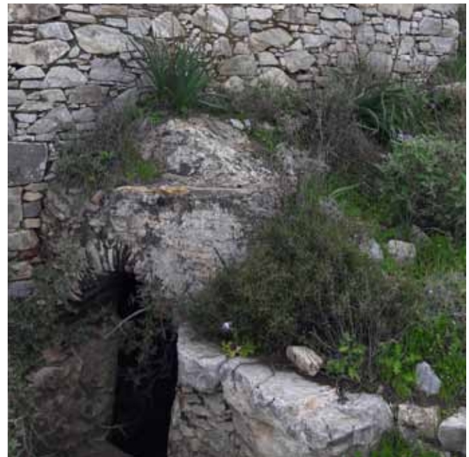
εικ. 62. Το καμαρωσκέπαστο κτίσμα της πηγής ακριβώς κάτω από την εξωτερική κεντρική Πύλη.
