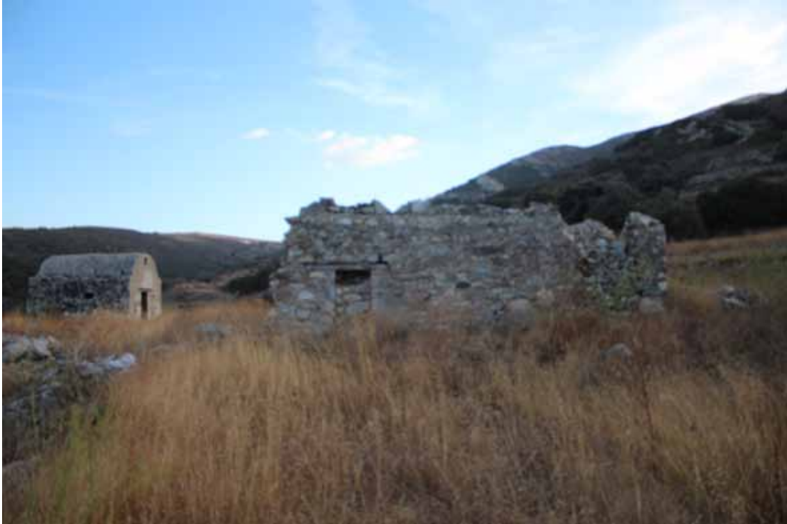
Φ.22. Η βόρεια όψη του κτίσματος Κ1 στο όριο της ιδιοκτησίας
