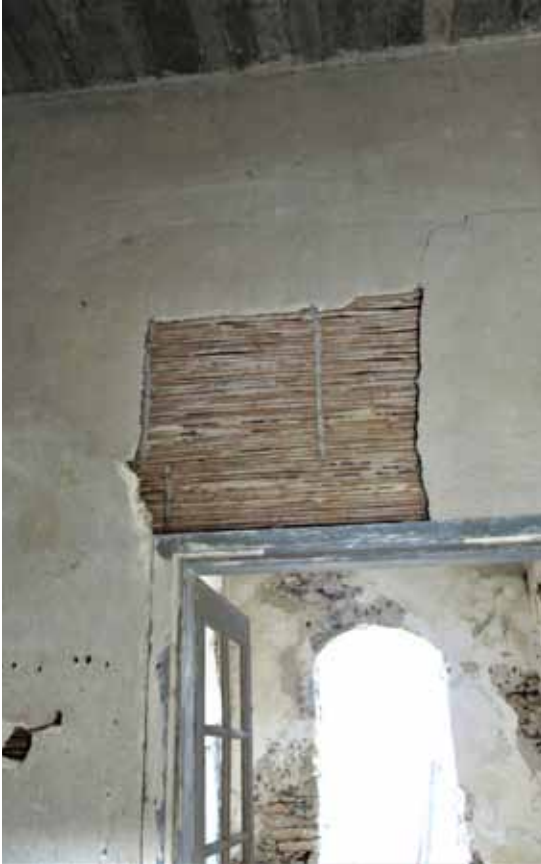
Φ.62. Στον χώρο 201 του ορόφου διακρίνεται η αποκόλληση τμήματος του επιχρίσματος στο μεσοχώρισμα απο παγδατί
