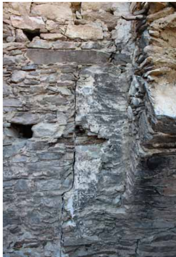
Φ.88. Επίσης διακρίνεται ο κατασκευαστικός αρμός, που συνεχίζει μέχρι και τον όροφο, της προσθήκης της τοξωτής στοάς όπου βοήθησε στην επίλυση των κατασκευαστικών φάσεων
