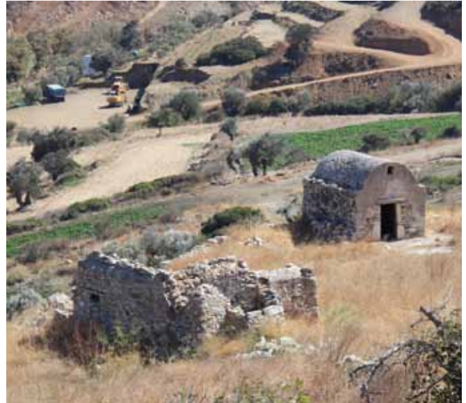
εικ. 32 Το κτίριο Κ1 και ο μονόχωρος ναός του Αγίου Μάμα. Στο βάθος φαινονται οι εργασίες για το νέο φράγμα στην περιοχή.
