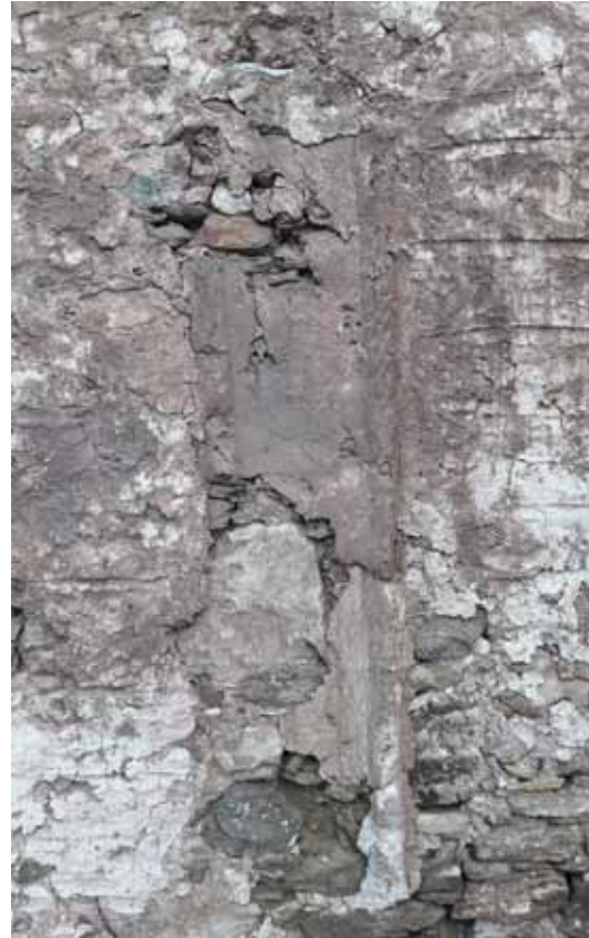
Φ.59. Στην δυτική όψη σώζεται τμήμα της παλαιάς υδρορρόης διαμορφωμένη με τραβηγτό αυλάκι από επίχρισμα
