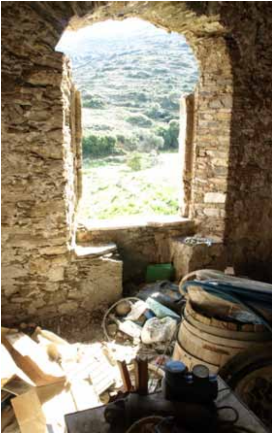
Φ.65. Στον χώρο 202 του ορόφου διακρίνεται το παράθυρο Π_201 όπου έχει καταρρεύσει το τύμπανο του τόξου
