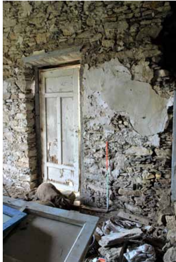
Φ.66. Ο χώρος 202 ήταν επιχρισμένος. Πλέον όλα τα επιχρίσματα έχουν αποξηλωθεί (εκτός μικρού τμήματος)
