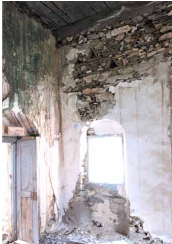
Φ.70. Άνωθεν του παραθύρου Π_203 παρατηρείται κατασκευή στην τοιχοποιία που θυμίζει περιστεριώνα
