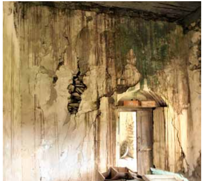
εικ. 58. Βόρειος τοίχος του χώρου 203 όπου φαίνεται η αποδιοργάνωσή του.
