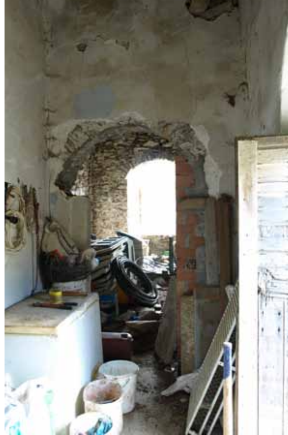
Φ.63. Στον χώρο 201 το άνοιγμα της θύρας Θ_202 έχει αλλοιωθεί και η μία παρειά έχει διαμορφωθεί με οπτόπλινθους.
