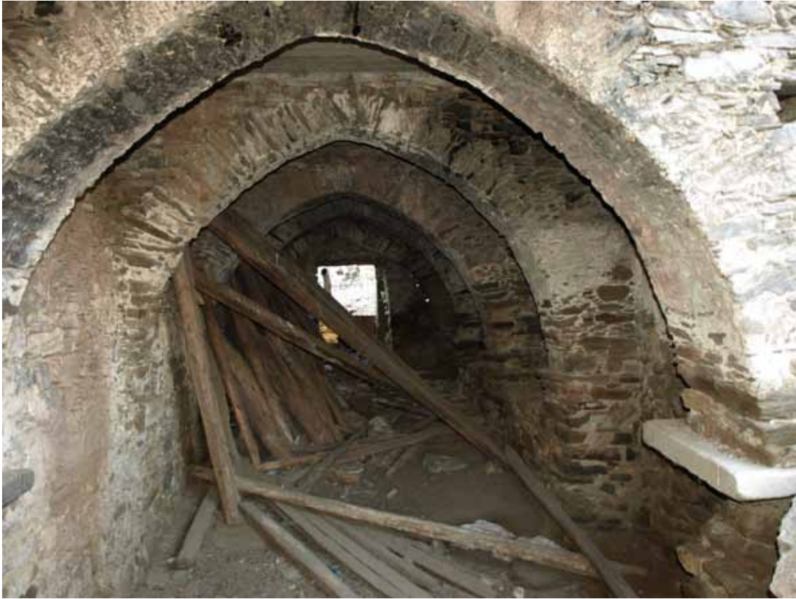
Φ.83. Άποψη του χώρου 101 (στοά) διαμορφωμένη με οξυκόρυφα τόξα όπου σχεδόν όλα εδράζουν σε μαρμάρινες βάσεις (spolia)
