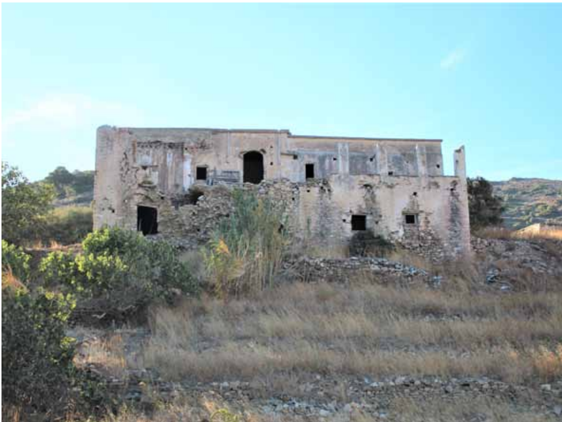
Φ.50. Νότια όψη της έπαυλης. Διακρίνεται η αντικατάσταση της οροφής από οπλισμένο σκυρόδεμα
