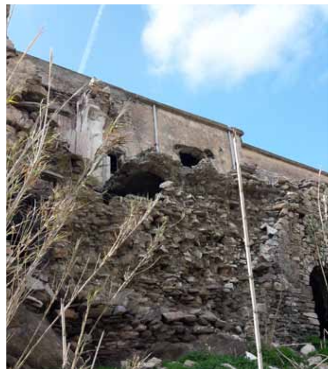
εικ. 46. Ανατολική όψη όπου φαίνεται η κατάρρευση κυρίως της εξωτερικής παρειάς του τοίχου
