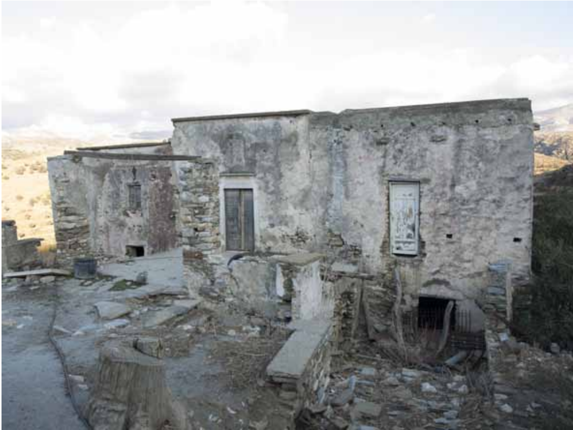
Φ.48. Δυτική όψη της έπαυλης. Διακρίνεται η είσοδος προς το ισόγειο καθώς και οι λίθινες προεξοχές τις παλαιού δώματος για την απομάκρυνση των ομβρίων υδάτων
