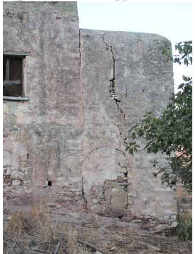
εικ. 43. Νότια όψη όπου φαίνεται ο κατασκευαστικός αρμός της προσθήκης του παρεκκλησίου.
