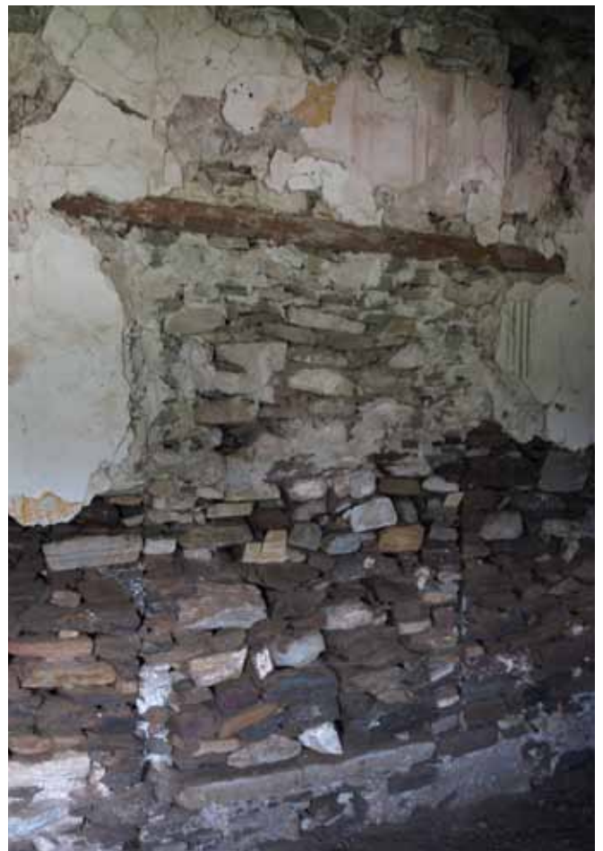
εικ. 37. Αρχική θύρα (Θ_108) της Α φάσης όπου έχει σφραγιστεί μετά την επίχωση του χώρου 103
