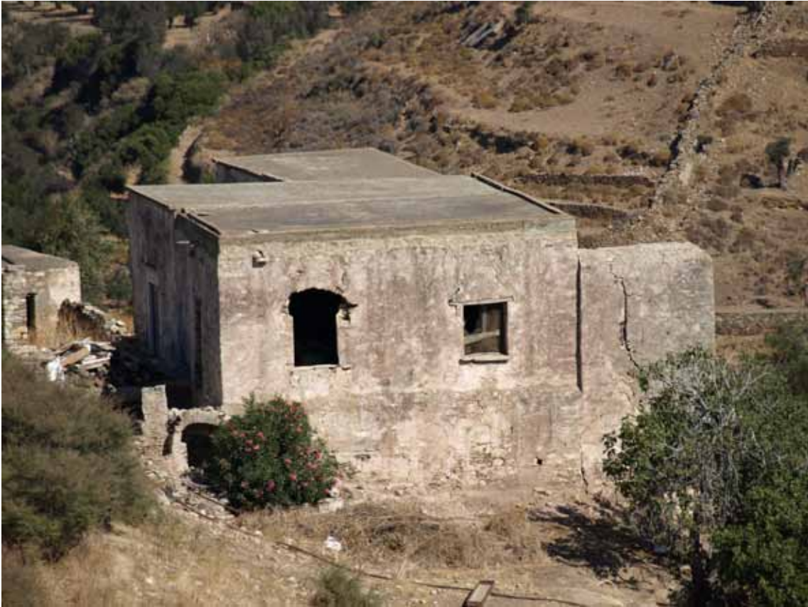
Φ.50. Νότια όψη της έπαυλης. Διακρίνεται η αντικατάσταση της οροφής από οπλισμένο σκυρόδεμα
