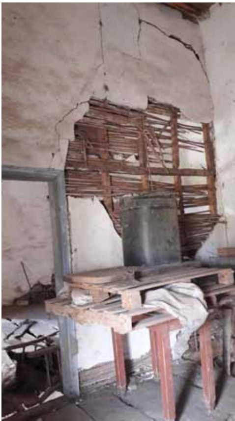
Φ.78. Αποψη του μεσοχωρίσματος απο τον χώρο 206
