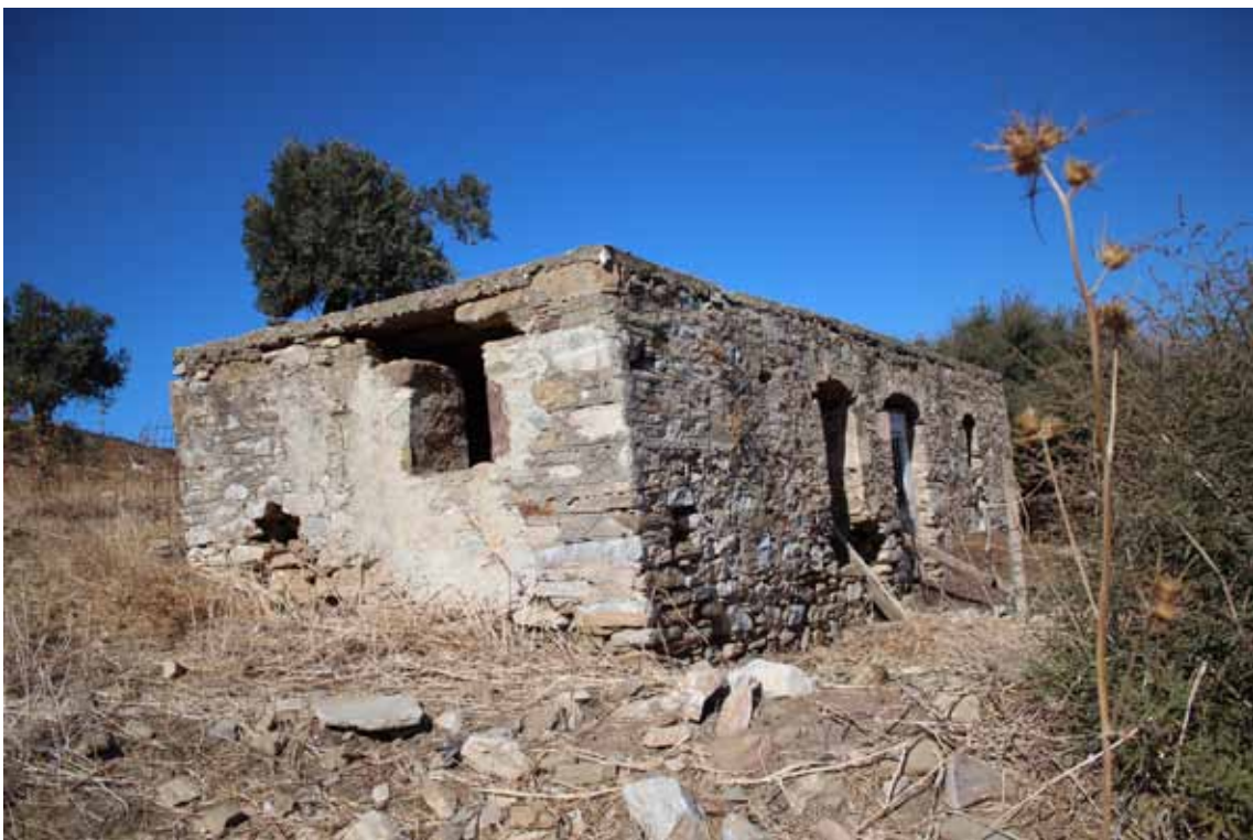
Φ.24. Η νότια όψη του στάβλου (Κ2). Έχει καταρρεύσει το πρέκι του παραθύρου. Έχει αντικατασταθεί το δώμα απο πλάκα με ΟΣ
