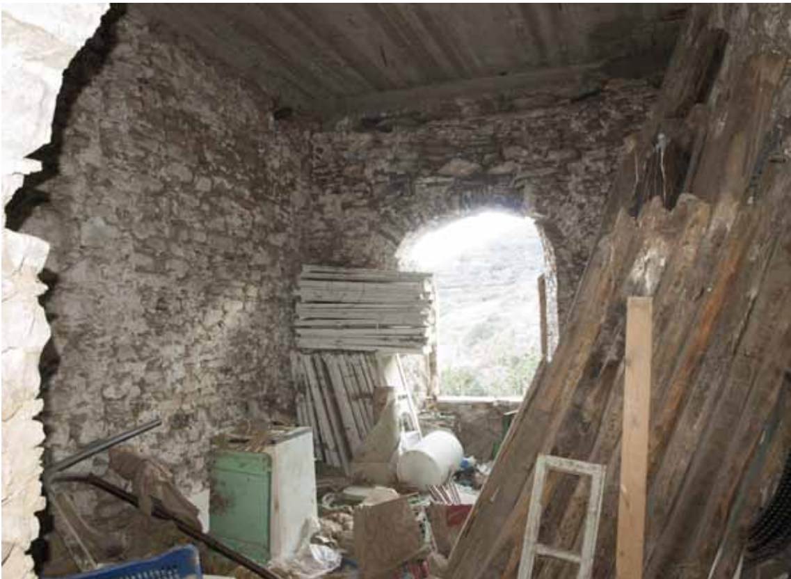
Φ.67. Ο χώρος 202 πριν τον καθαρισμό του από τους υπαλλήλους της ΕΦ.Α. Κυκλάδων. Επίσης διακρίνεται η αντικατάσταση της οροφής από εμφανές οπλισμένο σκυρόδεμα
