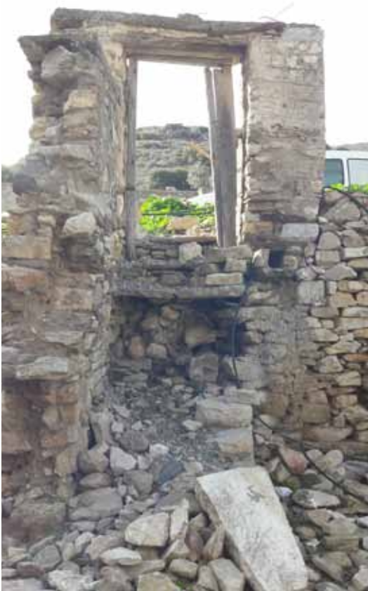
Φ.58. Μικρή λίθινη εξωτερική θύρα με λιθινή κλίμακα η οποία έχει καταρρεύσει που οδηγούσε στο ισόγειο
