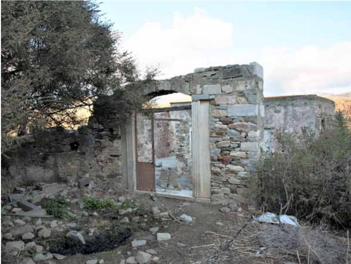
Φ.46 . Πύλη δίπλα στην δεξαμενή που οδηγεί στην έπαυλη
