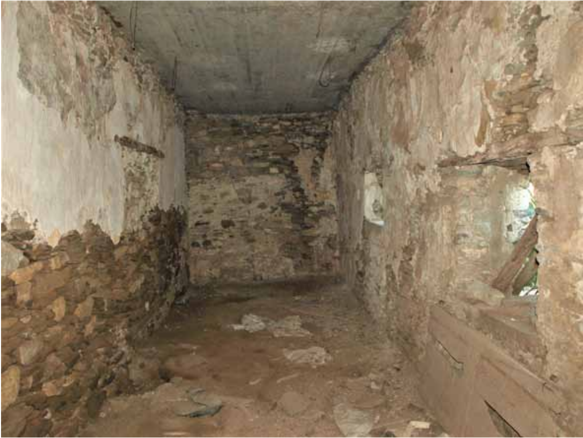
Φ.93. Ο χώρος 102 όπου αριστερά διακρίνεται η φραγμένη θύρα Θ_108. Σύμφωνα με την ανάλυση των φάσεων πρόκειται για την αρχική θύρα της πρώτης φάσης του κτιρίου
