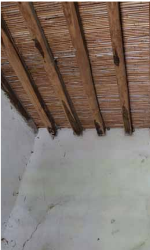
Φ.75. Η οροφή του χώρου 205 κάτω απο το οπλισμένο σκυρόδεμα είναι με ξύλινες δοκίδες και καλάμια
