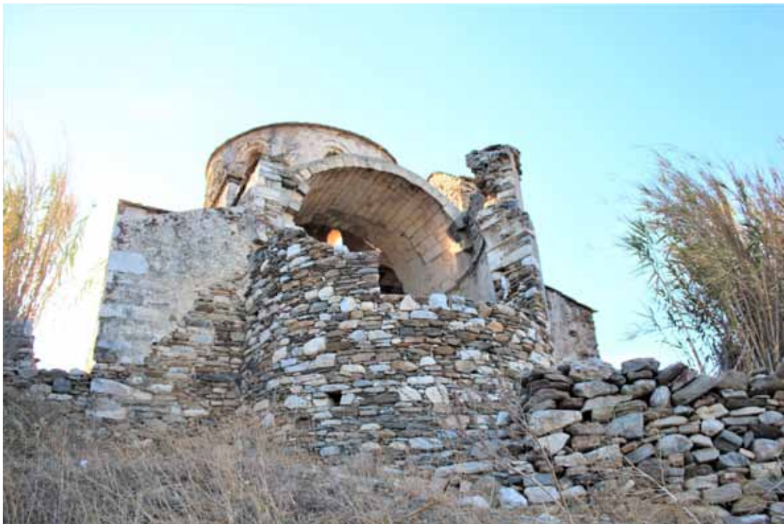
Φ.41. Η ανατολική όψη του ναού. Έχει καταρρεύσει η οροφή και τμήμα της τοιχοποιίας του ιερού.
