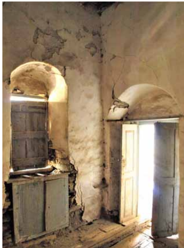
Φ.76. Η αρχική θύρα Θ_209 και το παράθυρο Π_204 με το διαμορφωμένο ξύλινο ερμάριο στο κατω μέρος του
