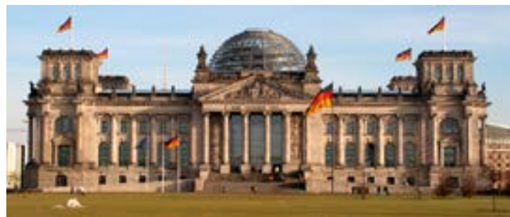
Κτίριο του Γερμανικού Κοινοβουλίου, Βερολίνο
