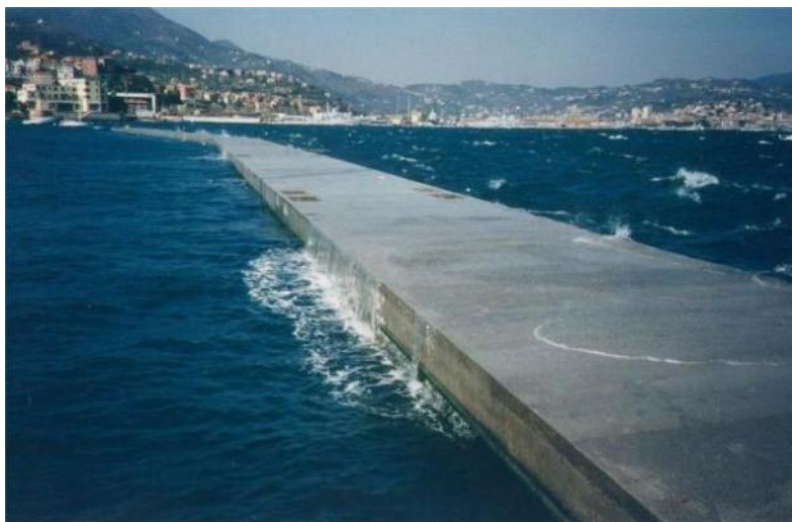
Εικόνα 8.6: Πλωτός κυματοθραύστης, Fezzano, Ιταλία
