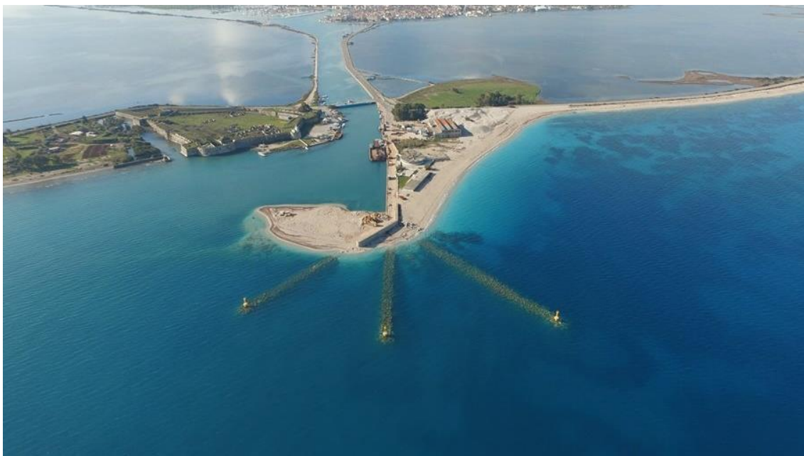
Εικόνα 8.8: Η είσοδος του Διαύλου Λευκάδας μετά την ολοκλήρωση των έργων «Διαπλάτυνση Διαύλου Λευκάδας». Διακρίνονται οι τρεις ύφαλοι αντιπροσαμμωτικοί πρόβολοι και το εναπομείναν τμήμα της αμμόγλωσσας μετά τις εργασίες βυθοκορήσεων
