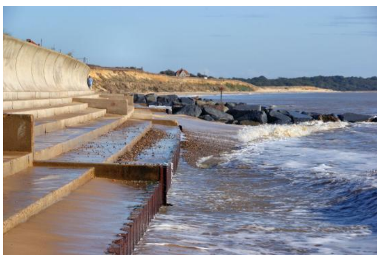
Εικόνα 8.3: Κρηπιδότοιχος με πασσαλοσανίδες, Γαλλία
