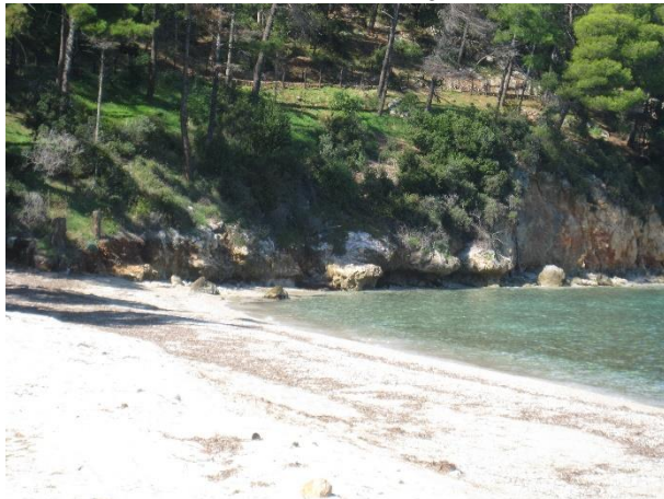
Εικόνα 4.4: Πλήρης διάβρωση της ακτής και υποχώρηση του τμήματος όπισθεν αυτής
