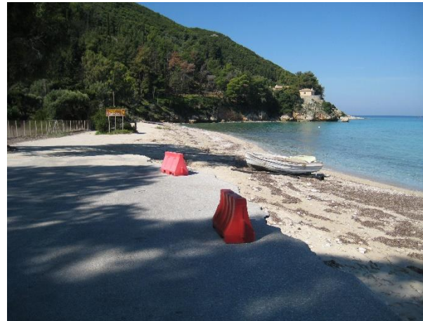
Εικόνα 4.2: Διάβρωση παραλιακής οδού
