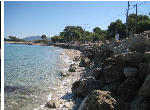
Εικόνα 4.6: Προστασία με Φ.Ο. διαβρωμένου τμήματος της ακτής
