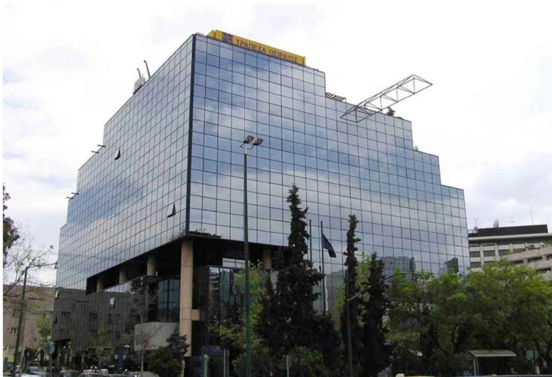
Σχήμα 34 Φωτογραφία Κτηρίου υπό Εξέταση
