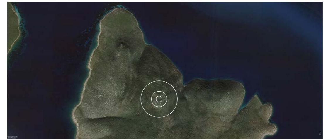
εικ.77_ παρατηρητήριο [Π08] στη θέση Βίγλα στη νήσο Σχίζα, αεροφωτογραφία google maps 2013
