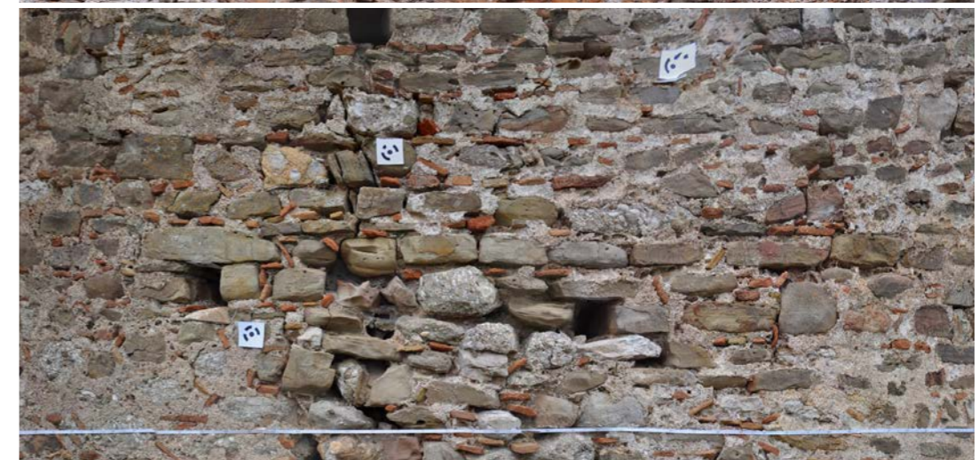
εικ.146_ άποψη πλίνθων σε σειρά στο εσωτερικό του πύργου (πάνω), άποψη λίθων σε σειρά στο εσωτερικό (μέση), άποψη λίθων σε σειρά στο εξωτερικό του πύργου (κάτω) [2017]
