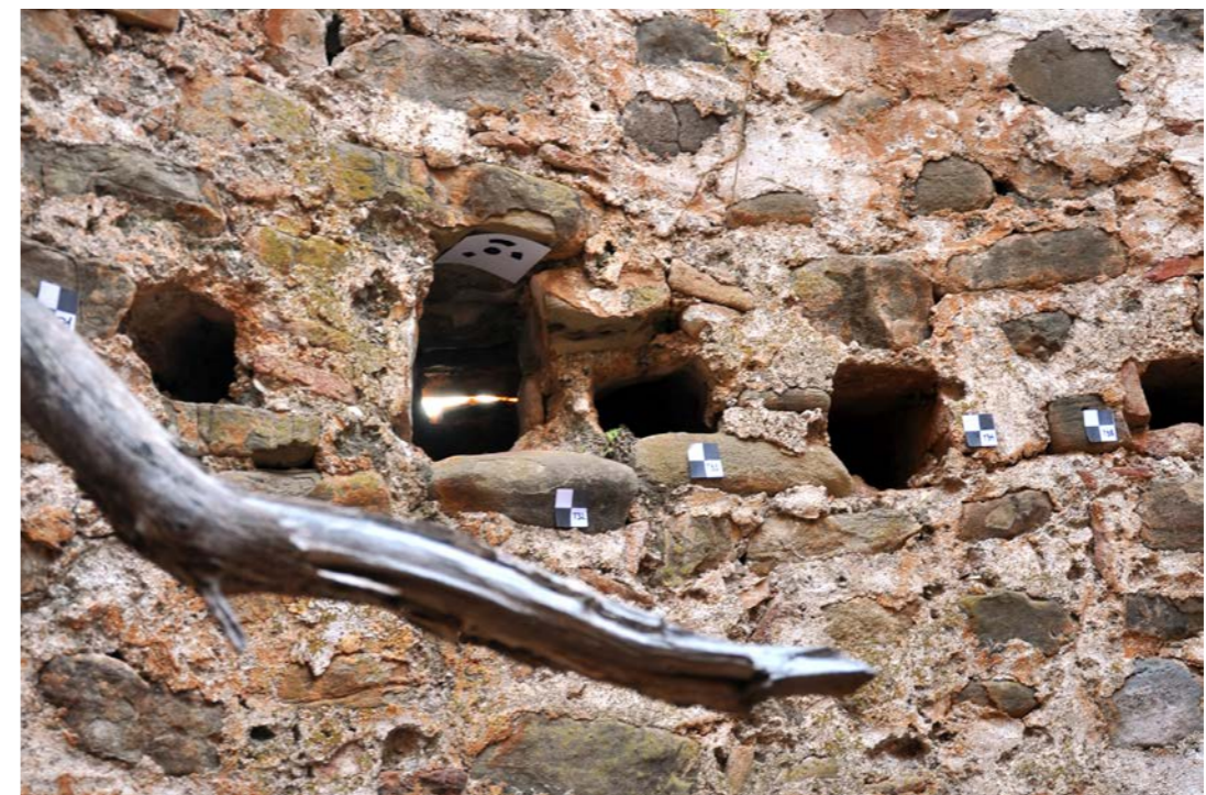
εικ.139_ φωτογραφίες οπών/ υποδοχών ξύλινων δοκών στην στάθμη +1.50 στο ανατολικό τμήμα του πύργου Π09
