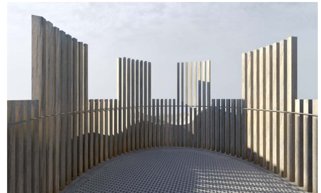
εικ.185_ Π09, άποψη από το δώμα, διακρίνεται το νέο παραπέτο διαμορφωμένο από ξύλινα κατακόρυφα στοιχεία (τρισδιάστατη απεικόνιση)
