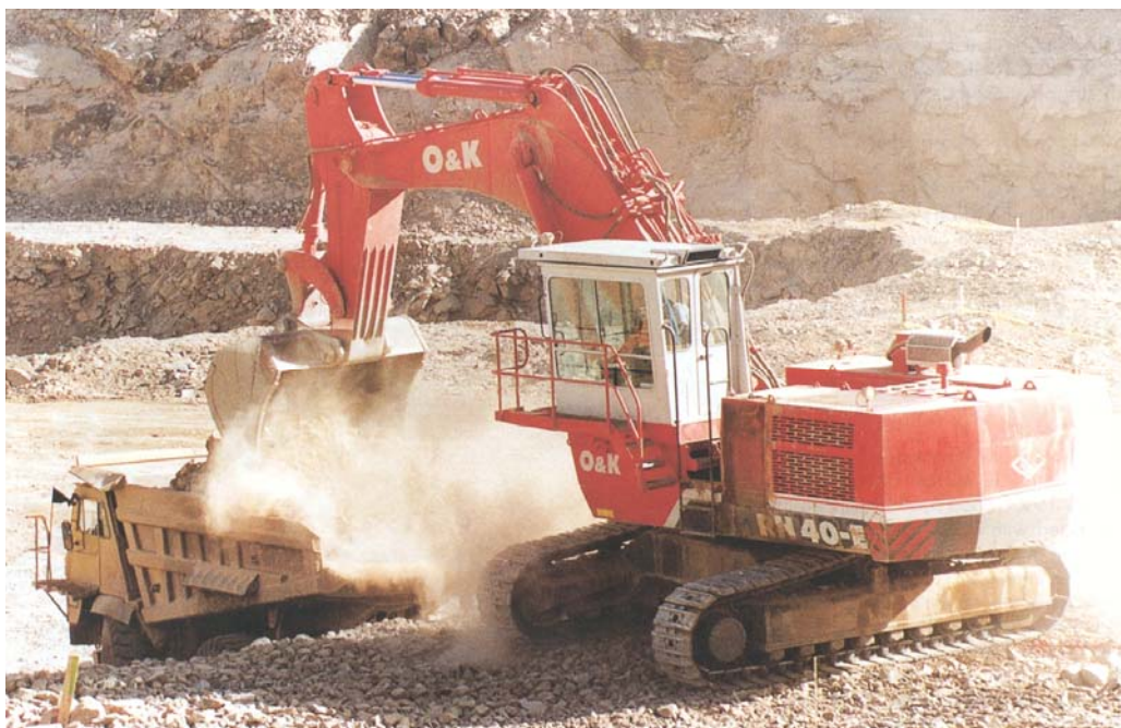
Εικόνα 5 - Υδραυλικός εκσκαφέας ανεστραμμένου κάδου
