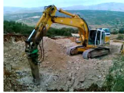
Εικόνα 4.6: Εκσκαφέας με ενσωματωμένο σφυρί
