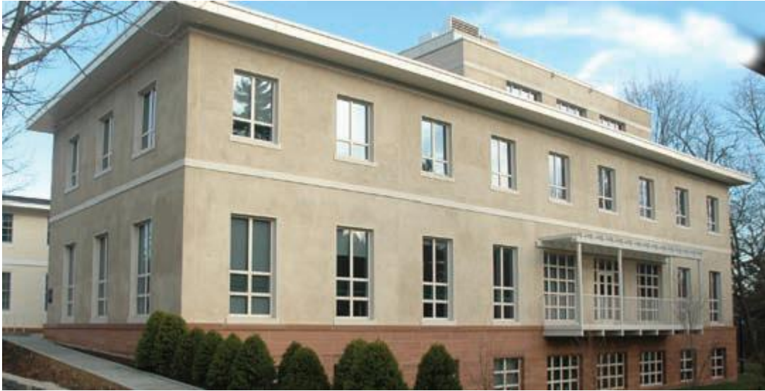
Εικόνα 6.3: Σχολείο κατασκευασμένο από AAC
