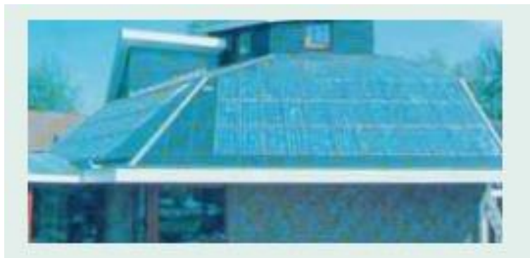
Εικόνα 5.11: Εγκατάσταση φωτοβολταϊκού συστήματος σε κτίριο (ΚΑΠΕ, 2016)
