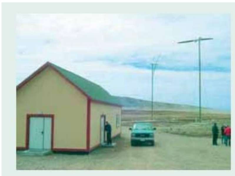
Εικόνα 5.12: Εγκατάσταση ανεμογεννητριών μικρής κλίμακας (ΚΑΠΕ, 2016)
