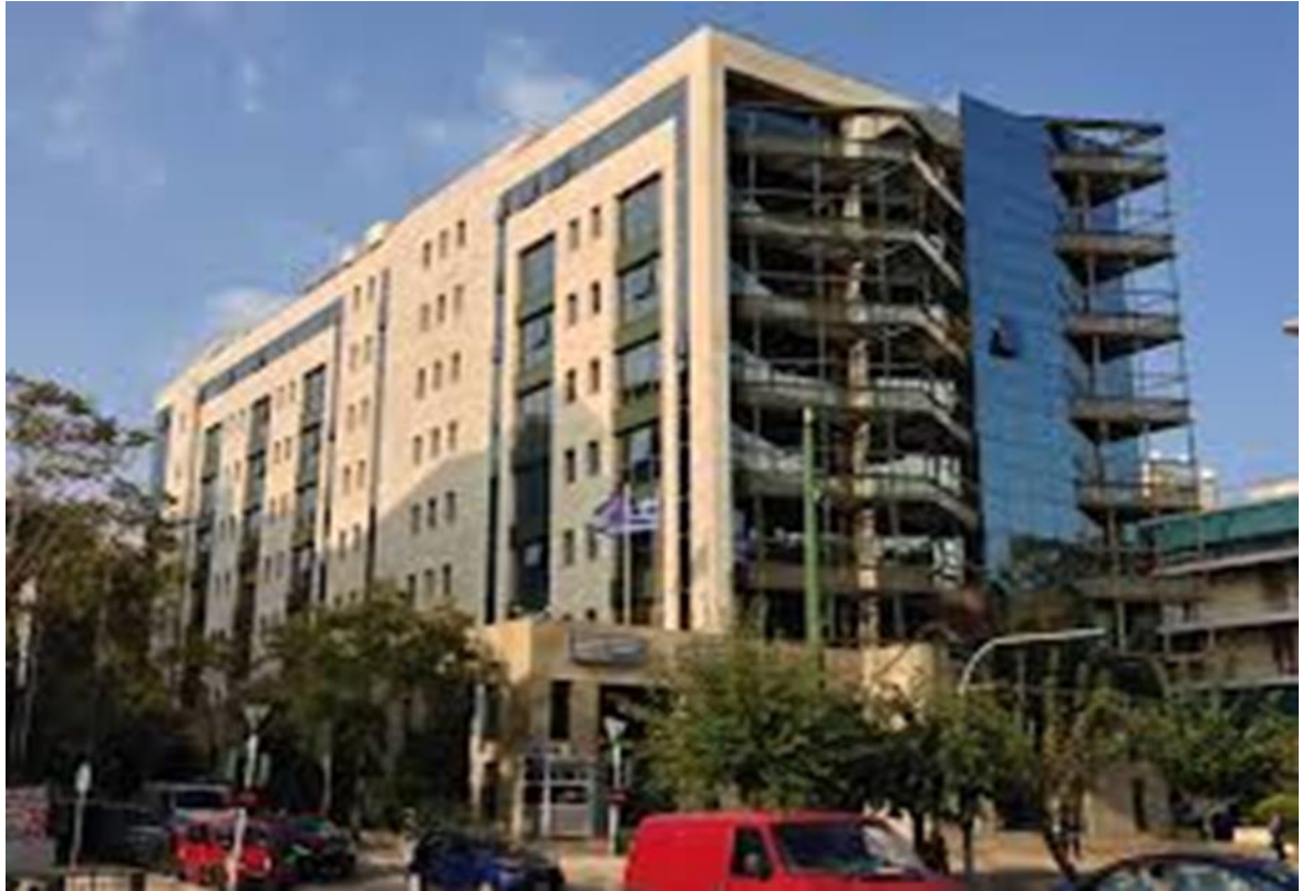
Εικόνα 3.3. Άποψη του κτιρίου από την Νοτιανατολική όψη
