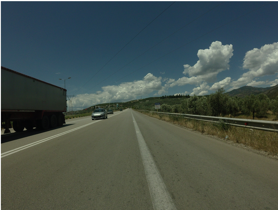
Σχήμα 4.12: Διατομή με Λωρίδα Πολλαπλών Χρήσεων (Λ.Π.Χ.).
