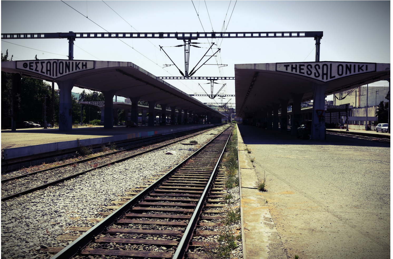
Πλατφόρμες, Νέος Σιδηροδρομικός Σταθμός Θεσσαλονίκης
