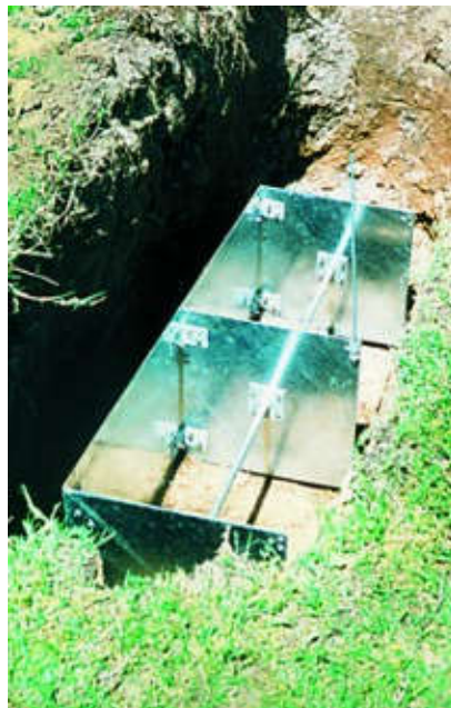
Εικόνα 2.1: Εγκατάσταση γειωτή τύπου “E”, εντός σκάμματος [25]
