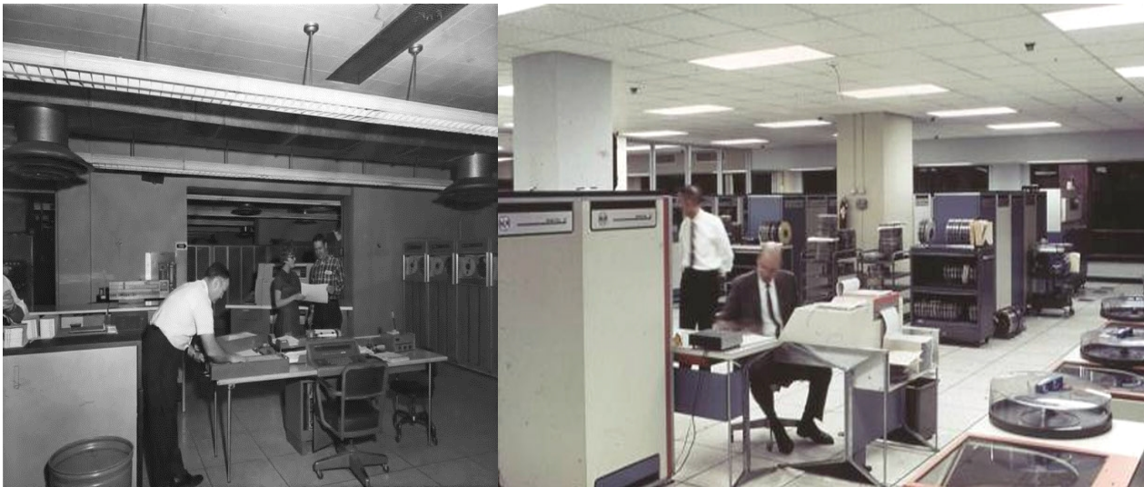
Figure 2.1: Τα πρώτα Data Center δεν αποτελούσαν «ειδικούς χώρους» για IT εξοπλισμό [1]
