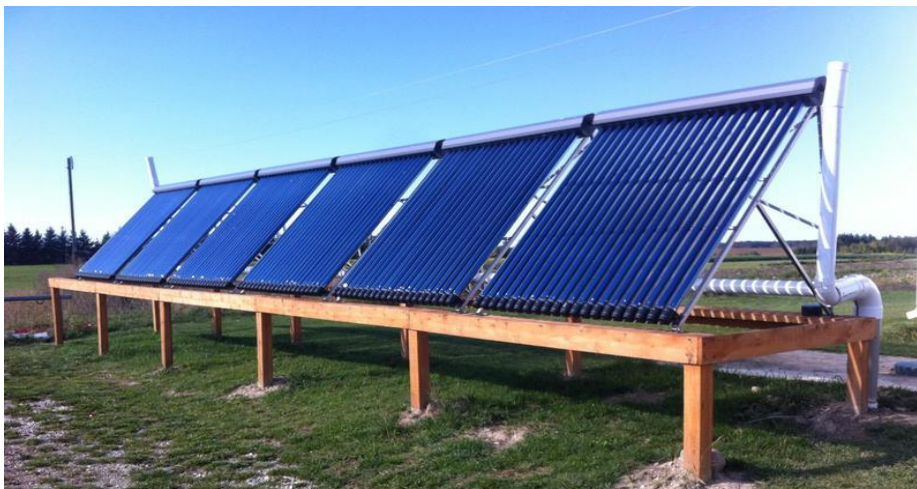
Εικόνα 2.12 Συλλέκτης με σωλήνες κενού (ETC) [2.21]
