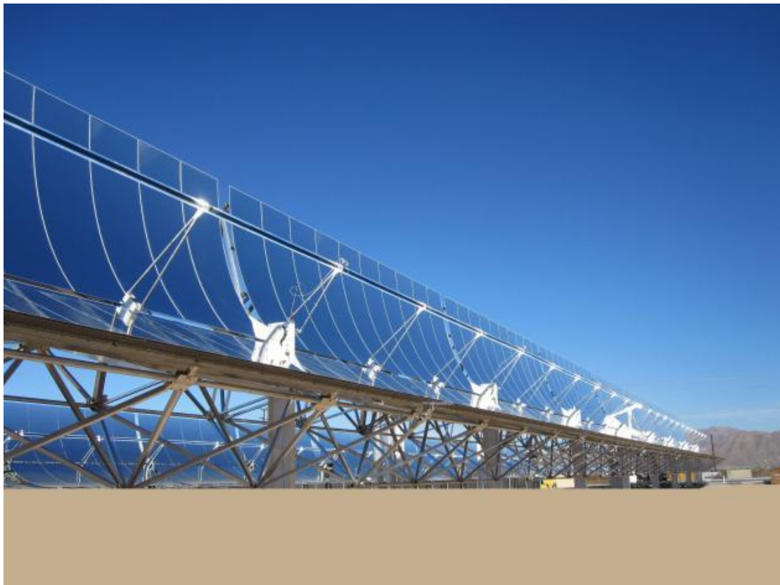
Εικόνα 2.16 Επιμήκης παραβολικός συλλέκτης (PTC) [2.26]
