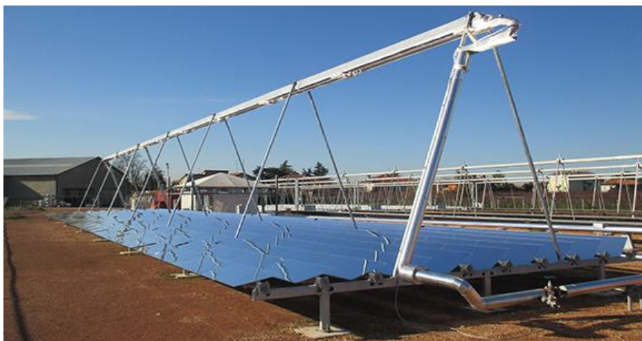
Εικόνα 2.17 Γραμμικός συλλέκτης Fresnel [2.28]
