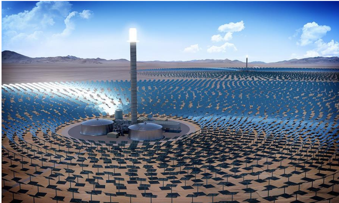
Εικόνα 2.19 Ηλιακός πύργος ή Κεντρικός δέκτης [2.31]
