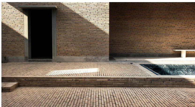
Εικόνα 27, Ahmedabad Residence, Studio Mumbai.
