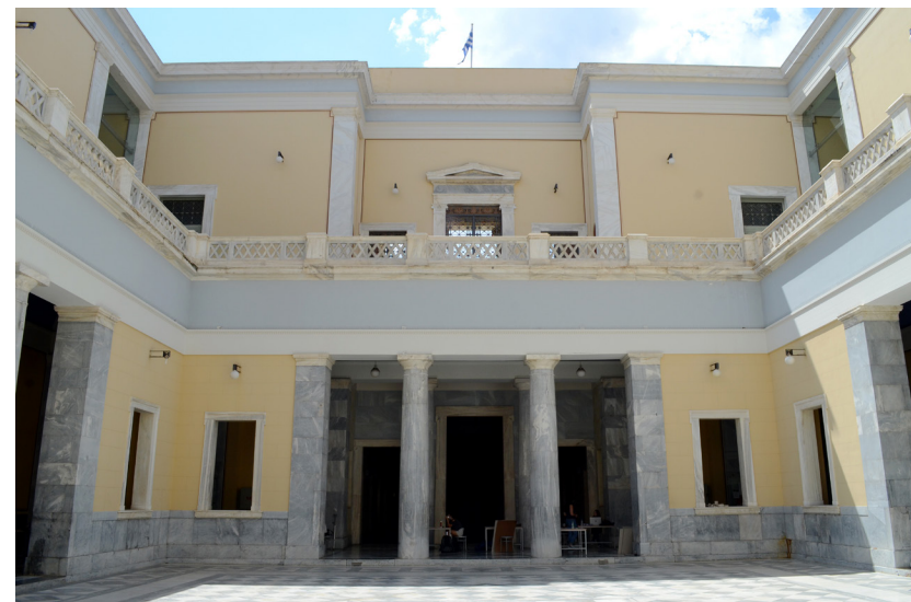
Εικόνα 56, Άποψη Αιθρίου κατά την είσοδο.
