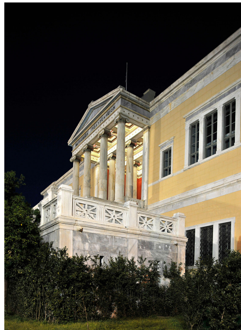
Εικόνα 53, Αποψη της Δυτικής όψης.
