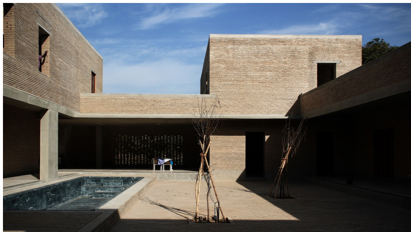
Εικόνα 26, Ahmedabad Residence, Studio Mumbai.
