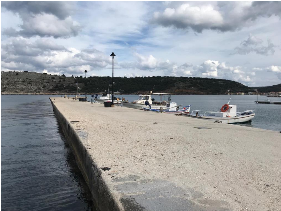
Άποψη λιμενικής εγκατάστασης σημείο γ.1
