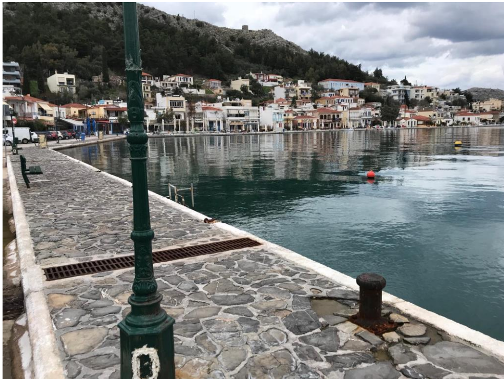
Άποψη λιμένα σημείο ζ.2
