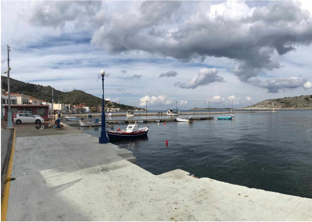
Άποψη λιμενικής εγκατάστασης σημείο δ.1
