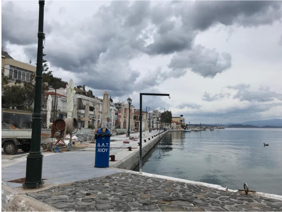
Άποψη λιμένα σημείο η.1
