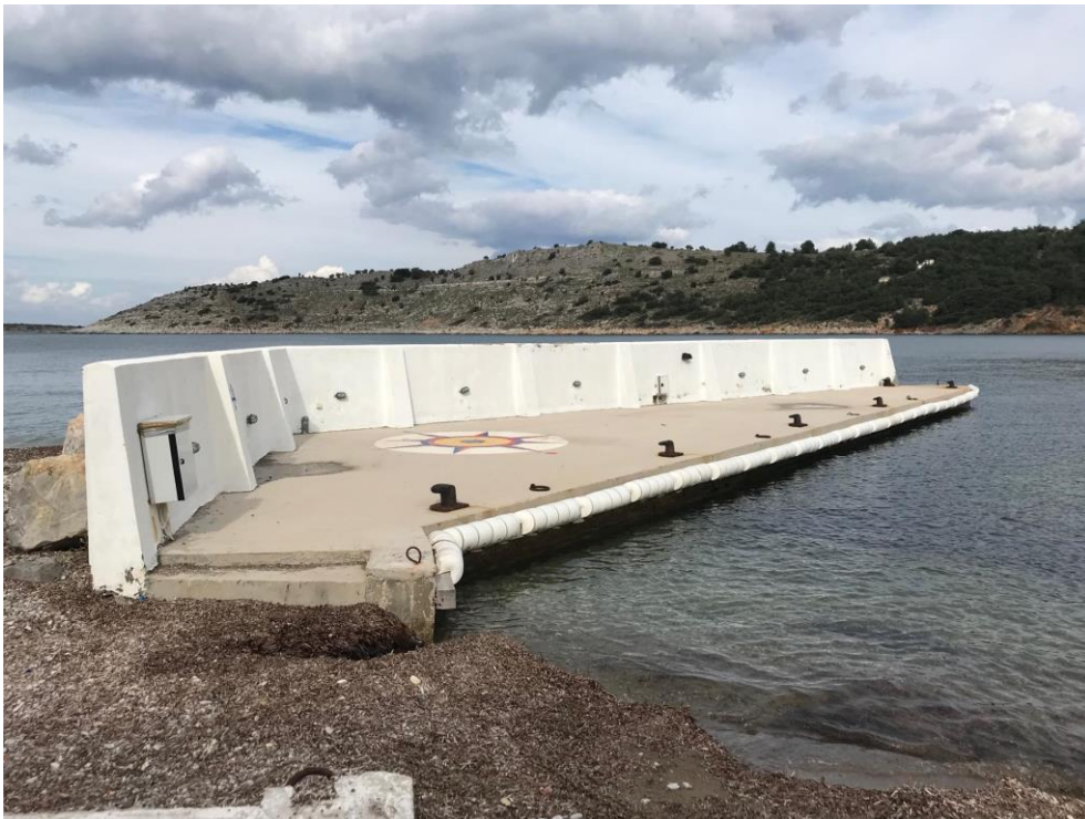
Άποψη λιμενικής εγκατάστασης σημείο ζ.1
