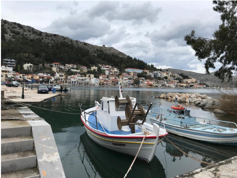
Άποψη λιμένα σημείο β.1
