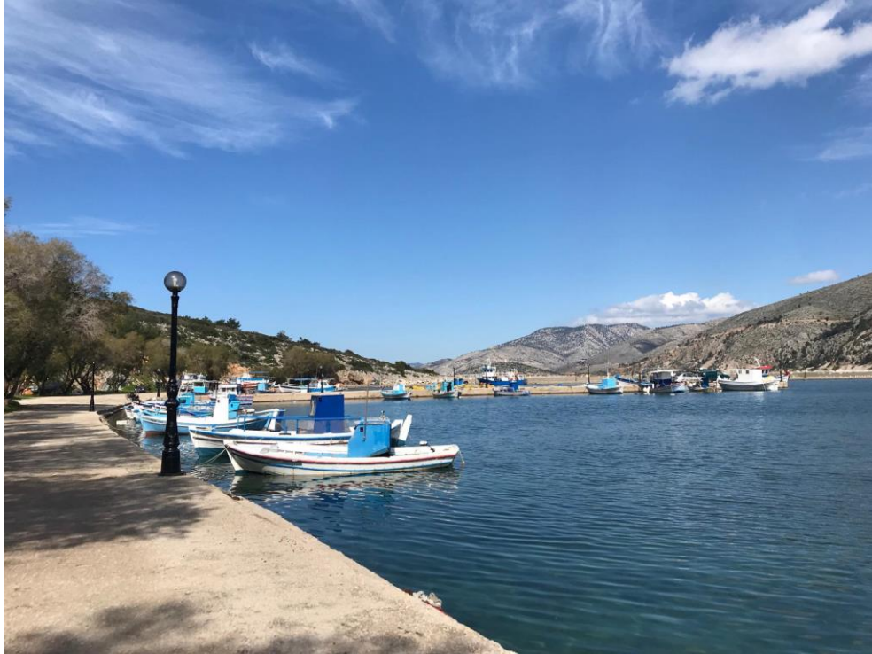
Άποψη λιμένα σημείο γ.1
