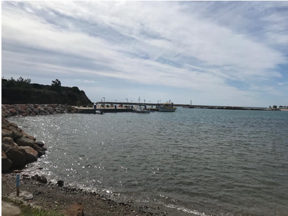
Άποψη λιμένα σημείο θ
