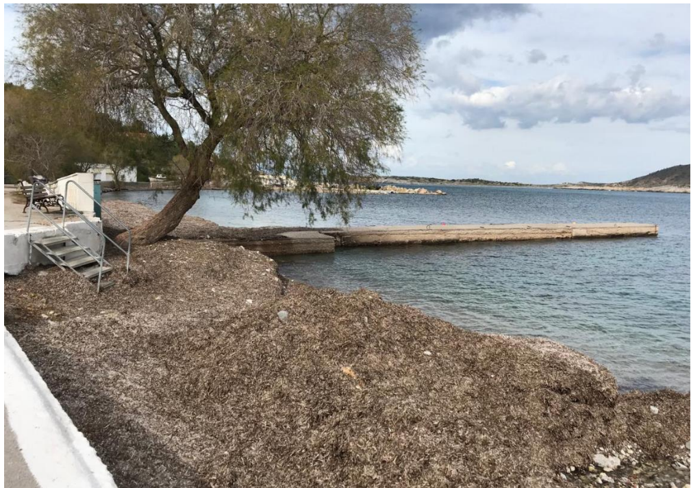
Άποψη λιμενικής εγκατάστασης σημείο ε.1
