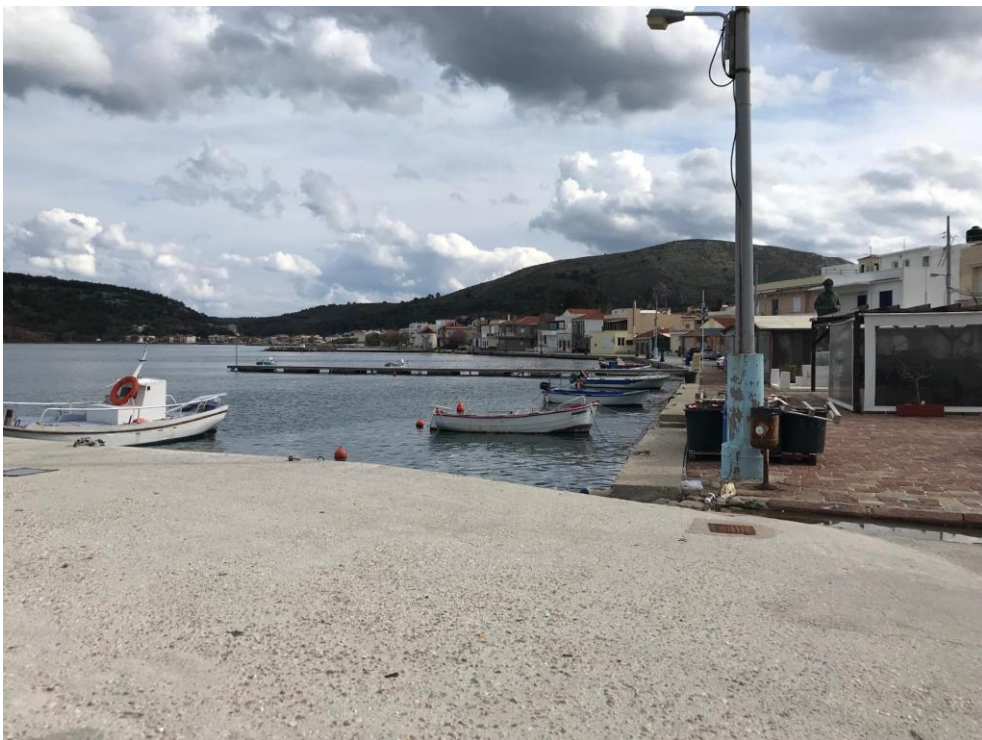
Άποψη λιμενικής εγκατάστασης σημείο γ.2
