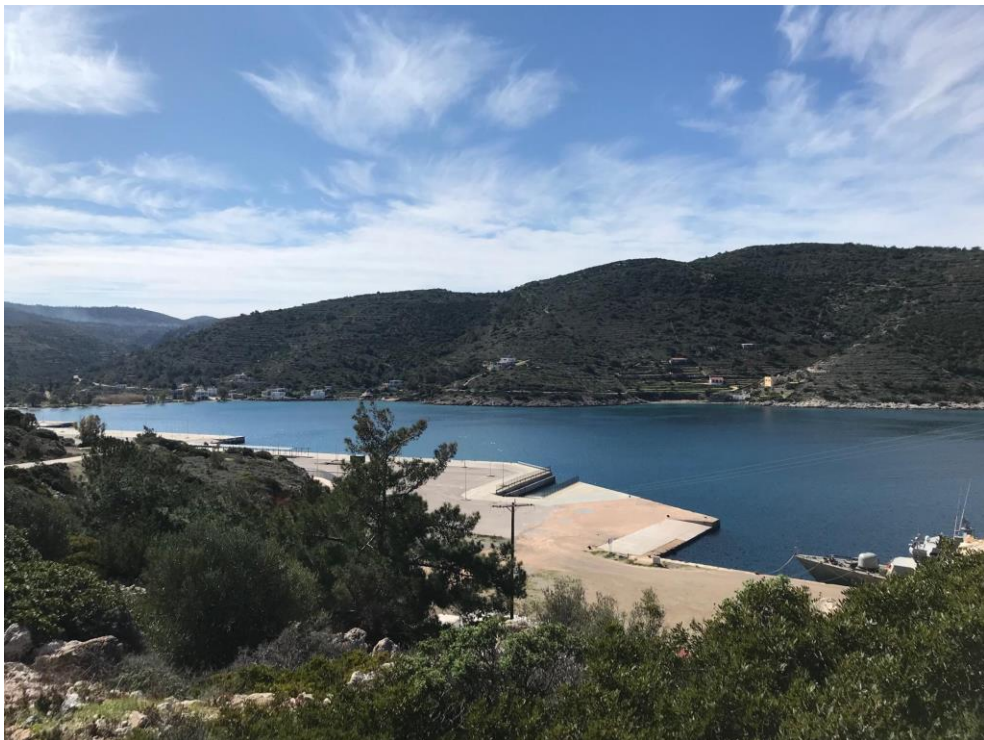
Άποψη λιμένα σημείο θ.2
