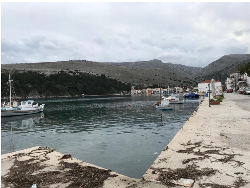
Άποψη λιμένα σημείο θ.2
