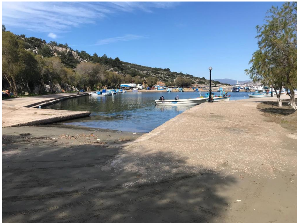
Άποψη λιμένα σημείο β.1
