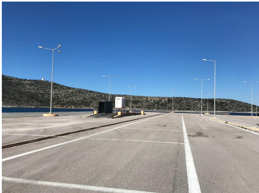
Άποψη λιμένα σημείο ζ.2
