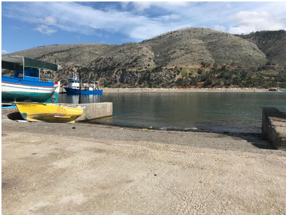
Άποψη λιμένα σημείο ζ.2
