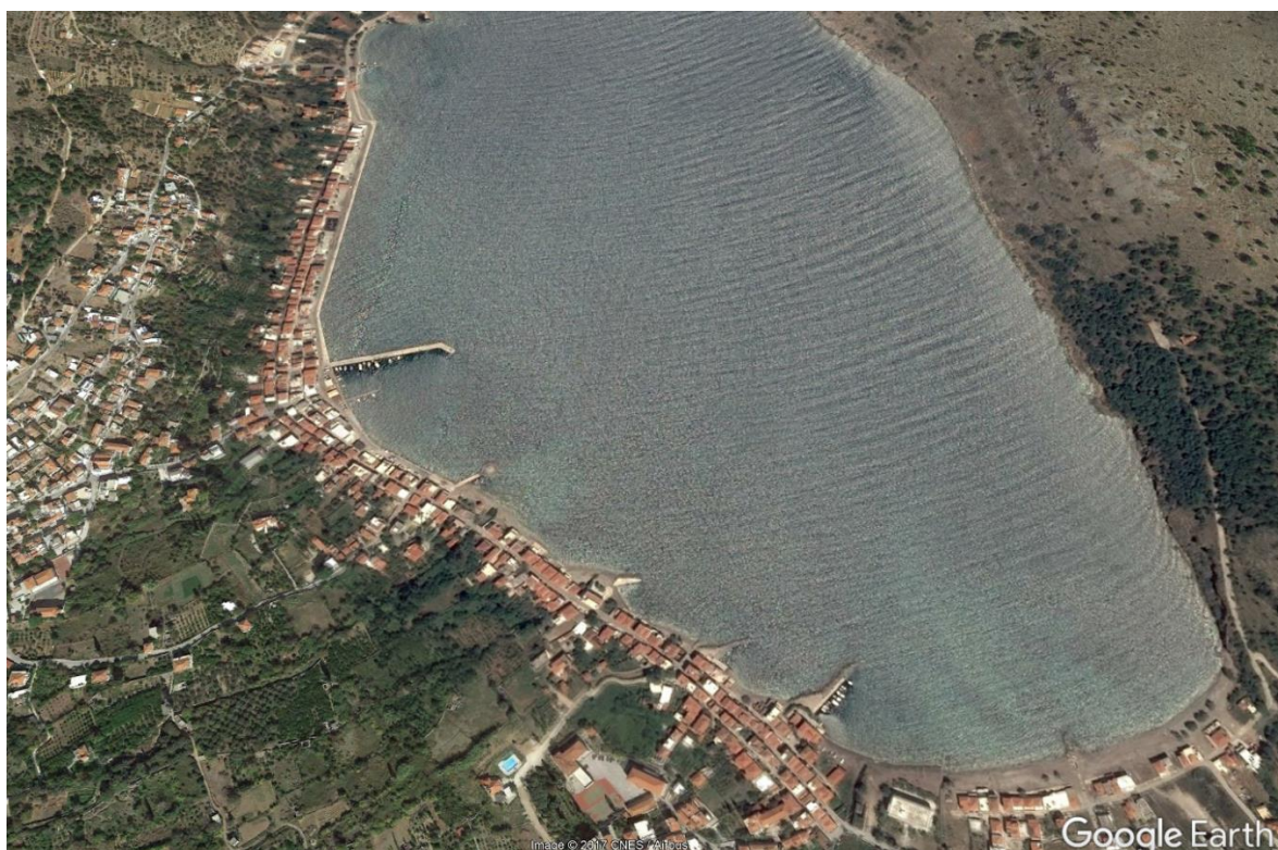
Λιμενική εγκατάσταση στα Καρδάμυλα
