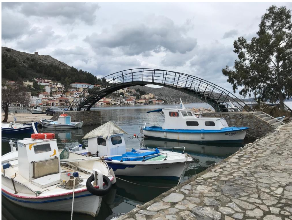
Άποψη λιμένα σημείο γ.1
