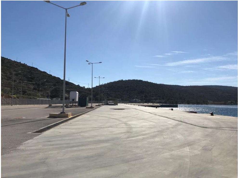
Άποψη λιμένα σημείο ζ.1
