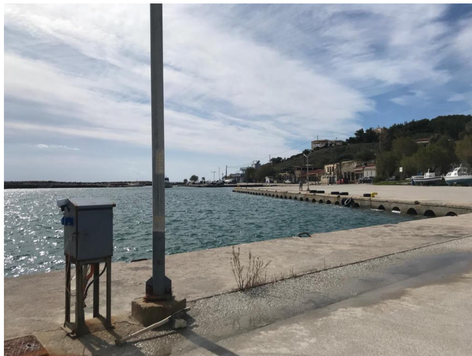
Άποψη λιμένα σημείο η
