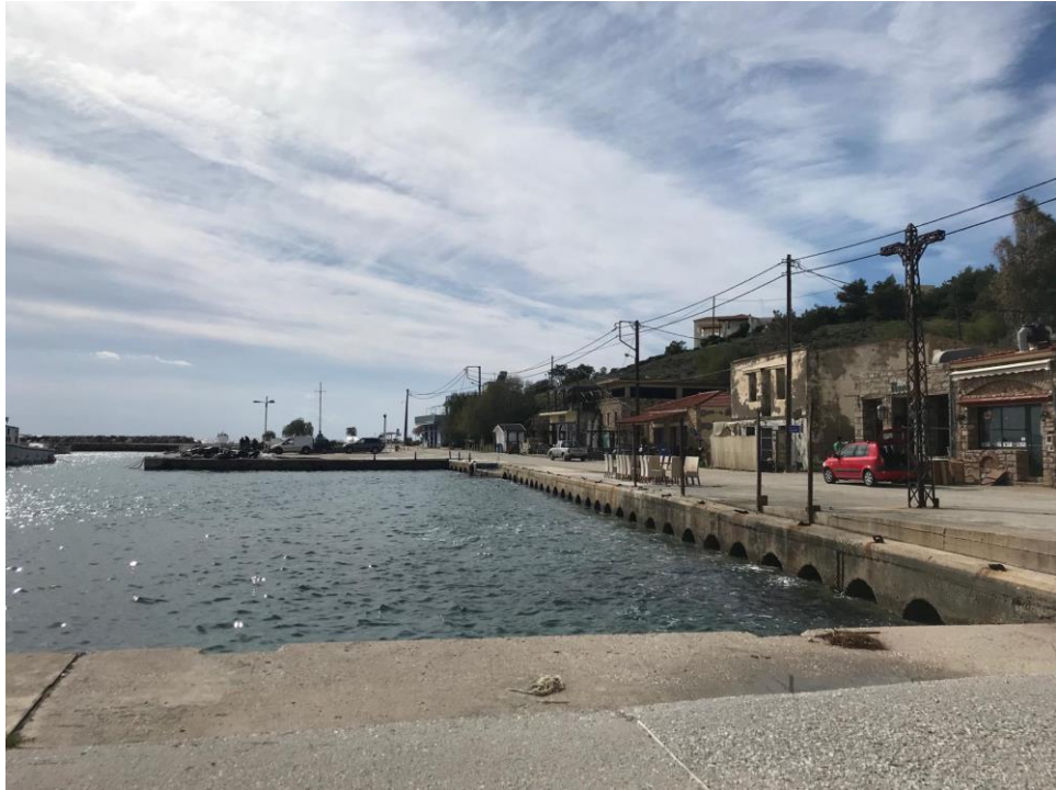
Άποψη λιμένα σημείο ζ
