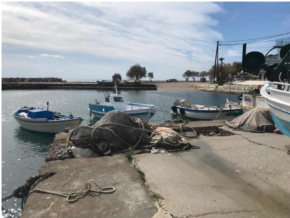
Άποψη λιμένα σημείο γ
