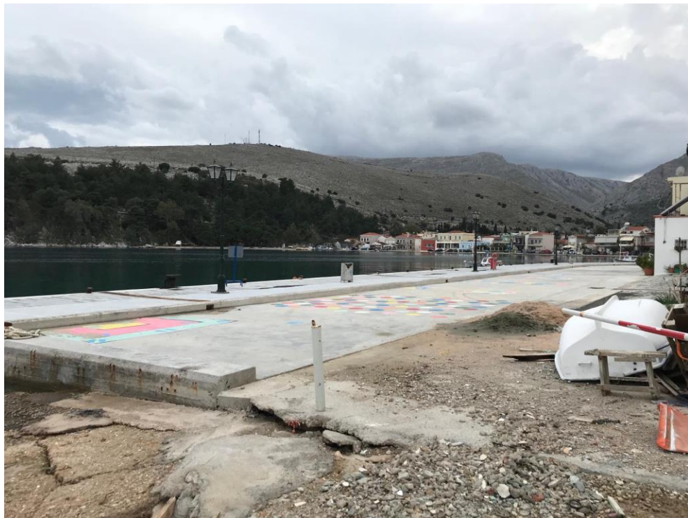
Άποψη λιμένα σημείο θ.1
