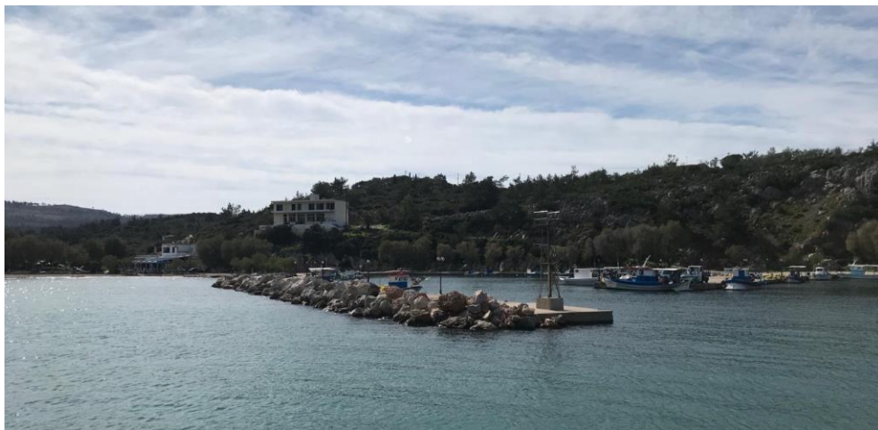
Άποψη λιμένα σημείο θ.2
