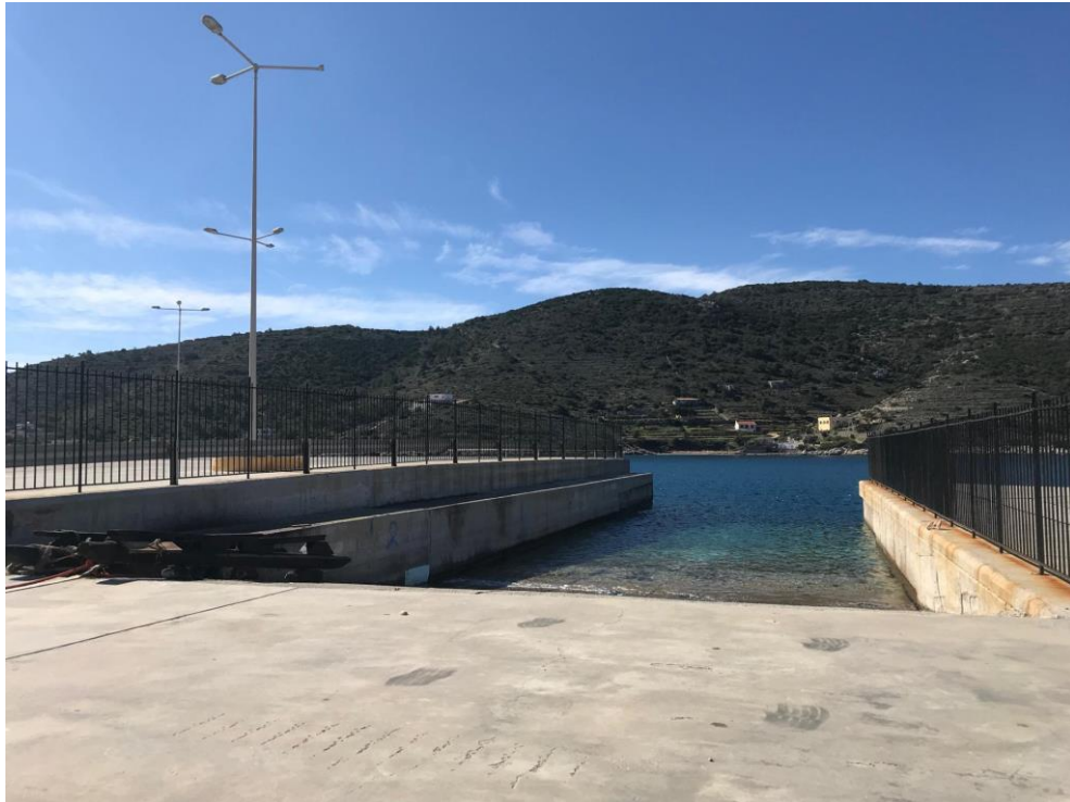
Άποψη λιμένα σημείο η.1
