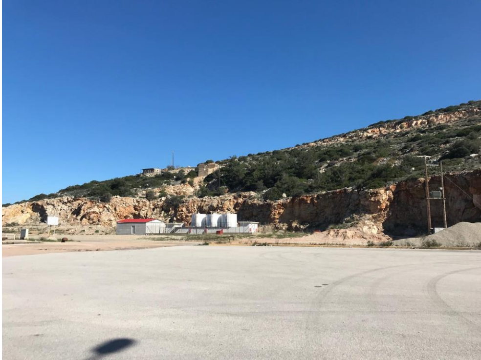
Άποψη λιμένα σημείο θ.1
