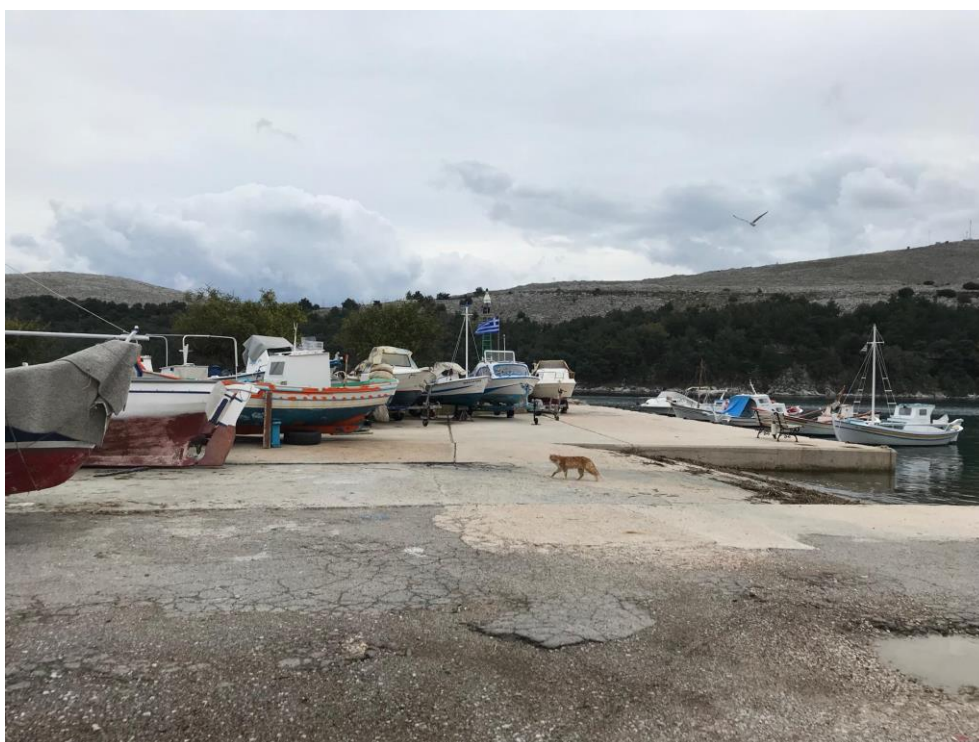
Άποψη λιμένα σημείο κ.1
