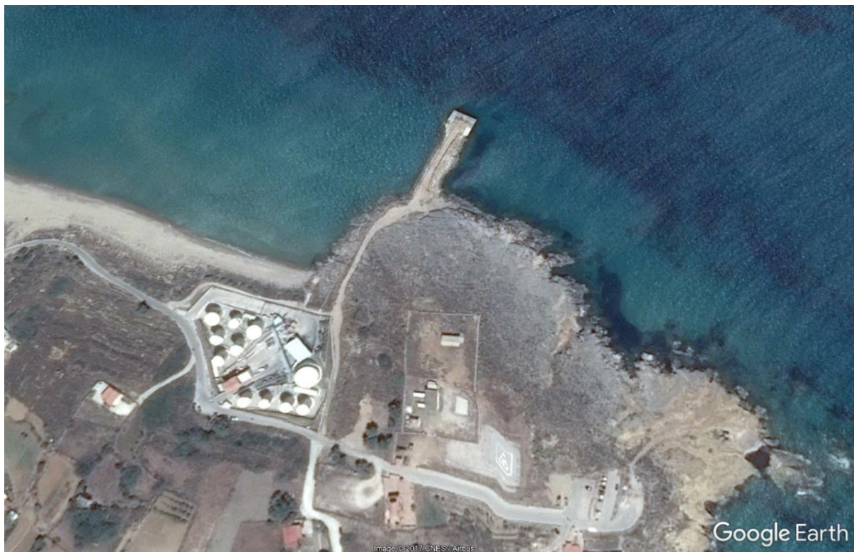
Η λιμενική εγκατάσταση REVOIL
