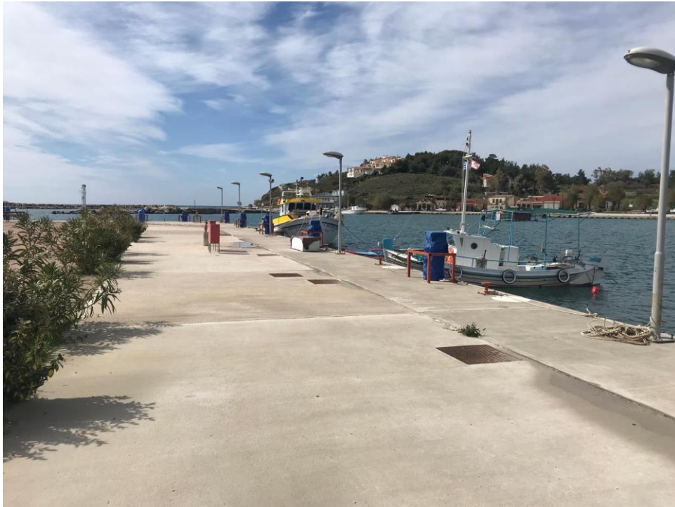
Άποψη λιμένα σημείο κ
