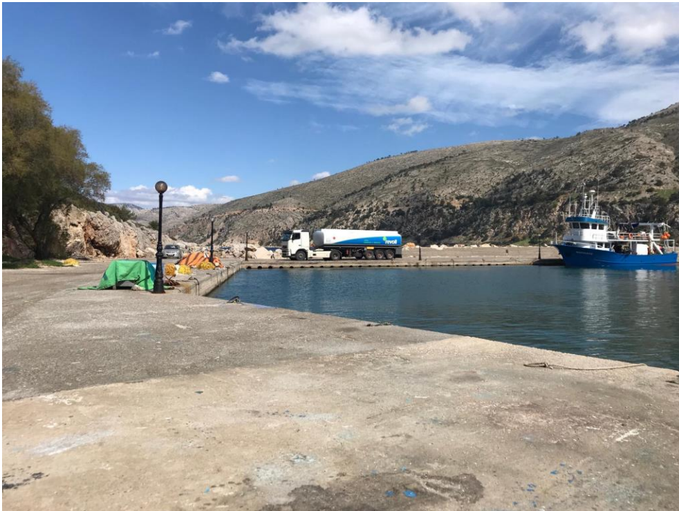
Άποψη λιμένα σημείο ζ.1
