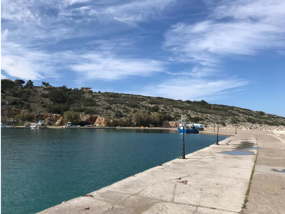
Άποψη λιμένα σημείο η.1
