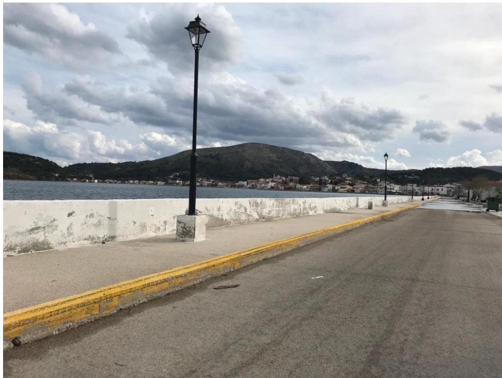
Άποψη λιμενικής εγκατάστασης σημείο β.1
