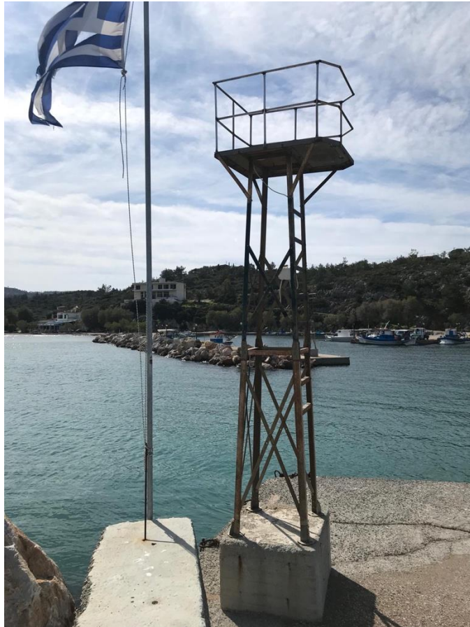
Άποψη λιμένα σημείο θ.1
