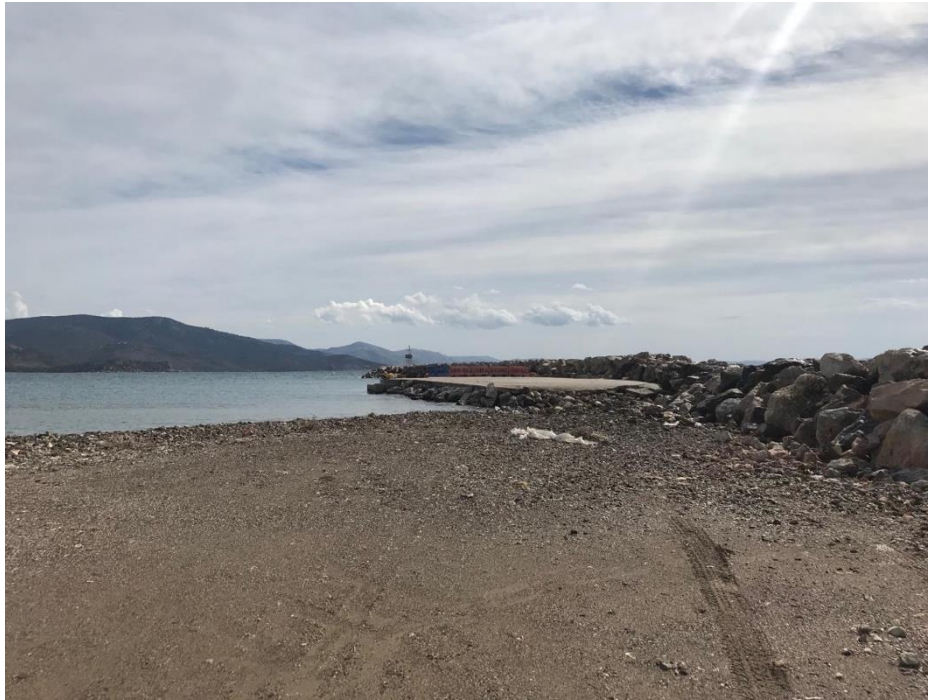
Άποψη λιμένα σημείο β
