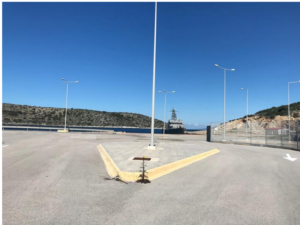
Άποψη λιμένα σημείο η.2
