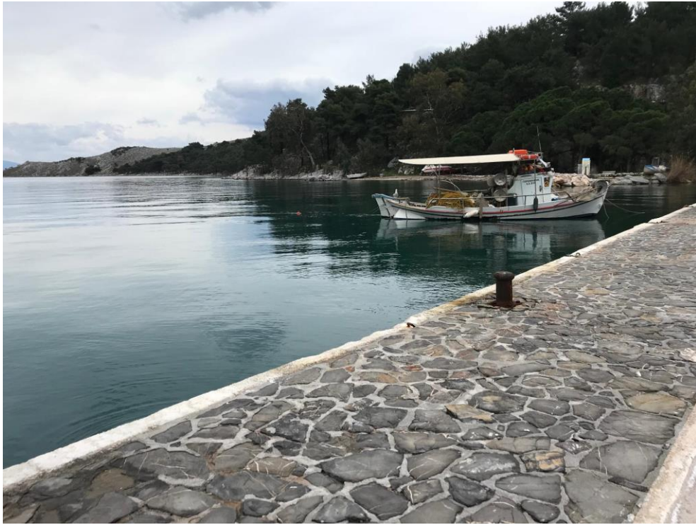
Άποψη λιμένα σημείο ζ.1
