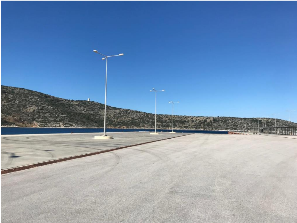
Άποψη λιμένα σημείο γ.1
