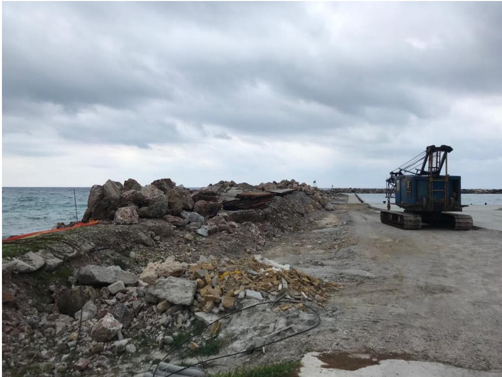
Άποψη λιμένα σημείο α.1
