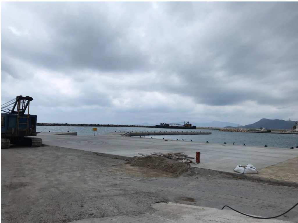
Άποψη λιμένα σημείο α.2
