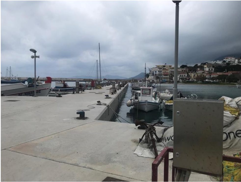
Άποψη λιμένα σημείο δ
