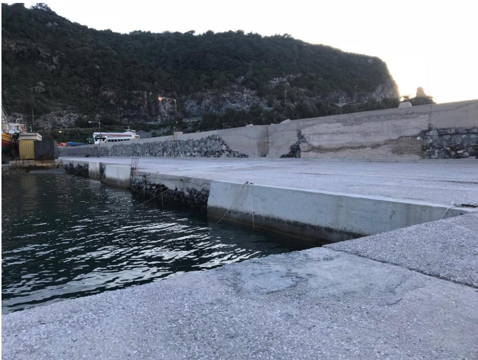
Άποψη λιμένα σημείο ζ.1
