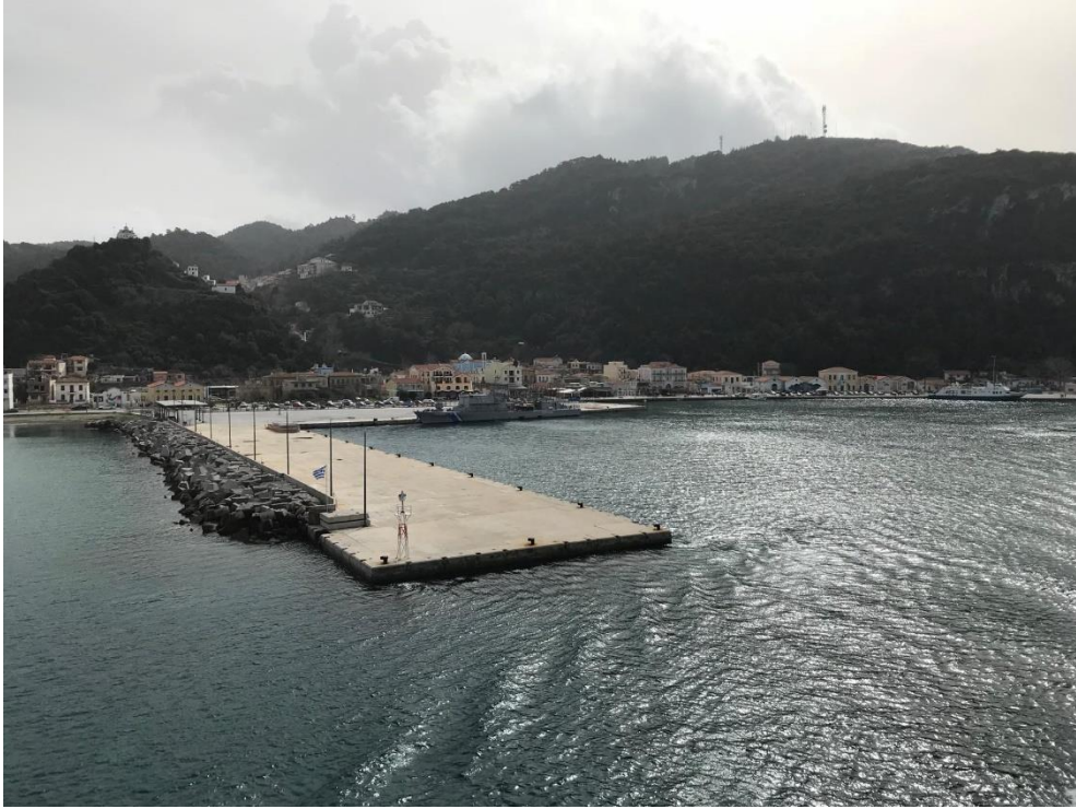
Άποψη λιμένα σημείο α
