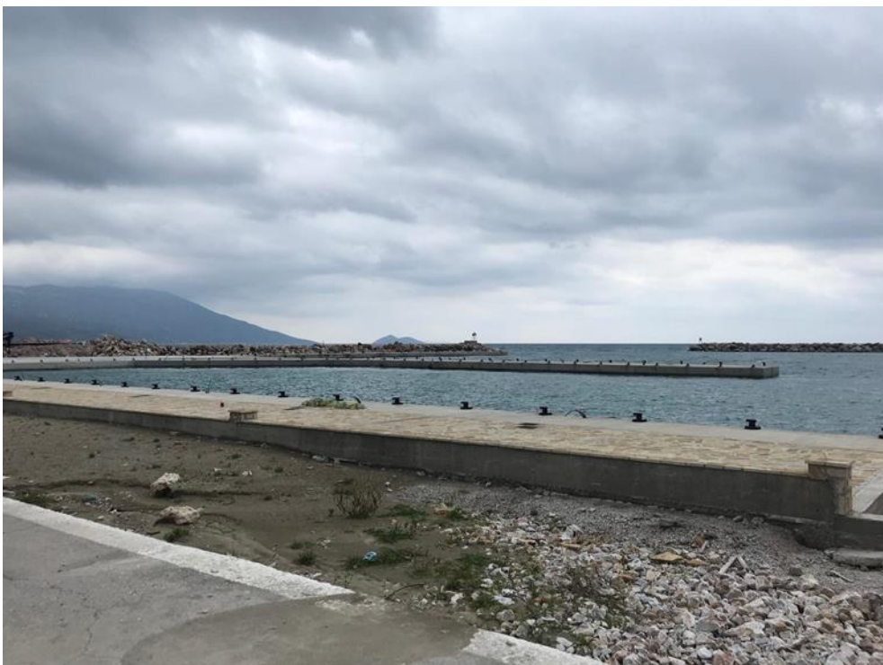
Άποψη λιμένα σημείο γ
