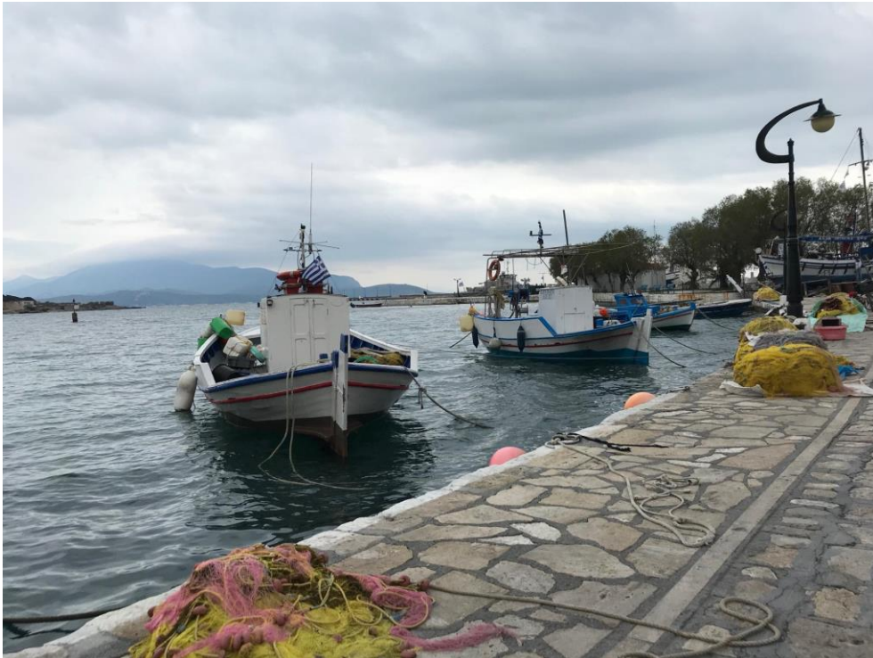
Άποψη λιμένα σημείο ζ
