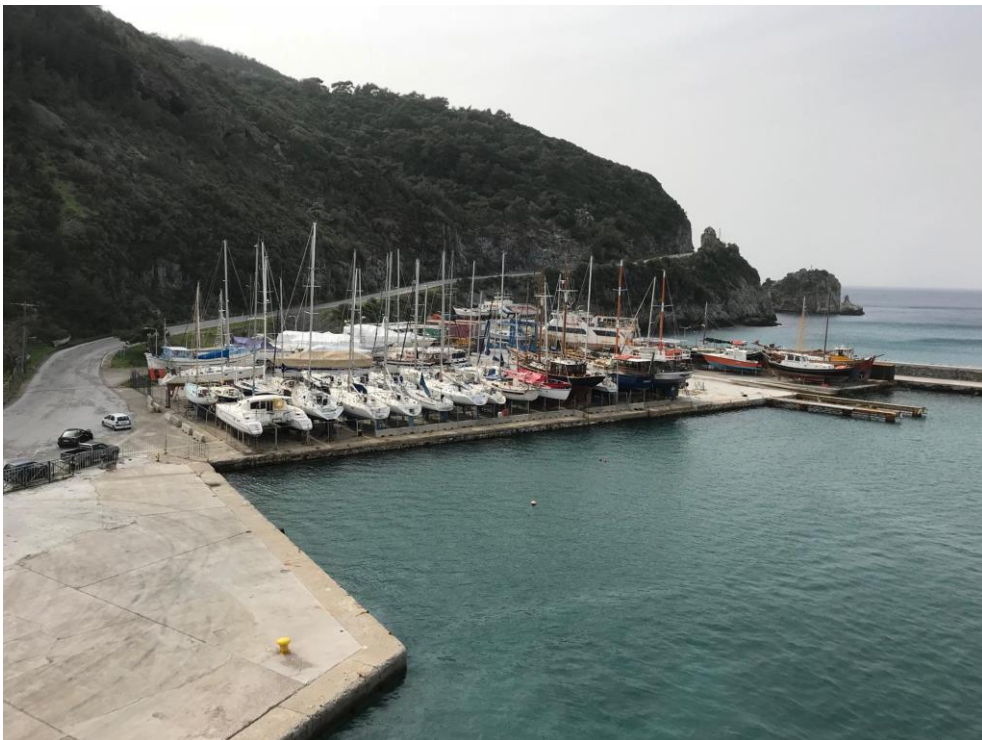
Άποψη λιμένα σημείο δ.1
