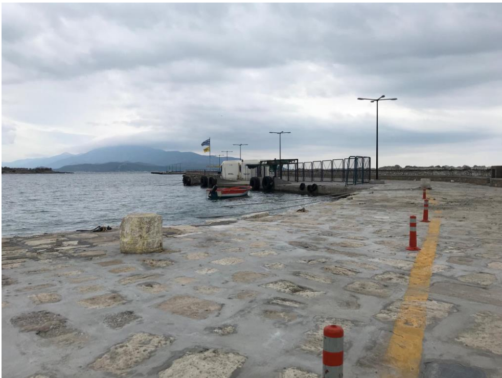
Άποψη λιμένα σημείο δ.1
