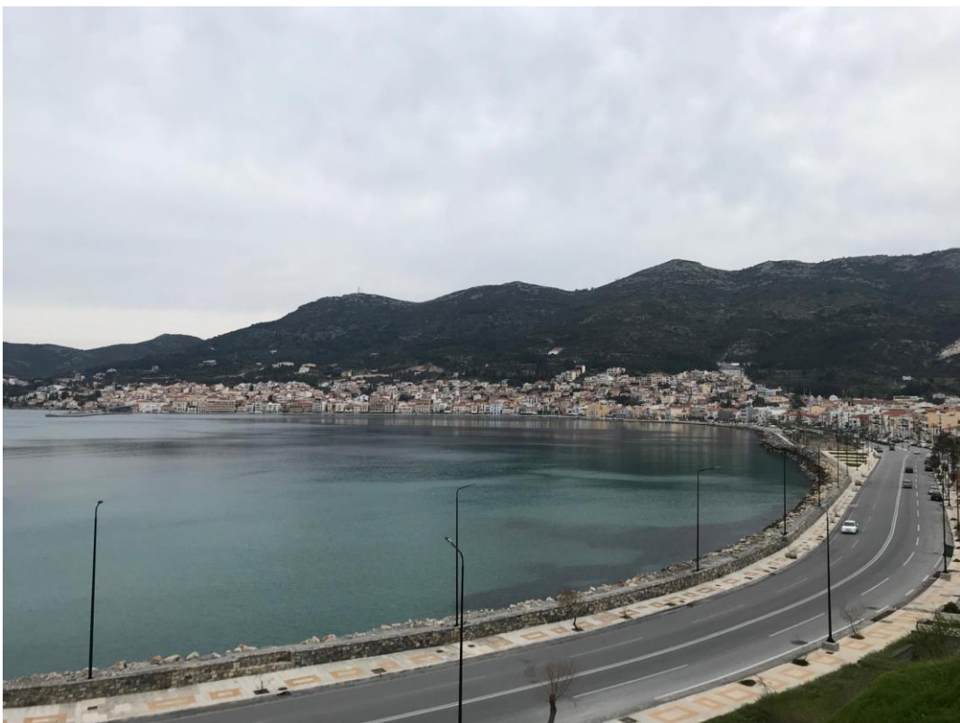
Άποψη λιμένα σημείο δ.2
