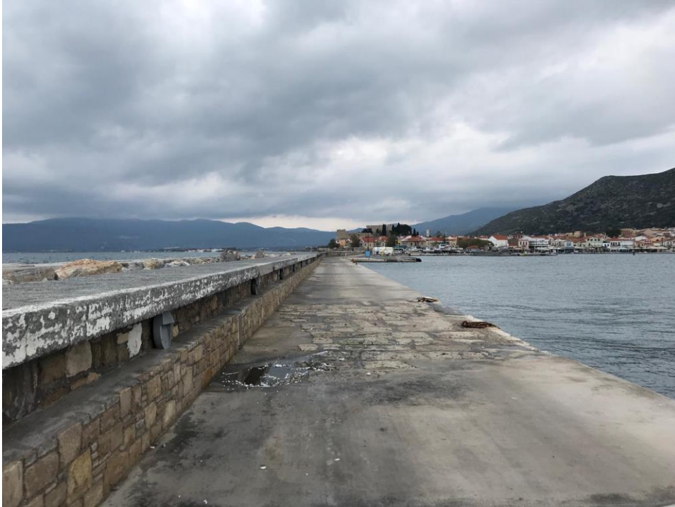
Άποψη λιμένα σημείο α
