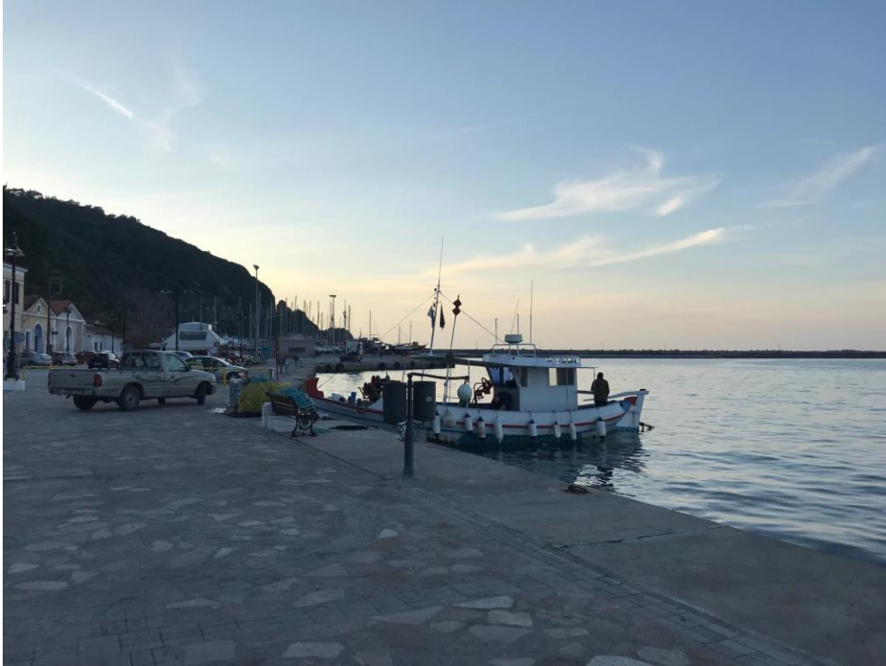
Άποψη λιμένα σημείο γ.2
