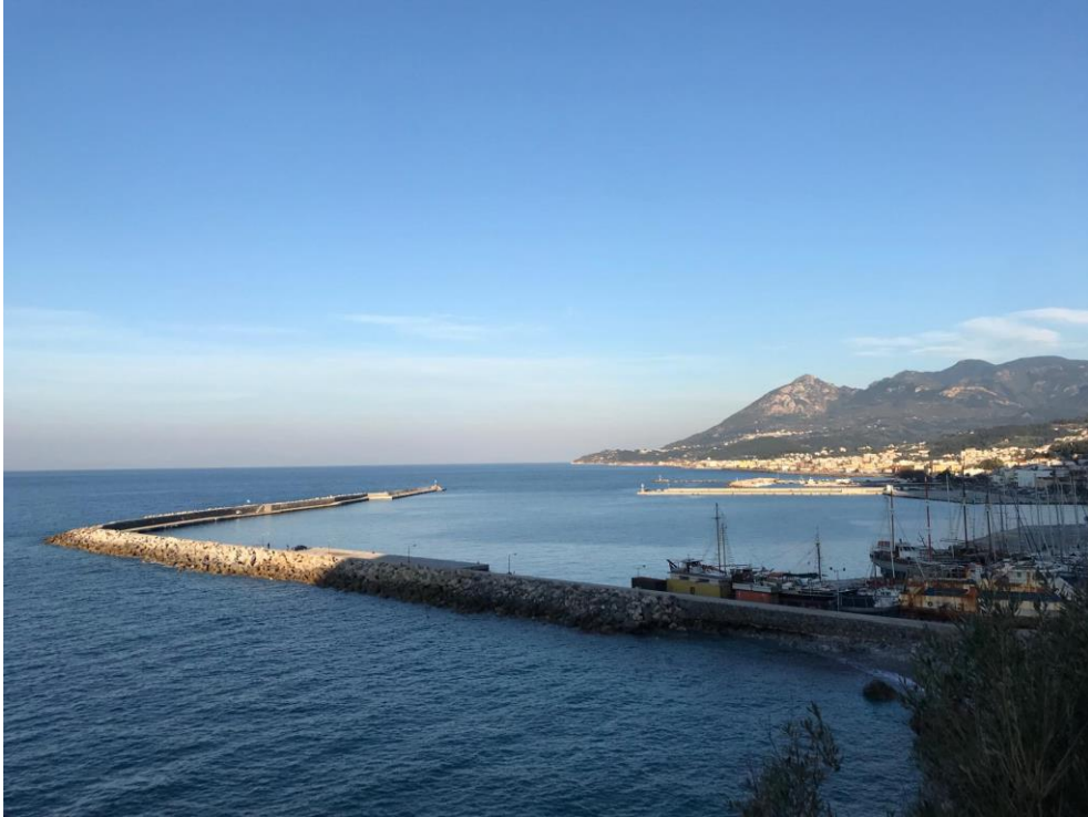
Άποψη λιμένα σημείο ε
