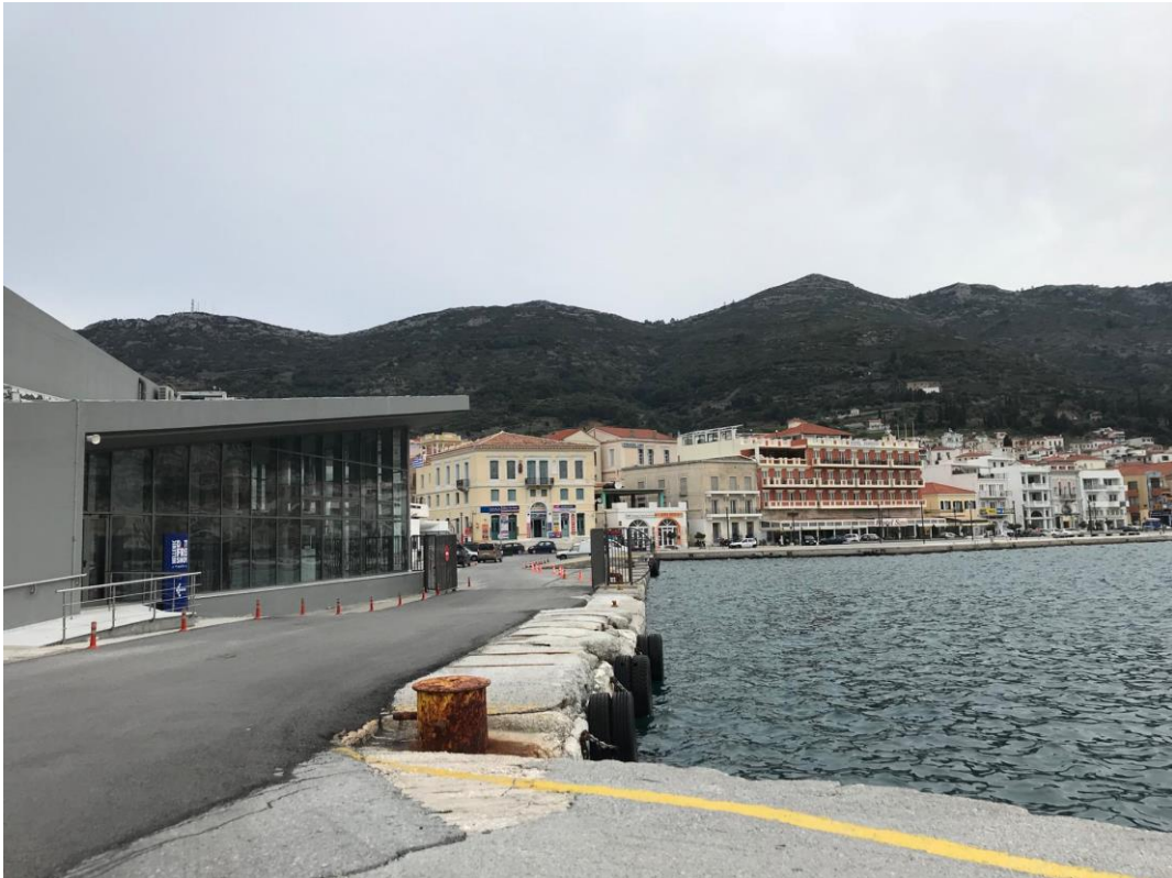
Άποψη λιμένα σημείο ζ.2
