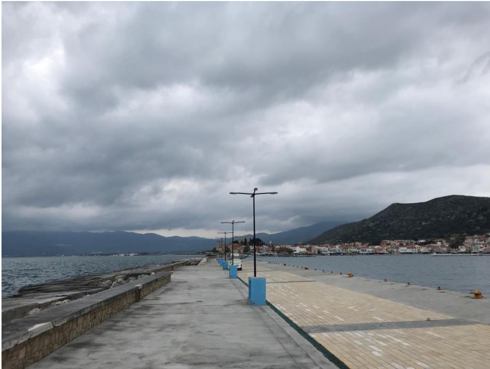
Άποψη λιμένα σημείο γ
