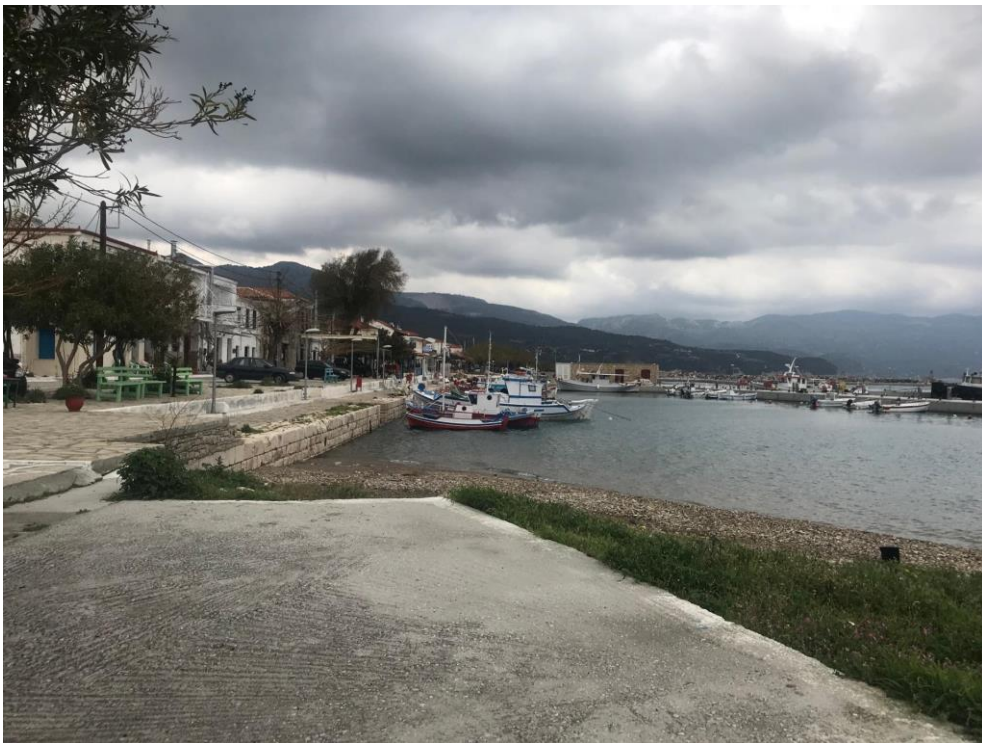
Άποψη λιμένα σημείο ε
