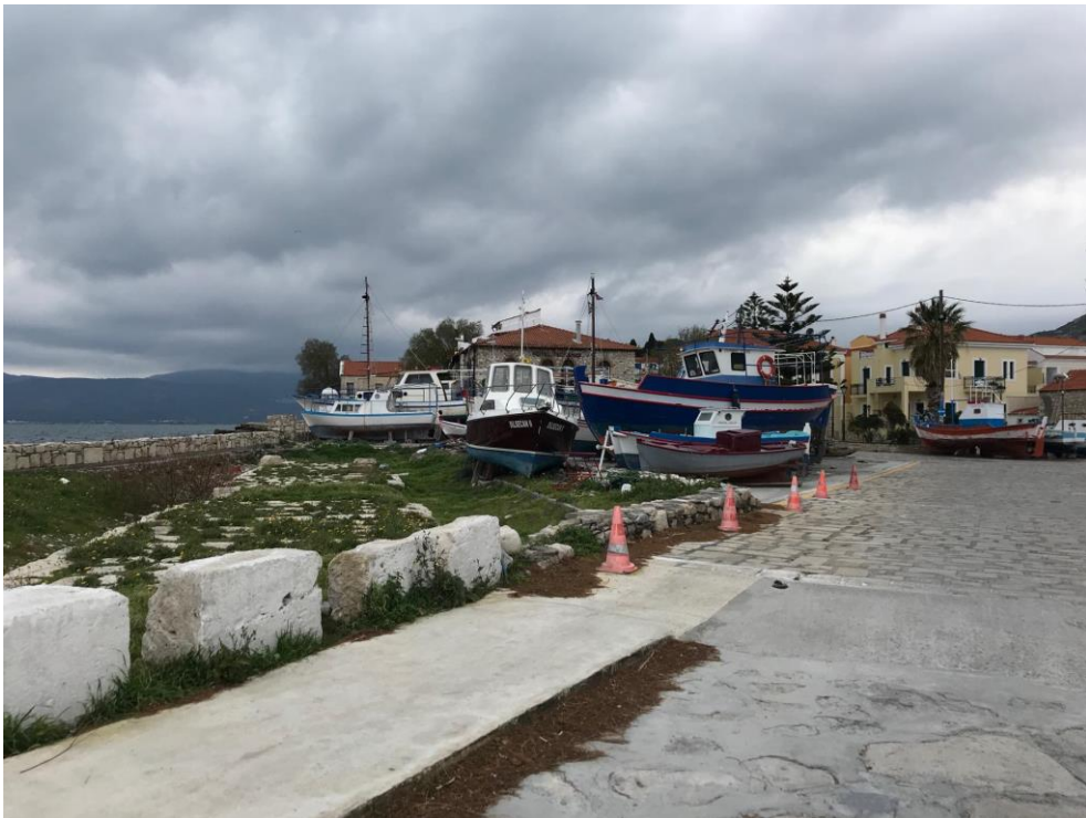
Άποψη λιμένα σημείο ε
