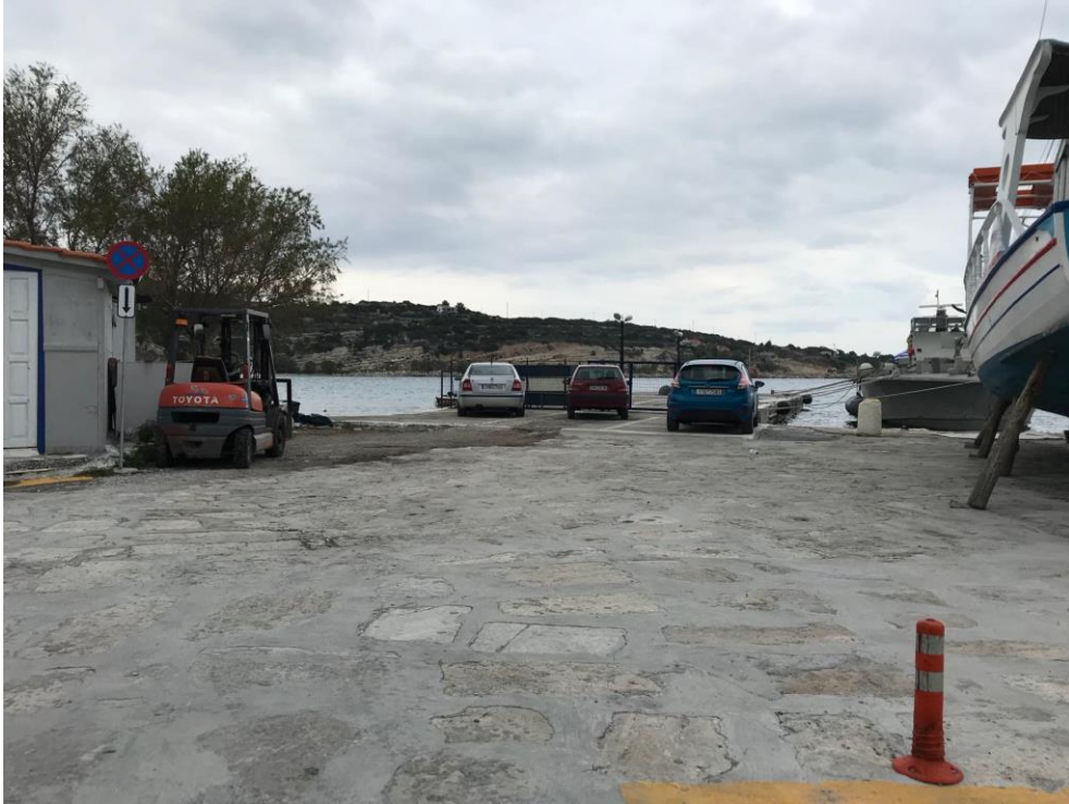
Άποψη λιμένα σημείο δ.2
