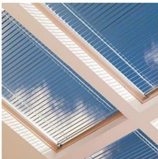
Εικόνα 15. Σύστημα ανακλαστικών περσίδων
