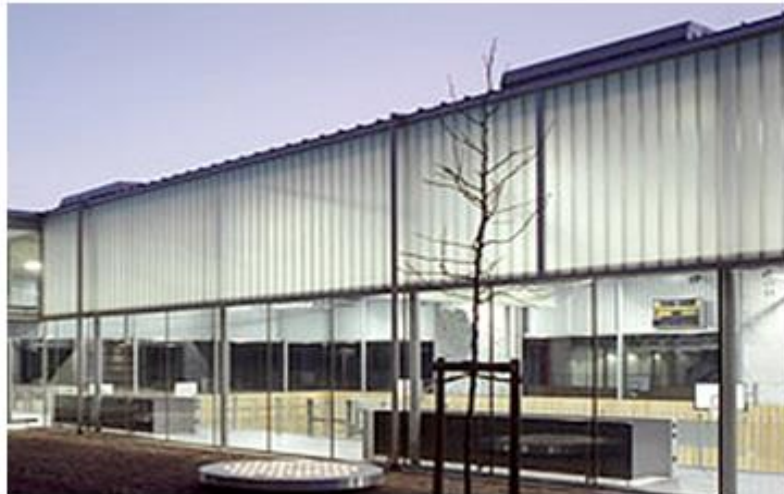
Εικόνα 14. Σύστημα διαφανούς μόνωσης Πηγή: http://www.cres.gr/energy_saving/Ktiria/fysikos_fotismos_monotika_ylika.htm
