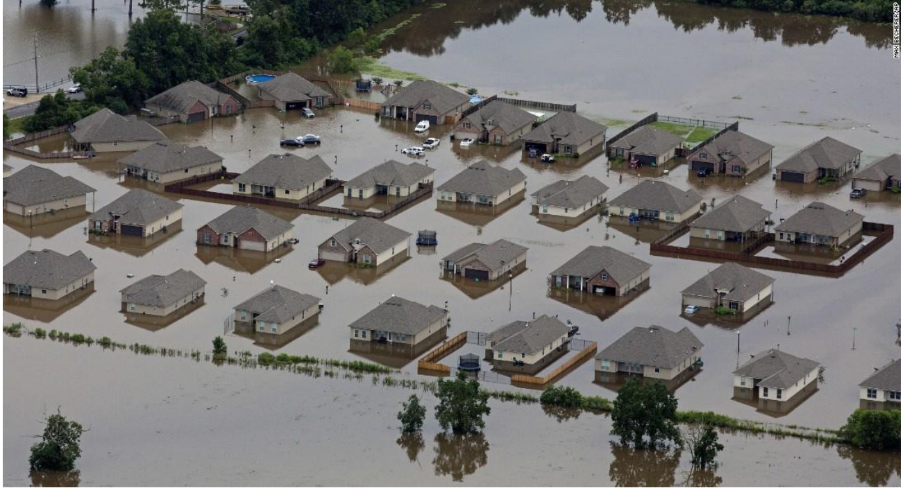
Εικόνα 4 Οι καταστροφικές συνέπειες της πλημμύρας στην περιοχή της Louisiana προκάλεσαν ζημιές σε 146 000 σπίτια
