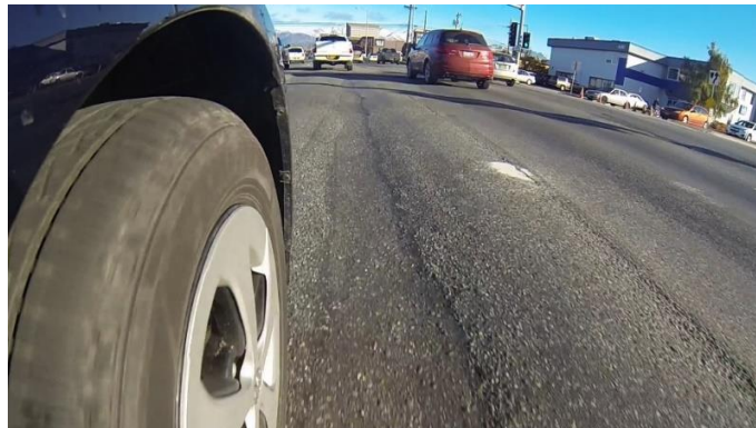
Εικόνα 20: Channel or ruts (Πηγή: www.en.wikipedia.org )
