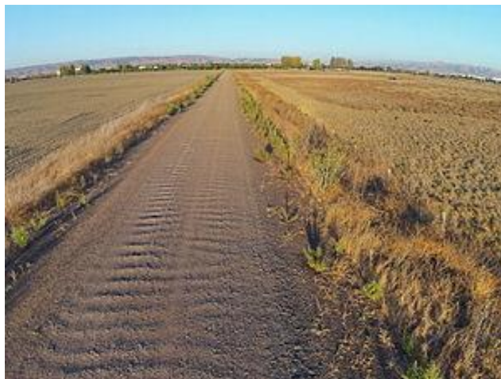
Εικόνα 19: Corrugations (Πηγή: www.pennbiotechgroup.com )
