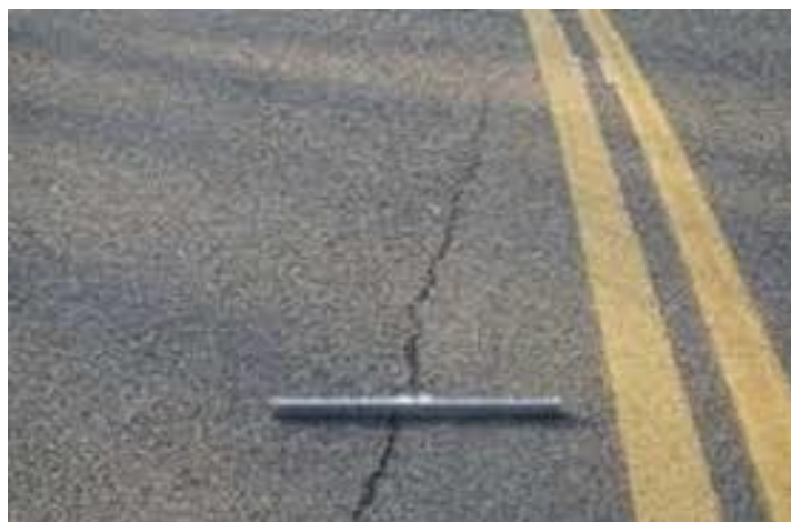
Εικόνα 14: Wheel path cracks (Πηγή: www.fhwa.dot.gov )
