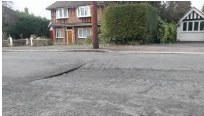
Εικόνα 16: Depression (Πηγή: www.pinsdaddy.com )
