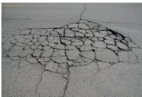
Εικόνα 3: Ρηγμάτωση μορφής Αλιγάτορα (Πηγή: www.hellaskps.gr )
