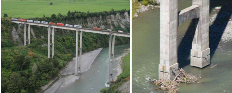
Εικόνα 1.1: Σιδηροδρομική γέφυρα Rangitikei (New Zealand) με λικνιζόμενα βάθρα.
