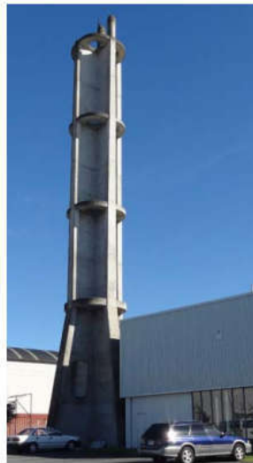
Εικόνα 1.2: Καμινάδα στο αεροδρόμιο Christchurch με δυνατότητα λικνισμού.
