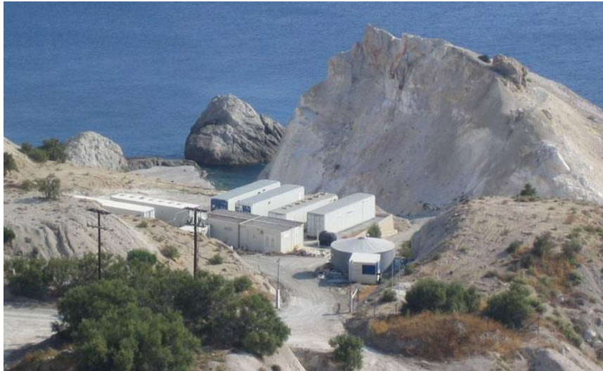
Σχήμα 1-8: Μονάδα Αφαλάτωσης στη Μήλο (Πηγή: http://ita-sa.gr ).
