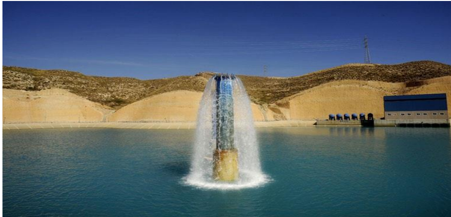
Σχήμα 1-2: Μονάδα Αφαλάτωσης σε Τέλενδο & Ψέριμο (Πηγή: http://www.enikonomia.gr ).
