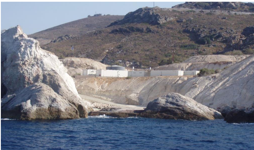
Σχήμα 1-7: Μονάδα Αφαλάτωσης σε Αρκούς (Πηγή: http://kataskevesktirion.gr ).
