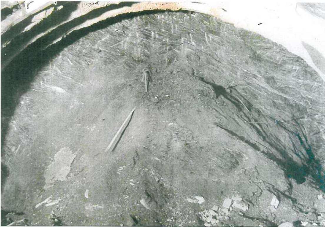
Εικόνα Παραρτήματος 24 Γραφτικός ασβεστοφυλλίτης (ph) (Διατομή N029, NB, T2) Μέθοδος εκσκαφής: μηχανικά μέσα, GSI=5~10, Βαθμός αποσάθρωσης : RS, Υπερκείμενο ~62m, Χ.Θ. 10+711 (MKC -JV)
