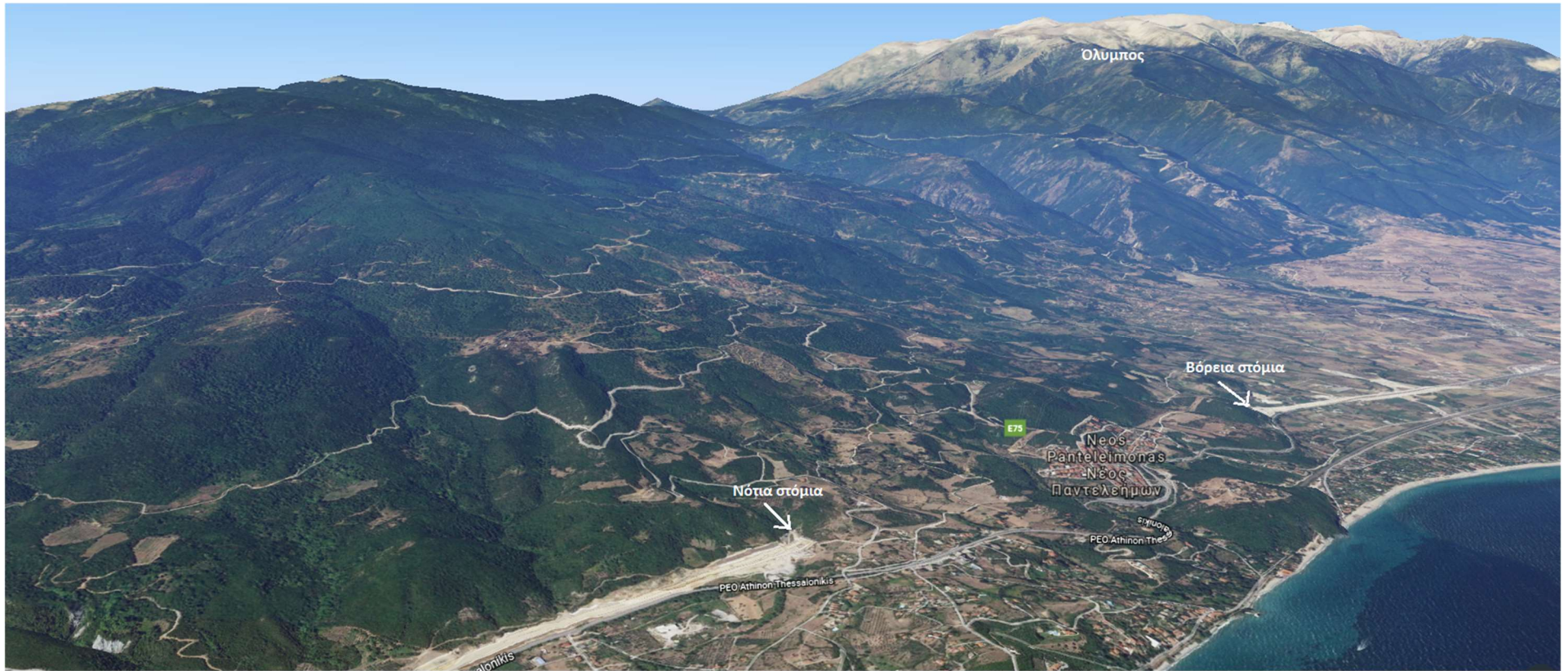
Εικόνα Παραρτήματος 6 Σήραγγα Τ3
