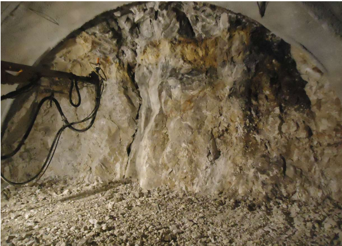
Εικόνα Παραρτήματος 34 Κρυσταλλικός ασβεστόλιθος (κc) (Διατομή N366, NB, T3) Μέθοδος εκσκαφής: εκρηκτικά, GSI=40~50, Υπερκείμενο ~64m, Χ.Θ. 12+817 (ΜΚC-JV)
