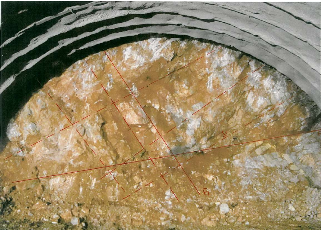
Εικόνα Παραρτήματος 37 Μάρμαρο (Διατομή N081, NB, T3) ,Μέθοδος εκσκαφής: μηχανικά & εκρηκτικά, GSI=30~35, Υπερκείμενο ~14m, Βαθμός αποσάθρωσης: HW, Χ.Θ. 14+001 (MKC-JV)
