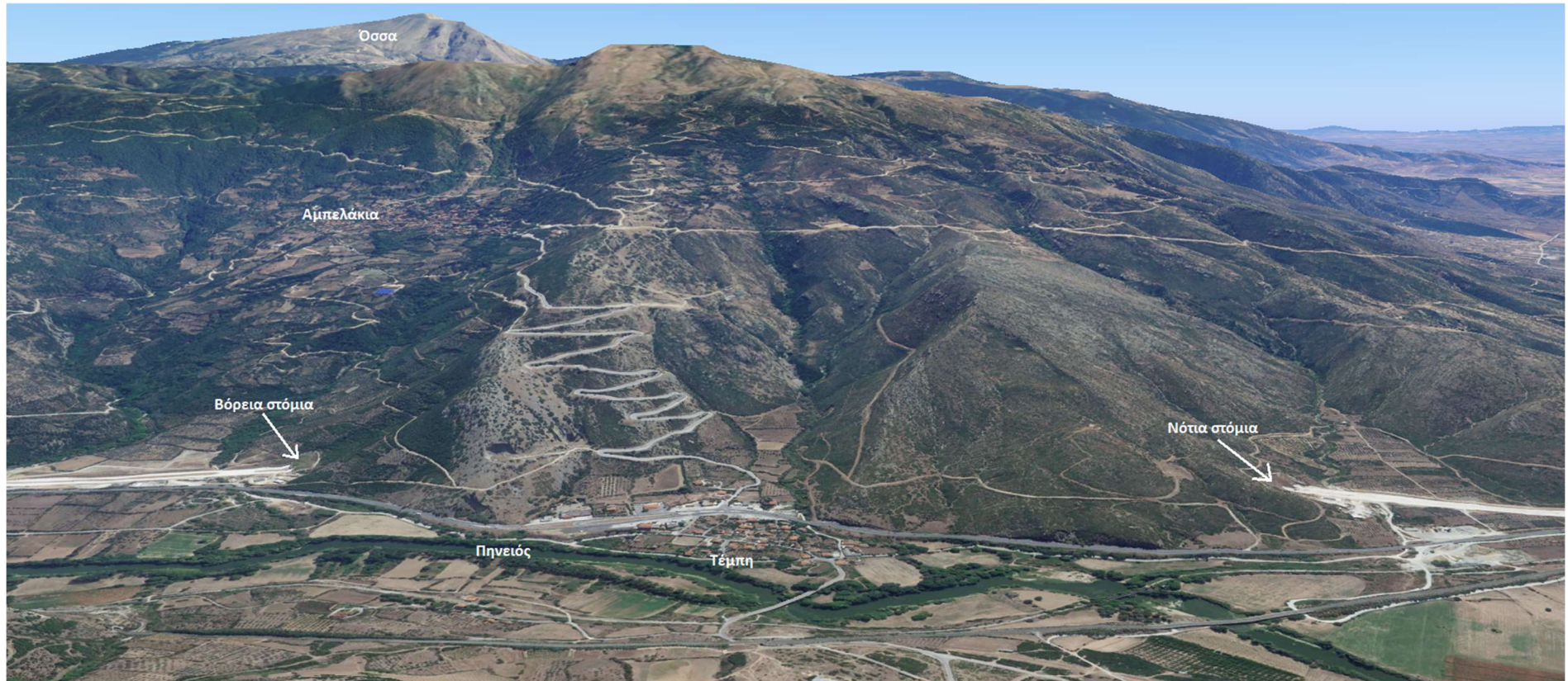
Εικόνα Παραρτήματος 2 Σήραγγα Τ1
