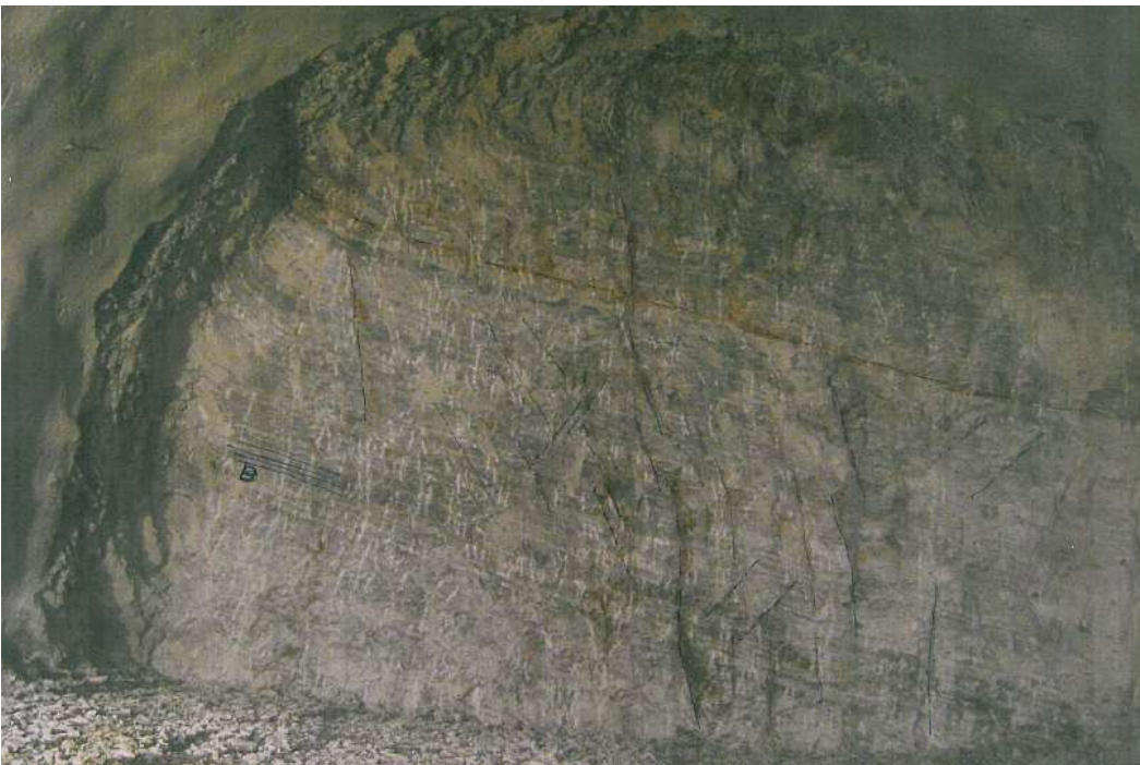
Εικόνα Παραρτήματος 29 Κρυσταλλικός ασβεστόλιθος (Kc) (Διατομή N305, NB, T2) Μέθοδος εκσκαφής:εκρηκτικά, GSI=65~75, Βαθμός αποσάθρωσης: F-SW, Υπερκείμενο ~210m, Χ.Θ. 8+197 (MKC -JV)
