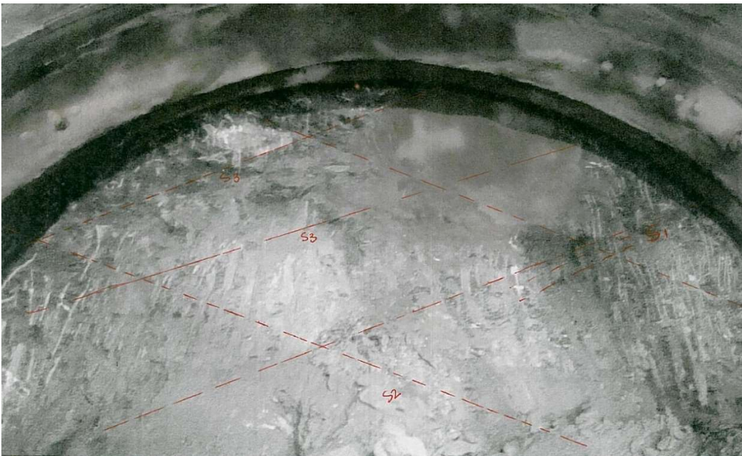
Εικόνα Παραρτήματος 33 Σερπεντινωμένος περιδοτίτης (π-σ) (Διατομή N158, NB, T3) Μέθοδος εκσκαφής: μηχανικά μέσα, GSI=15~20, Βαθμός αποσάθρωσης: CW, Υπερκείμενο ~84m, Χ.Θ. 13+727 (MKC -JV)
