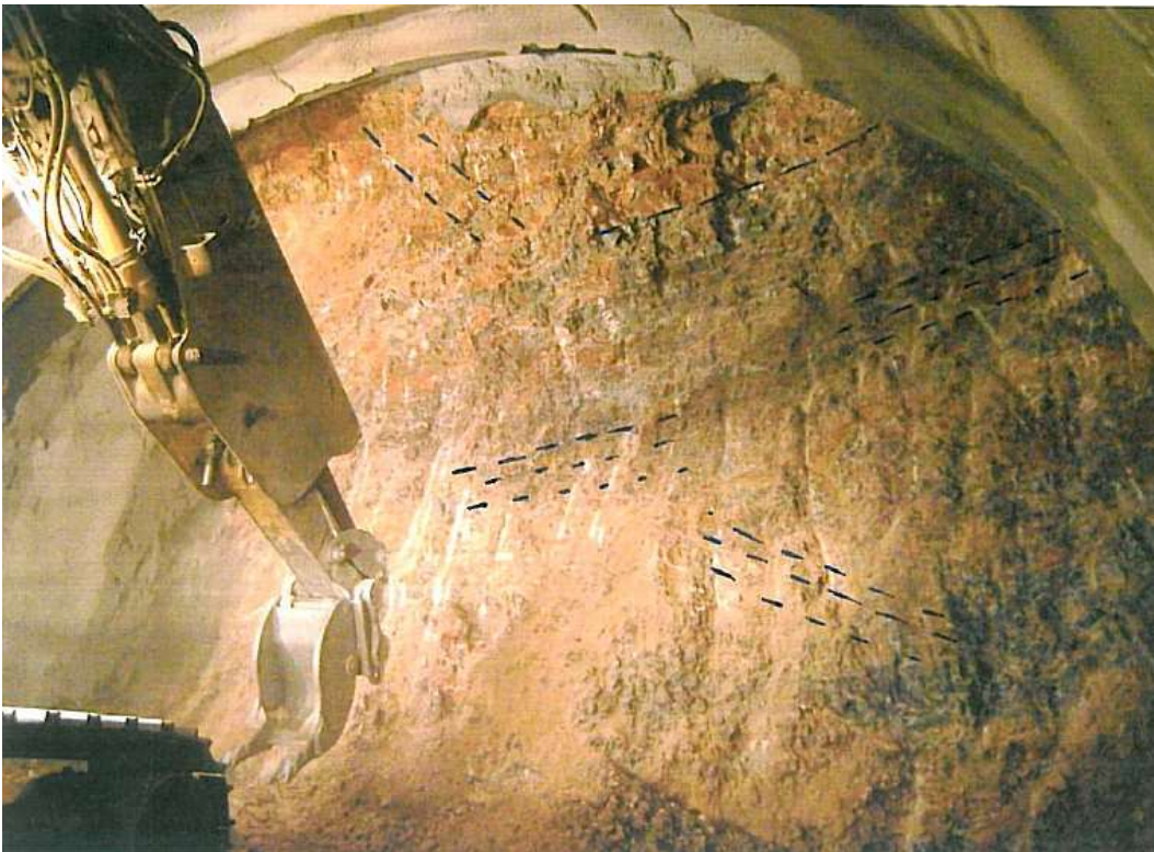
Εικόνα Παραρτήματος 26 Κρυσταλλικός ασβεστόλιθος (Kc) (Διατομή N263, NB, T2) Μέθοδος εκσκαφής: μηχανικά μέσα, GSI=30~40, Βαθμός αποσάθρωσης: MW-HW, Υπερκείμενο ~189m, Χ.Θ. 8+571 (MKC -JV)
