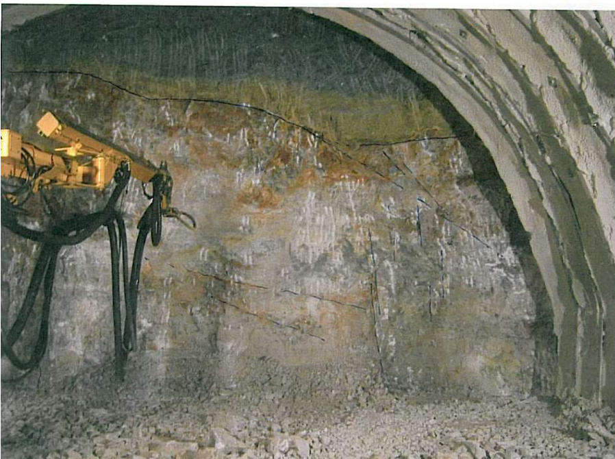
Εικόνα Παραρτήματος 31 Μεικτό μέτωπο φυλλίτη/κρυσταλλικού ασβεστολίθου (ρh/Kc) (Διατομή N244, SB, T2) Μέθοδος εκσκαφής: μηχανικά μέσα & εκρηκτικά, GSI (ρh)=15~25 & GSI(kc)=40~45, Βαθμός αποσάθρωσης ρh: HW & Βαθμός αποσάθρωσης kc: MW-HW, Υπερκείμενο ~155m, Χ.Θ. 8+876 (MKC -JV)
