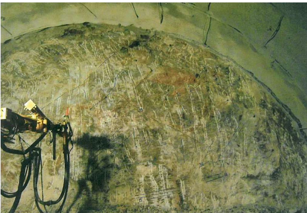
Εικόνα Παραρτήματος 27 Κρυσταλλικός ασβεστόλιθος (Kc) (Διατομή N125, NB, T2) Μέθοδος εκσκαφής:εκρηκτικά, GSI=60~65, Βαθμός αποσάθρωσης: SW-MW, Υπερκείμενο ~164m, Χ.Θ. 9+814 (MKC JV)
