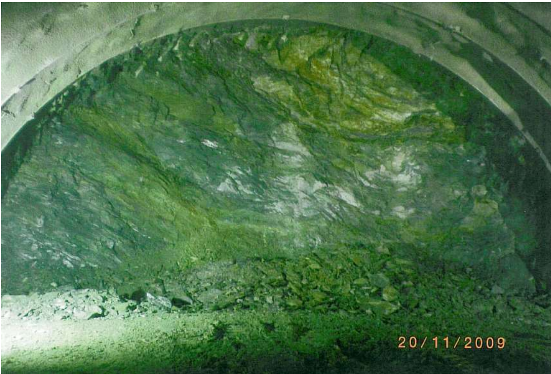
Εικόνα Παραρτήματος 18 Πρασινίτης (g-sch) (Διατομή N205, NB, T1) Μέθοδος εκσκαφής:μηχανικά μέσα & εκρηκτικά, GSI=35~40, Βαθμός αποσάθρωσης:MW-HW, Υπερκείμενο~25m, Χ.Θ. 2+943 (VINCI construction)
