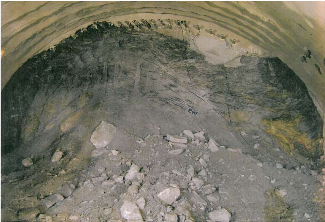
Εικόνα Παραρτήματος 22 Φυλλίτης (ρh) (Διατομή N128, SB, T2) Μέθοδος εκσκαφής: μηχανικά μέσα, GSI=10~15, Βαθμός αποσάθρωσης: HW-CW, Υπερκείμενο ~144m, Χ.Θ. 10+016 (MKC-JV)
