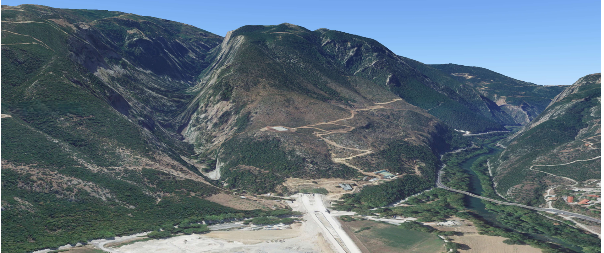
Εικόνα Παραρτήματος 4 Βόρεια στόμια σήραγγας T2
