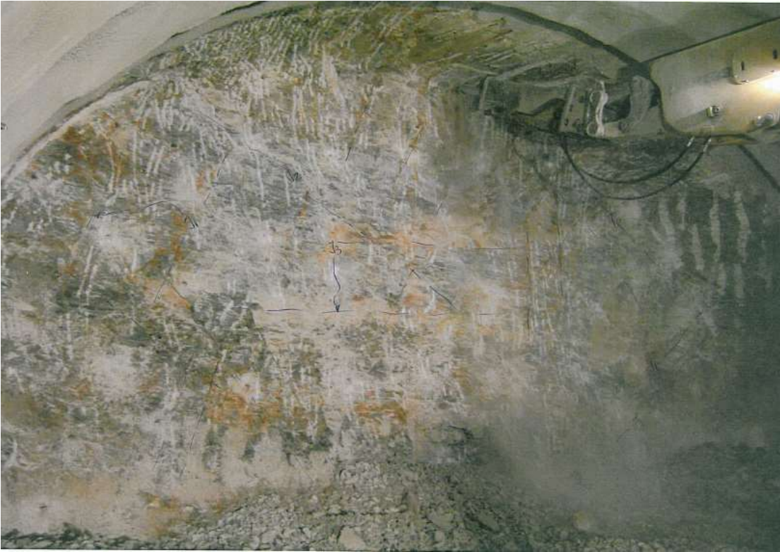
Εικόνα Παραρτήματος 28 Κρυσταλλικός ασβεστόλιθος (Kc) (Διατομή N101, NB, T2) Μέθοδος εκσκαφής:εκρηκτικά, GSI=40~50, Βαθμός αποσάθρωσης: SW-MW, Υπερκείμενο ~146m, Χ.Θ. 9+994 (MKC -JV)
