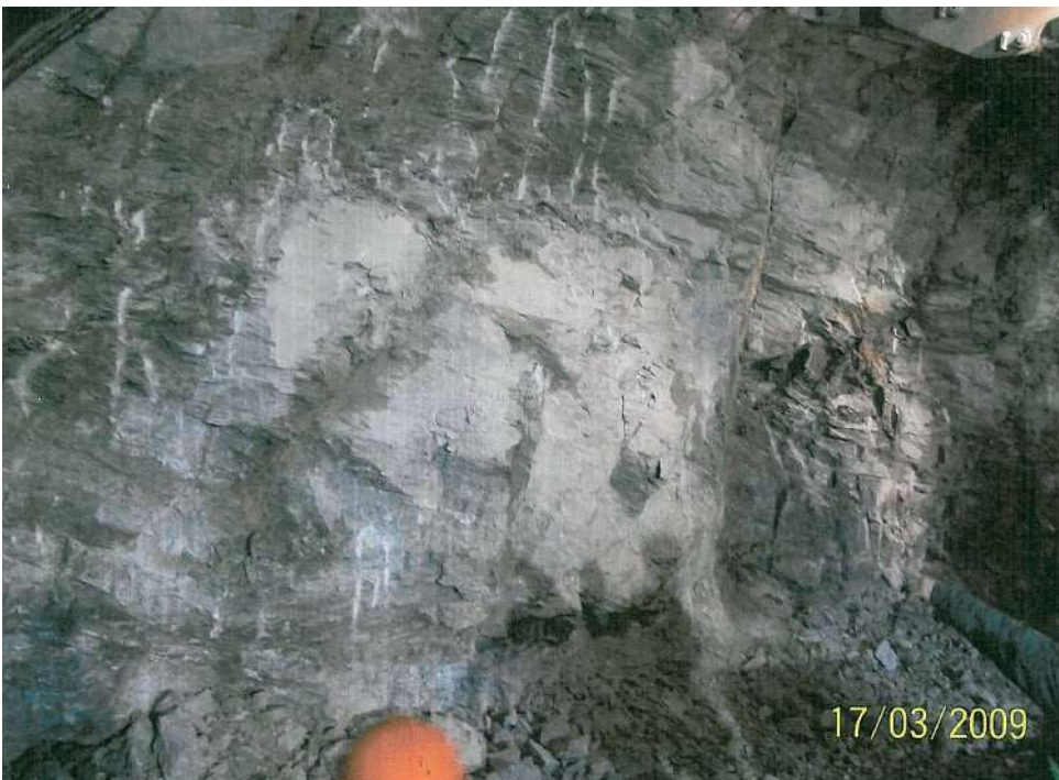
Εικόνα Παραρτήματος 21 Αμφιβολίτης-αμφιβολιτικός σχιστόλιθος (ab-sch) (Διατομή S015, SB, T1) Μέθοδος εκσκαφής: εκρηκτικά, GSI=35~40, Βαθμός αποσάθρωσης: SW-MW, Υπερκείμενο ~26m, Χ.Θ. 2+031 (MKC -JV)
