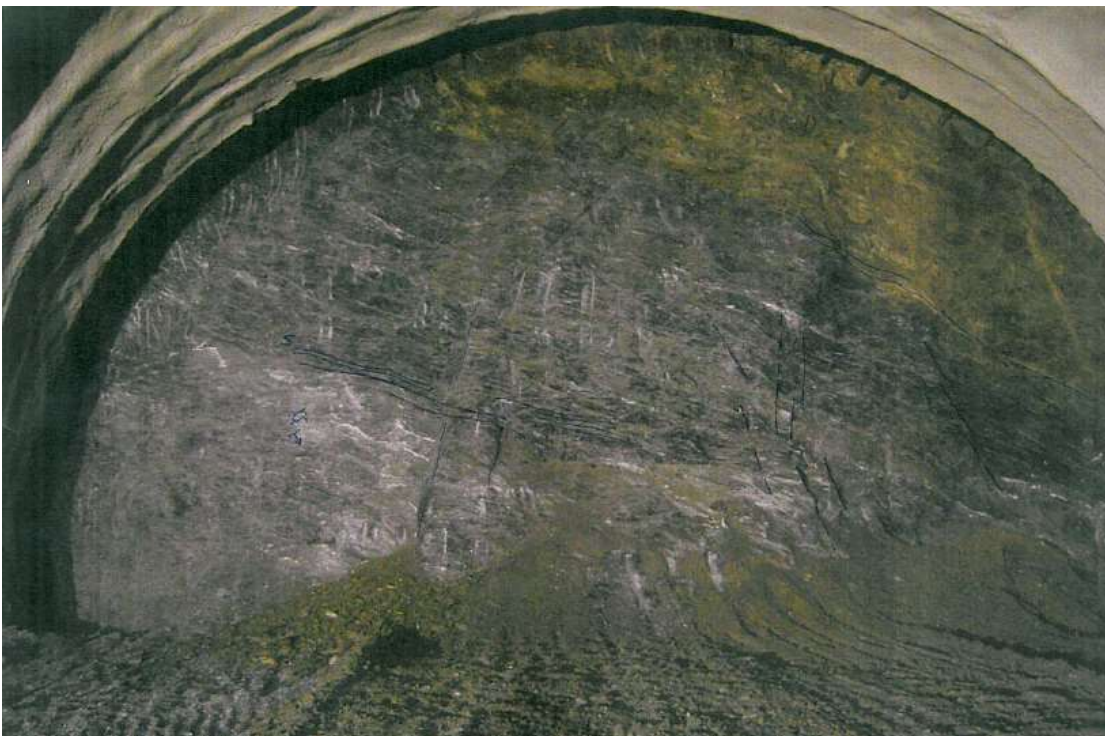
Εικόνα Παραρτήματος 25 Φυλλίτης με ασβεστιτικές φλέβες (ph) (Διατομή N276, NB, T2) Μέθοδος εκσκαφής: μηχανικά μέσα και εκρηκτικά, GSI=20~30, Βαθμός αποσάθρωσης: MW-HW, Υπερκείμενο ~170m, Χ.Θ. 8+483 (MKC -JV)
