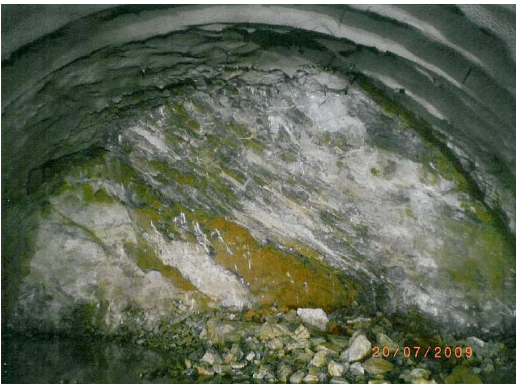
Εικόνα Παραρτήματος 19 Μάρμαρο (mr) (Διατομή N117, NB, T1) Μέθοδος εκσκαφής:μηχανικά μέσα & εκρηκτικά, GSI=60~65, Βαθμός αποσάθρωσης:SW-MW, Υπερκείμενο~125m, Χ.Θ. 3+417 (VINCI construction)
