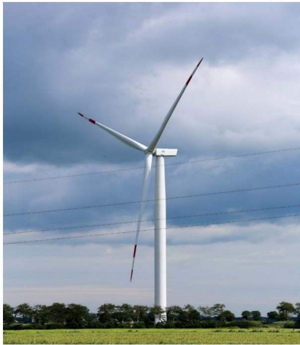
Εικόνα 3.1: Ανεμογεννήτρια οριζόντιου άξονα (HAWT-horizontal axis wind turbine)
