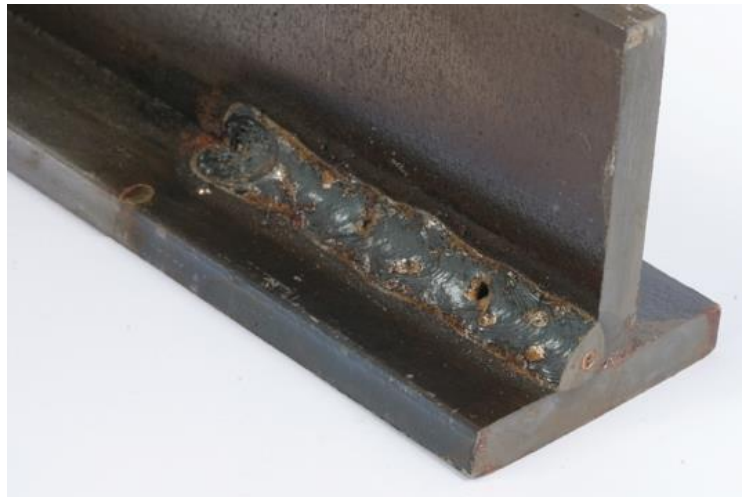
Εικόνα 8. Ρωγμές στον Κρατήρα Συγκόλλησης
