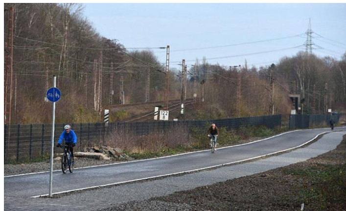
Εικόνα 10: Εγκαταλελειμμένες σιδηροδρομικές γραμμές στο Bommern της Γερμανίας
