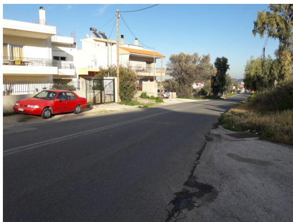
Εικόνα 31: Τμήμα της Επ. Κερατέας-Αναβύσσου χωρίς πεζοδρόμιο
