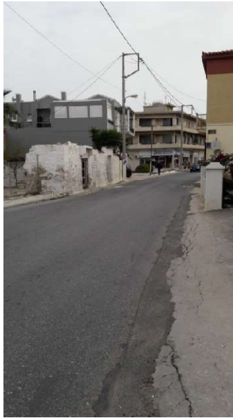
Εικόνα 29: Τμήμα της Αθηνών-Σουνίου χωρίς πεζοδρόμιο
