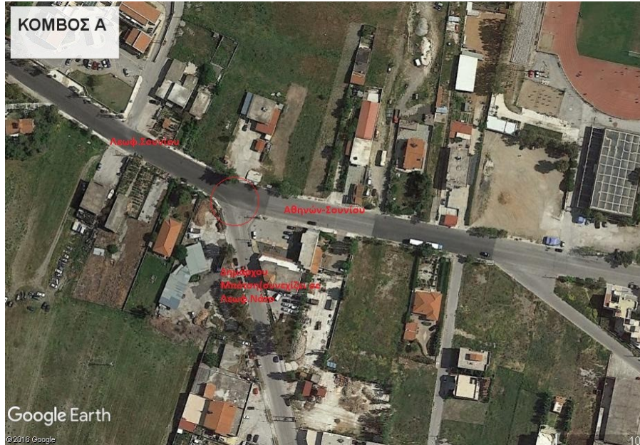
Εικόνα 95: Αεροφωτογραφία κόμβου Α
