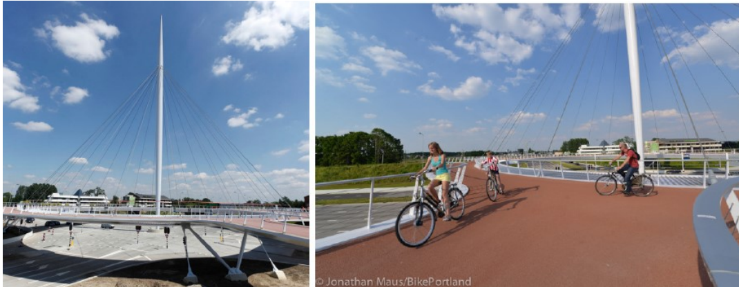
Εικόνα 6: Η γέφυρα Hovenring στο Meerhoven της Ολλανδίας
