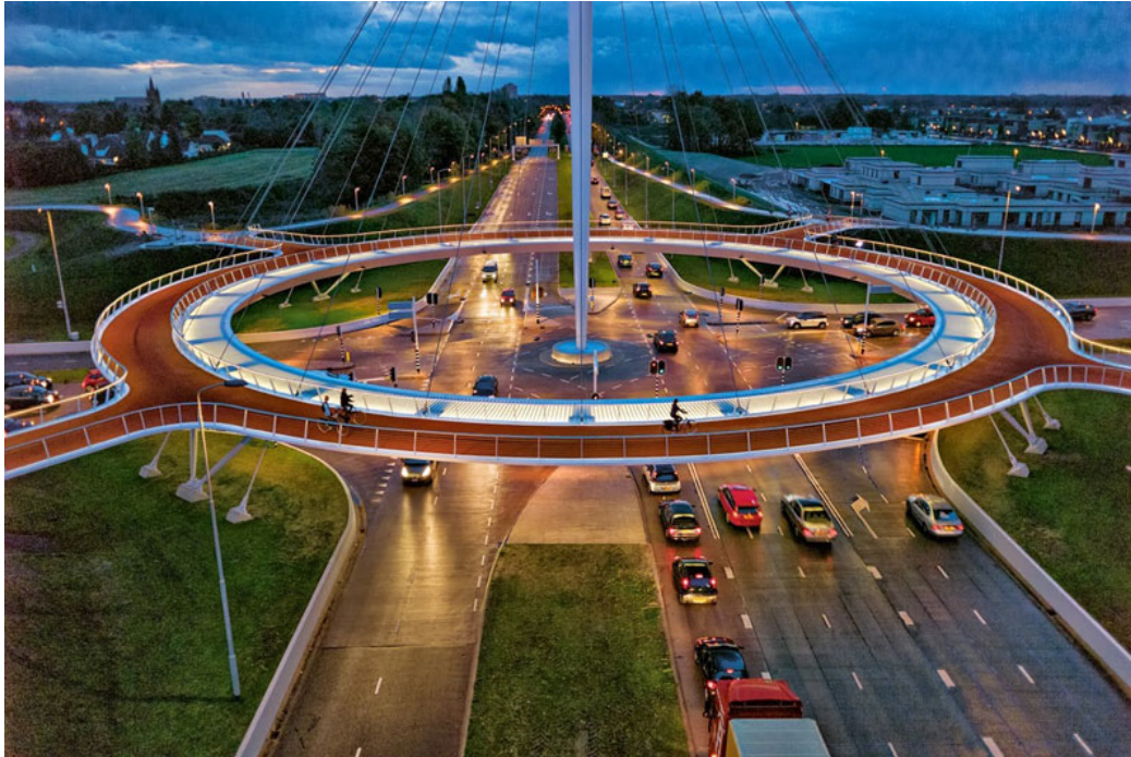
Εικόνα 5: Η γέφυρα Hovenring στο Meerhoven της Ολλανδίας
