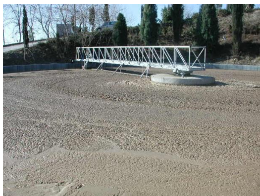
Εικόνα 2.1 Εγκαταστάσεις με έντονα προβλήματα νηματοειδούς αφρισμού
