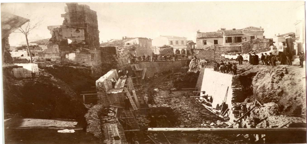
Σχήμα 1 Έτος 1889, εργασίες διάνοιξης σήραγγας μεταξύ Θησείου και Ομονοίας
