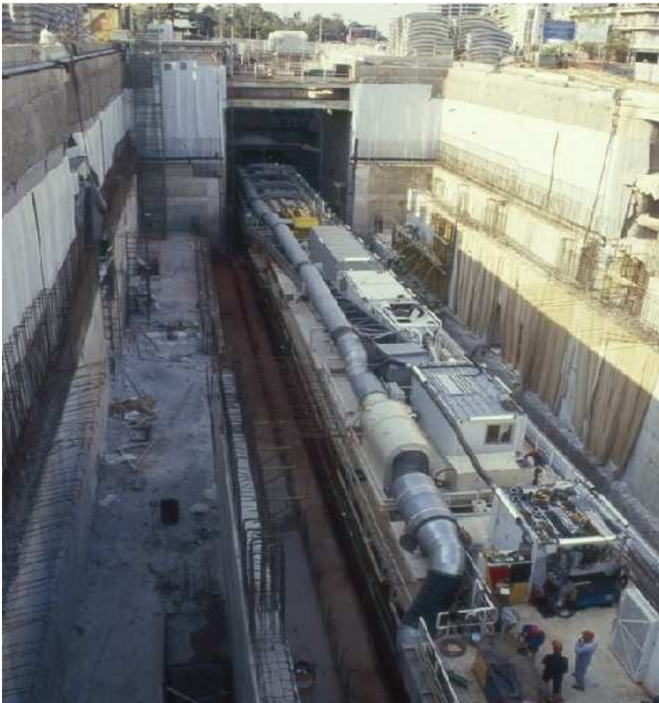
Σχήμα 3 Το μηχάνημα διάνοιξης σηράγγων με την Ανοιχτού Μετώπου Ασπίδα. Πηγή: Αττικό Μετρό
