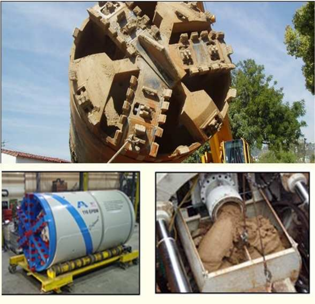
Σχήμα 4 Εκσκαφή με Μηχανήματα Εξισορρόπησης Εδαφικής Πίεσης. Πηγή: Αττικό Μετρό
