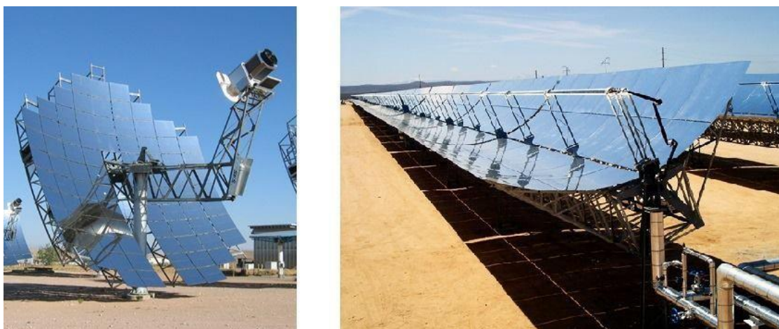
Σχήμα 1.6: α) Συγκεντρωτικός συλλέκτης σημειακής εστίασης, β) Συγκεντρωτικός συλλέκτης γραμμικού τύπου με σωλήνα κενού στο κέντρο [29]
