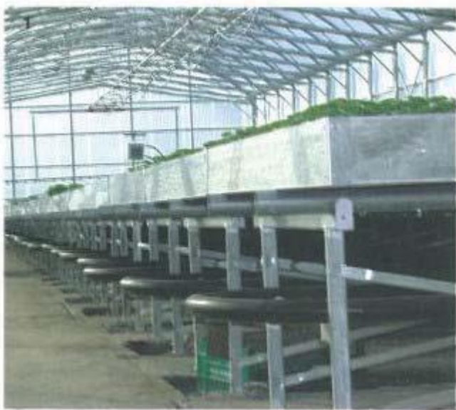
Σχήμα 3.2: Δίκτυο σωληνώσεων ζεστού νερού κοντά στο σύστημα θέρμανσης σωλήνων εδάφους και οροφής [47]
