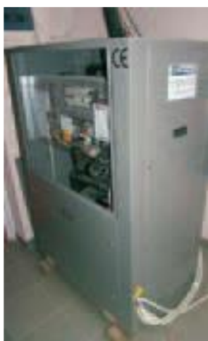
Σχήμα 3.3: Γεωθερμική Αντλία Θερμότητας νερού-νερού
