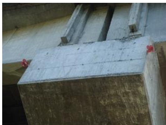
Εικόνα 3.5 Πρίσματα τοποθετημένα στη κεφαλοδοκό μεσοβάθρου
