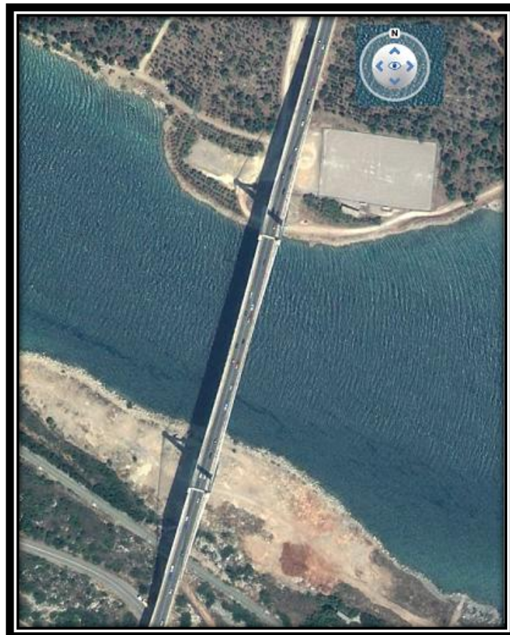
Εικόνα 3.1 Δορυφορική κάτοψη της Υψηλής Γέφυρας του Ευρίπου στη Χαλκίδα
