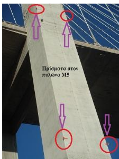
Εικόνα 3.4 Τοποθετημένα πρίσματα σε πυλώνα της γέφυρας
