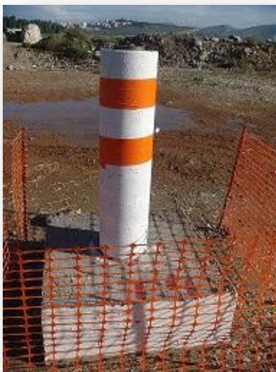
Εικόνα 3.2 Υλοποιημένο βάθρο του δικτύου της Γέφυρας της Χαλκίδας.
