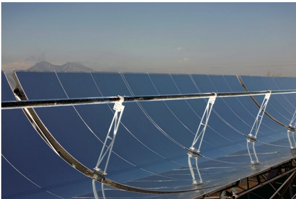
Εικόνα 2.13 Παραβολικός Συλλέκτης με Κάτοπτρο (PTC) [2.11]
