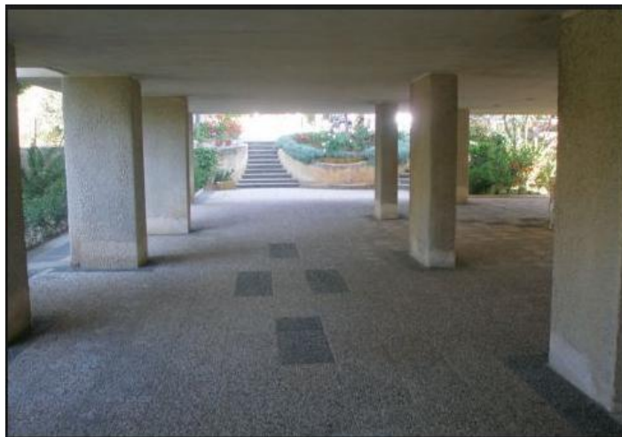
Εικόνα 1-1: Κτίριο με πιλοτή ισόγειου
