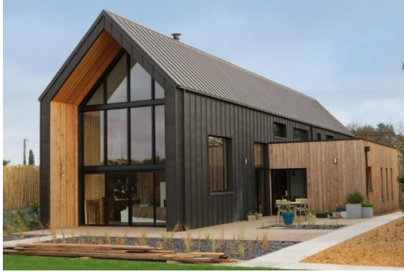
Εικόνα 1.4: Κατοικία (Πηγή / Αρχιτέκτονες: TRACE Architects, Lannilis, Γαλλία)
