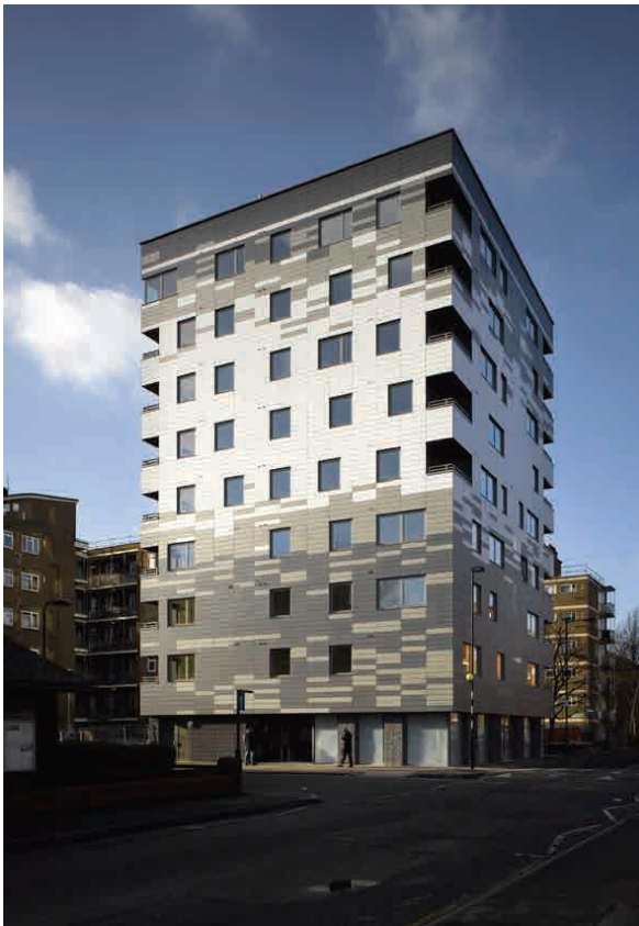
Εικόνα 1.12: Κατασκευή εννέα ορόφων από CLT στο Λονδίνο (Πηγή / Αρχιτέκτονες: Waugh Thistleton Architects, Λονδίνο)
