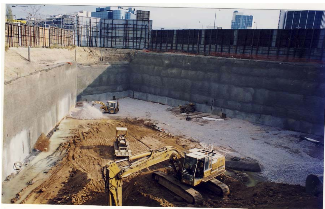
Εικόνα 1.3: Τοίχος αντιστήριξης για την κατασκευή κτηρίων γραφείων IRA SHIPPING CO στην Λ. Συγγρού με αγκύρια – μελέτη (Φωτογραφία: Α. Αθανασιάδης 2001)
