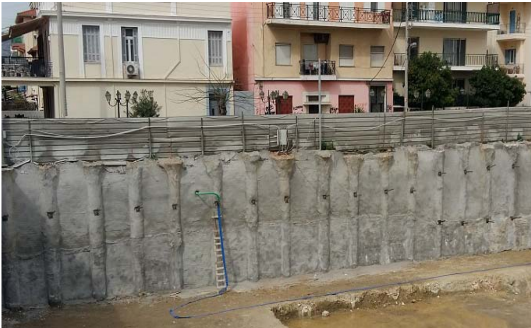
Εικόνα 1.5: Τοίχος αντιστήριξης (πασσαλότοιχος) νέο γήπεδο της ΑΕΚ - (Φωτογραφία από προσωπικό αρχείο).
