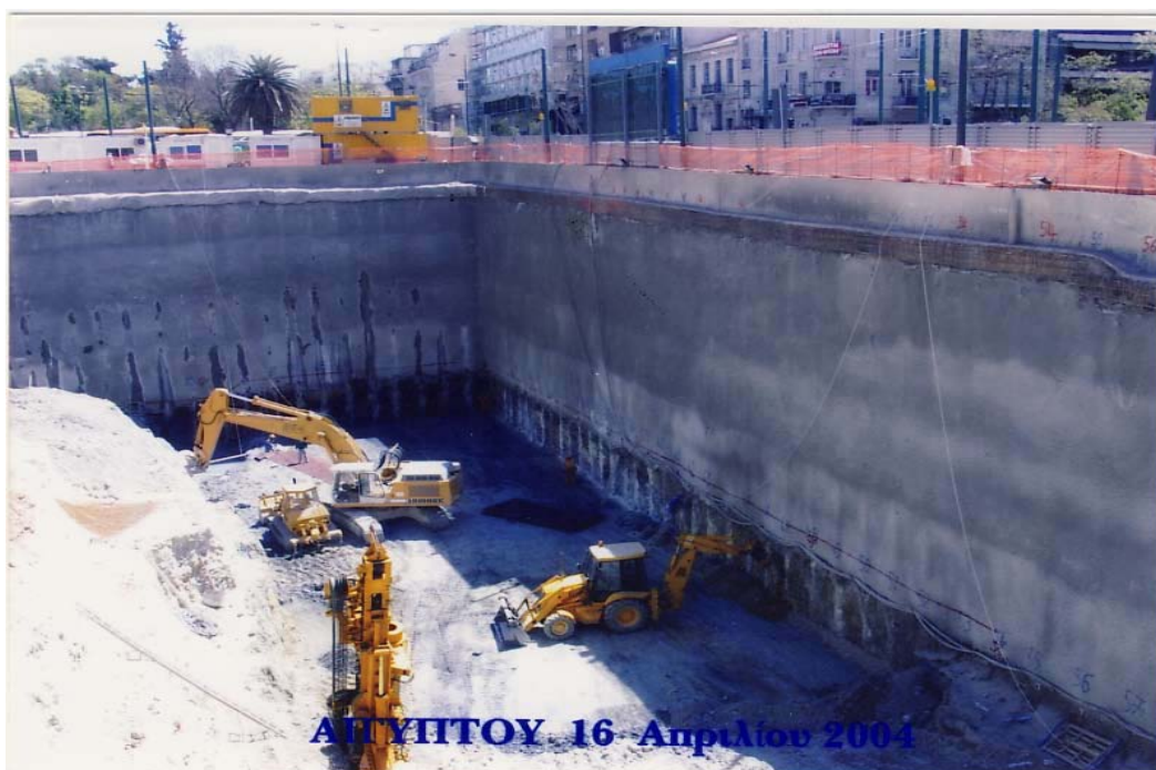
Εικόνα 1.4: Τοίχος αντιστήριξης για την κατασκευή υπογείου Garage Polis Park στην πλατεία Αιγύπτου με πασσαλότοιχο – μελέτη (Φωτογραφία: Α. Αθανασιάδης 2004)
