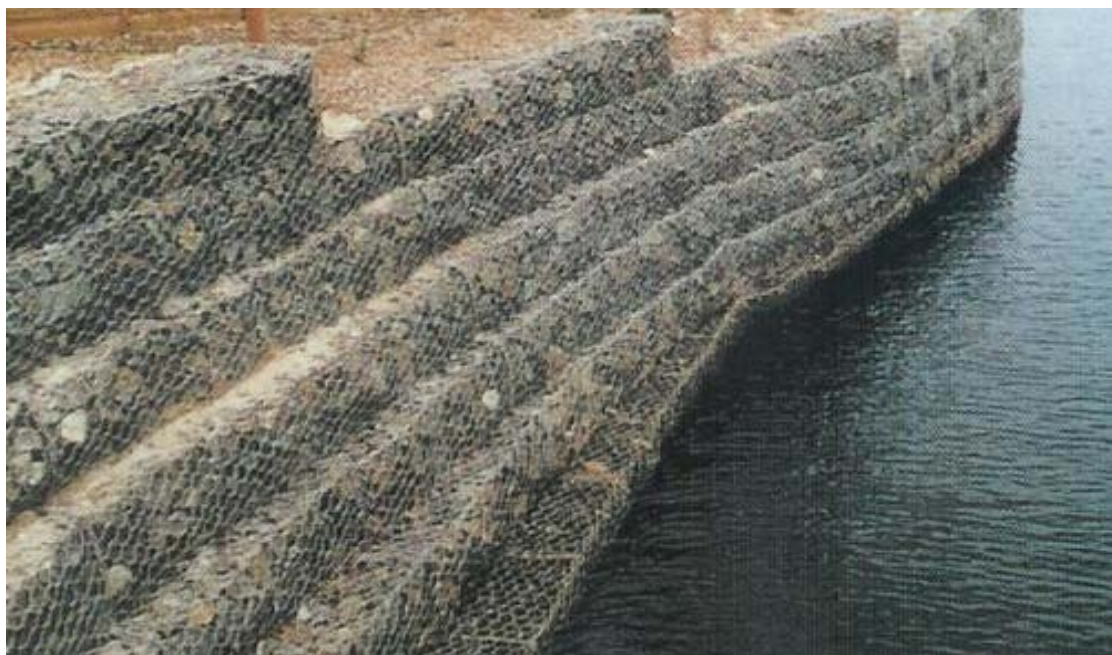
Εικόνα 2.5: Συρματοκιβώτια στις όχθες ποταμού τα οποία λειτουργούν ως αντιστήριξη.
