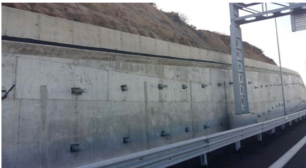
Εικόνα 1.2: Τοίχος αντιστήριξης με αγκύρια Ολυμπίας Οδού - (Φωτογραφία από προσωπικό αρχείο)
