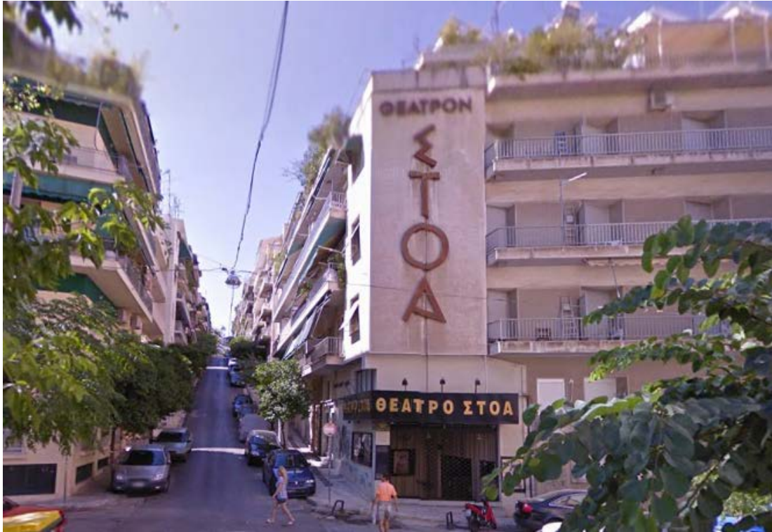
Εικόνα 5.1 Εξωτερική άποψη του θεάτρου <Στοά>
