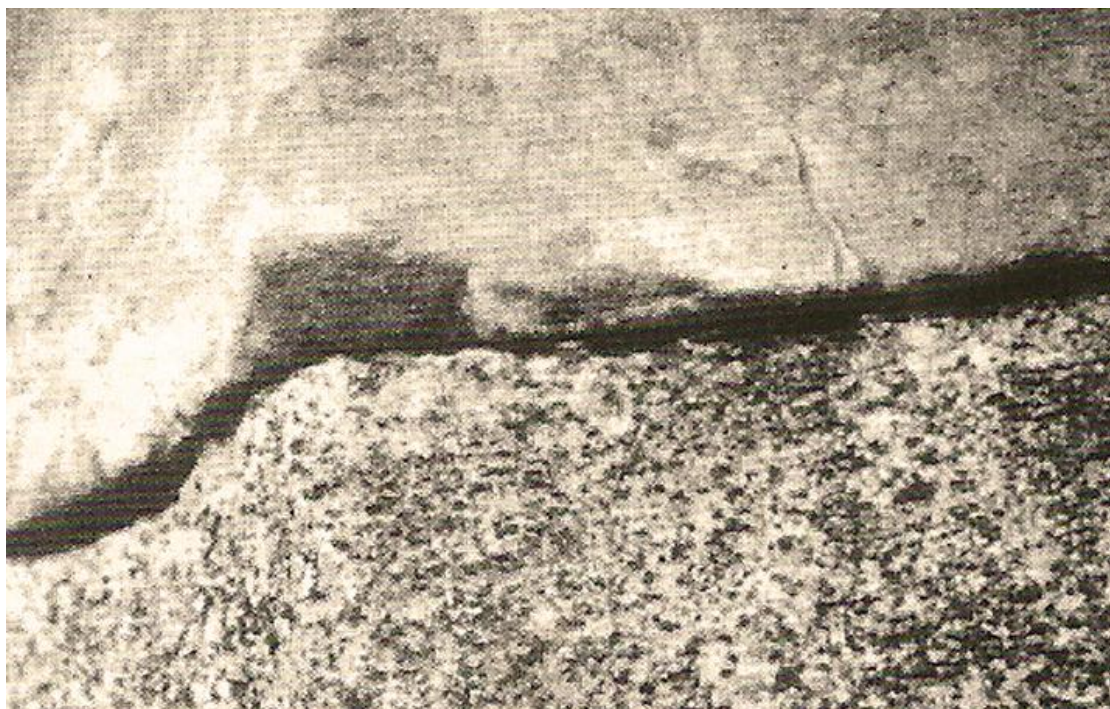
Εικόνα 25: Σφόνδυλος οπλισμένου σκυροδέματος στον Παρθενώνα για την αντικατάσταση χαμένου σφονδύλου. [1]
