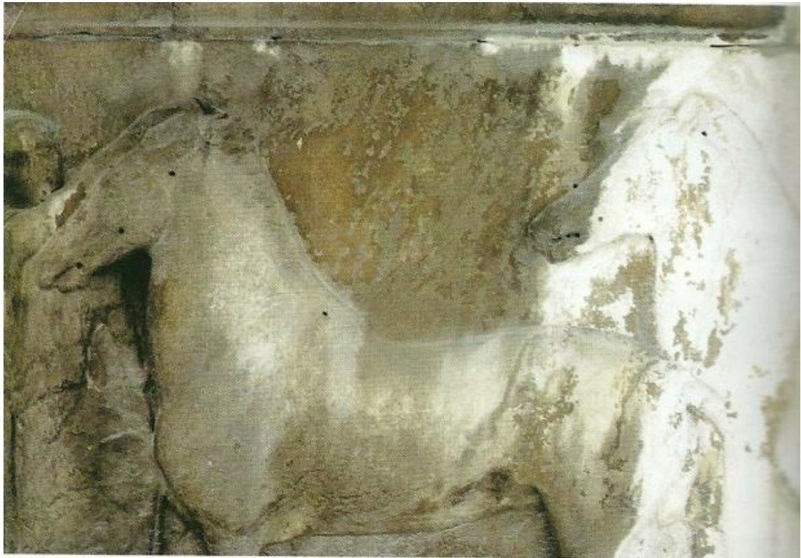
Εικόνα 15 : Η αριστερή χαίτη ήταν πλήρως προστατευμένη από το νερό της βροχής, γυσοποιήθηκε αλλά φαίνονται οι λεπτομέρειές της. Από το κάλυμμα της δεξιάς χαίτης διέφυγε νερό, προσεβλήθη από την όξινη βροχή, οπότε οι λεπτομέρειες εξαφανίστηκαν. ( Φωτογραφία Σ. Μαυρομάτη)
