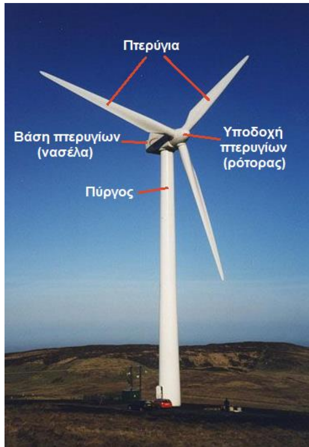
Εικ. 1.4. Τα βασικά μέρη μιας ανεμογεννήτριας οριζόντιου άξονα
