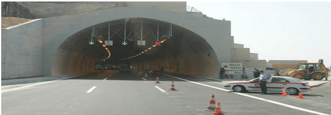
Σχήμα 16: Φωτεινοί σηματοδότες στο εξωτερικό της σήραγγας
