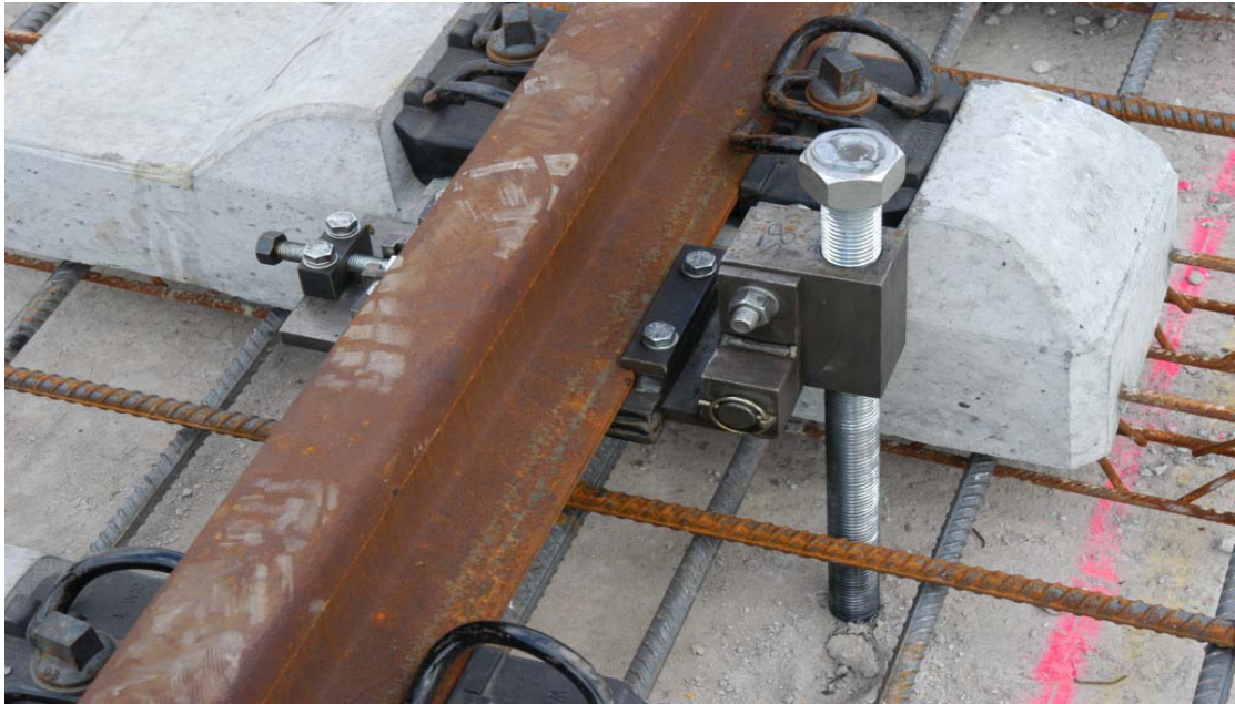
Εικόνα 2.8: Κοχλίας μικροπροσαρμογής σιδηροτροχιών κατά τις εργασίες της χάραξης [Φώλας Α., 2009]
