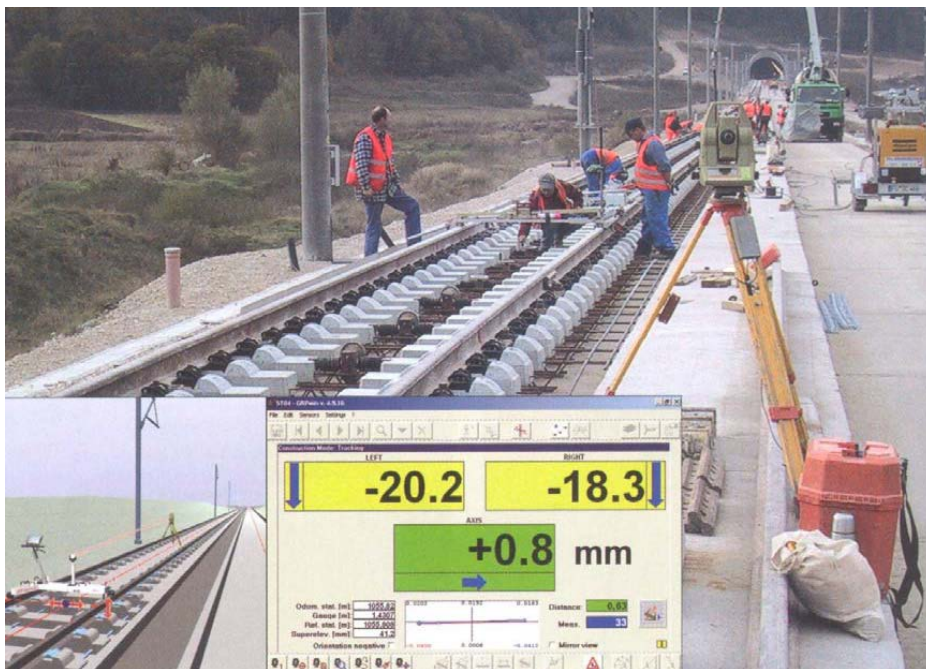
Εικόνα 2.7: Εργασίες χάραξης και προσαρμογής σιδηροτροχιών με τη βοήθεια του αντίστοιχου λογισμικού [ www.rhomberg-sersa.com ]
