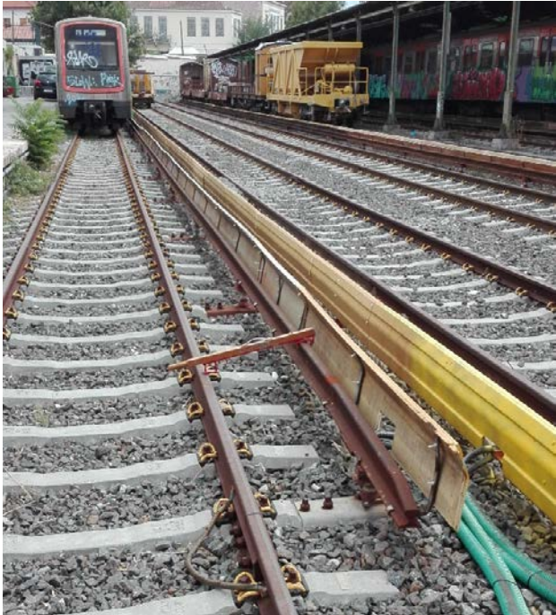
Εικόνα 4.5: Τοποθετημένος βραχυκυκλωτήρας κατά τη διάρκεια εργασιών στο χώρο της γραμμής
