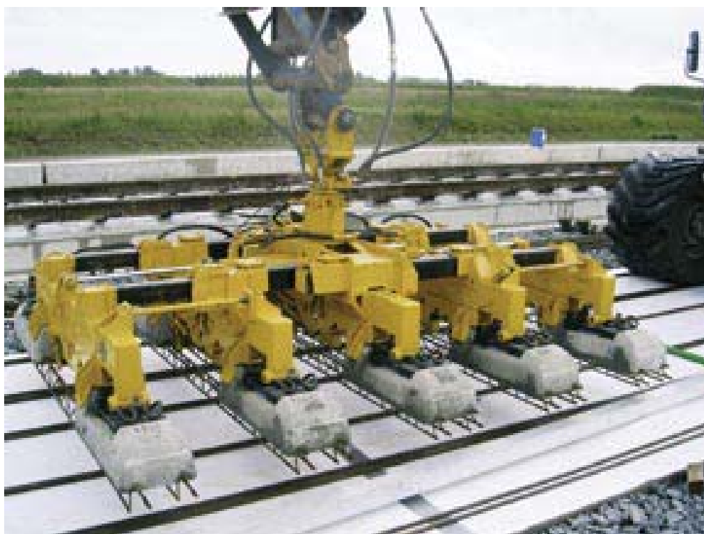
Εικόνα 2.5: Ανύψωση και τοποθέτηση στρωτήρων και σιδηροτροχιών [Φώλας Α., 2009]
