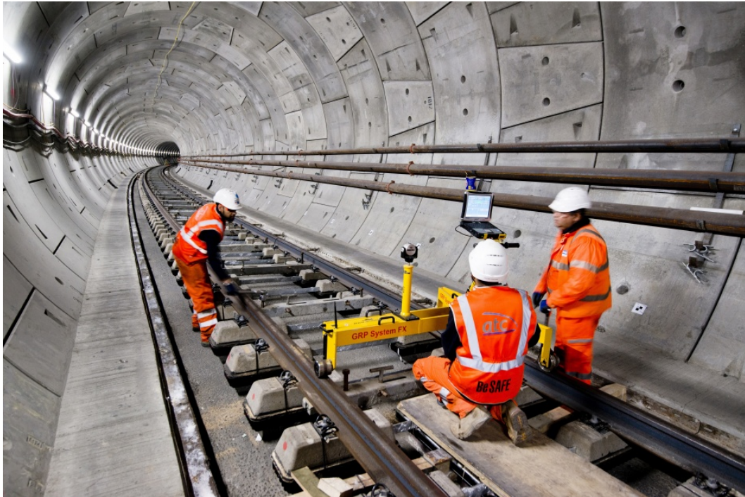
Εικόνα 2.6: Εργασίες προσαρμογής της γραμμής μέσω κοχλίων και με τη χρήση του συστήματος GRP [ http://www.ambergtechnologies.ch/ ]
