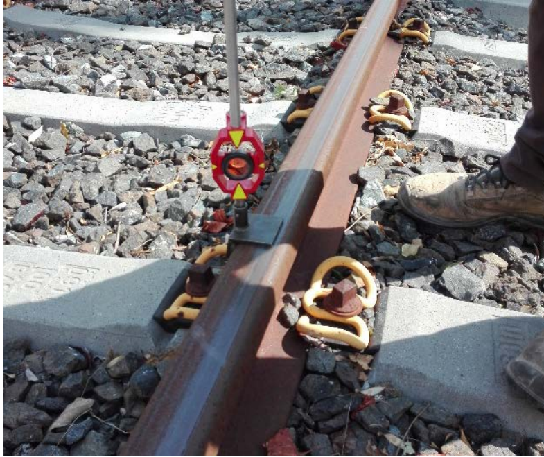
Εικόνα 2.2: Αποτύπωση σιδηροτροχιών με τη μέθοδο των γωνιών
