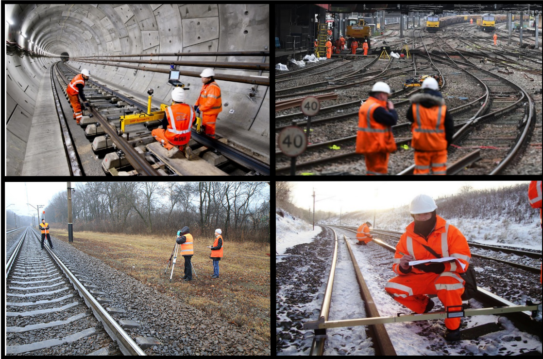
Εικόνα 2.4: Τοπογραφικές εργασίες στο χώρο του σιδηροδρόμου [ www.railstaff.uk , metro.co.uk , ipit.ooo , www.railengineer.uk ]
