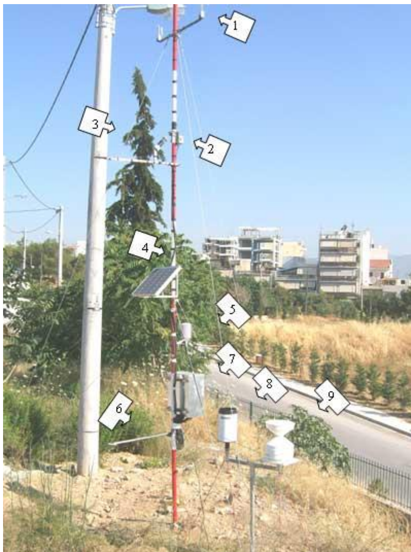
Εικόνα 4.12 Γενική διάταξη των αισθητήρων μέτρησης των σταθμών του δικτύου METEONET
