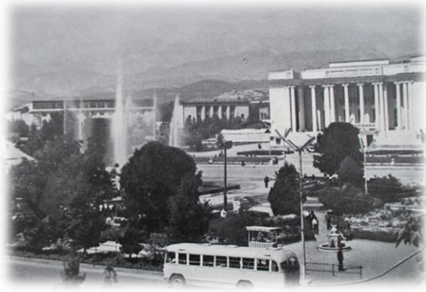
Εικόνα 5.13: Το κτίριο της Όπερας και του Μπαλέτου στη Ντουσάνμπε, 1972
