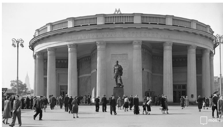
Εικόνα 5.2: Η είσοδος του σταθμού Krasnopresneskaya, 1956
