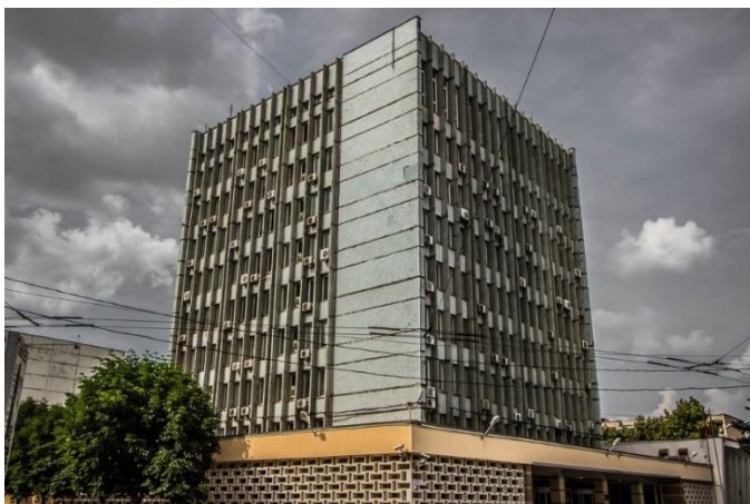
Εικόνα 5.5: Το κτίριο της Εθνικής Τράπεζας της Μολδαβίας, 2011
