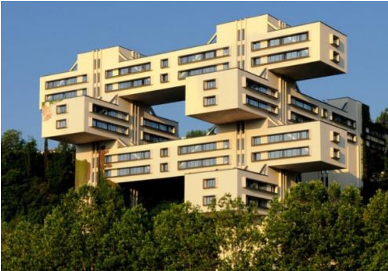
Εικόνα 5.10: Το πρώην Υπουργείο Κατασκευής Αυτοκινητοδρόμων της Γεωργίας κατασκευασμένο το 1967 σήμερα λειτουργεί ως έδρα της Εθνικής Τράπεζας της Γεωργίας
