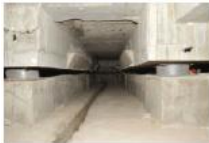
Σχήμα 1-3. Σεισμικά μονωμένη βάση κτιρίου Shaanxi Province
