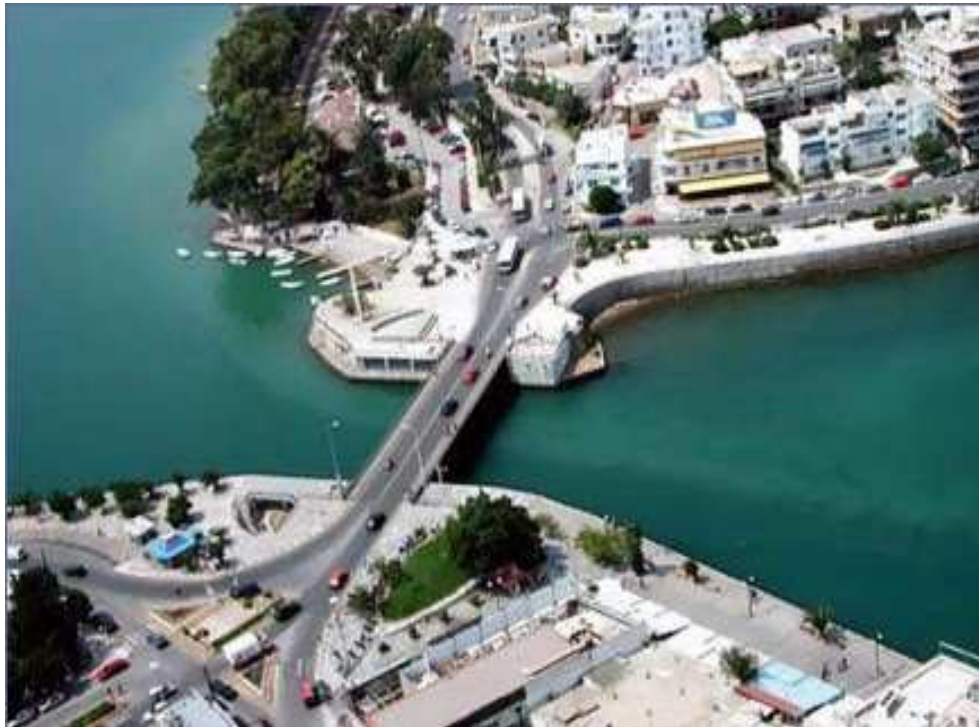
Εικόνα 12: Πορθμόςτου Ευρίπου (Παλαιά γέφυρα)
