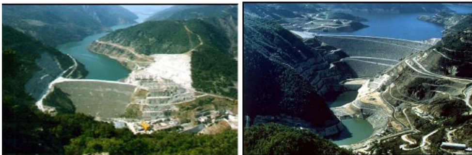
Σχήμα 2.35: Αριστερά: Η μονάδα αντλησιοταμίευσης στον Σφηκιά. Δεξιά: Η μονάδα αντλησιοταμίευσης στον Θησαυρό
