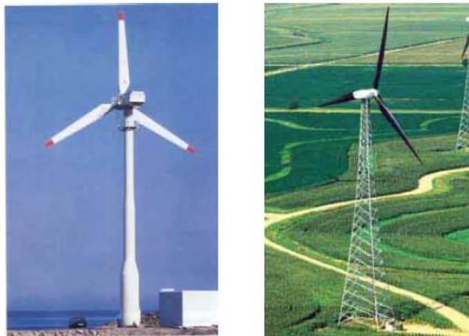
Σχήμα 2.5: Α/Γ με σωληνωτό χαλύβδινο πύργο (αριστερά) και δικτυωτό πύργο (δεξιά), Πηγή: ΚΑΠΕ, 2001
