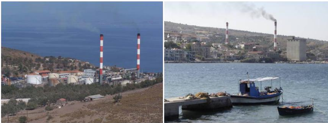
Σχήμα 3.2: Υφιστάμενος σταθμός ηλεκτροπαραγωγής στη Σκάλα Μυτιλήνης
