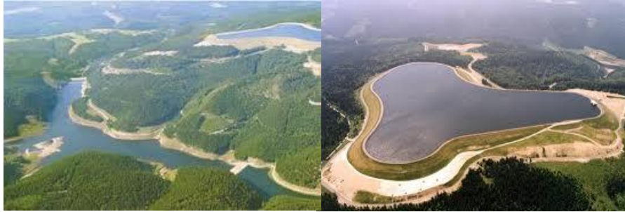
Σχήμα 2.34: Από τα πλέον πρόσφατα αναστρέψιμα υδροηλεκτρικά έργα στο Goldisthal (Γερμανία, 2002) με Υψομετρική διαφορά 302 m, 4 αναστρέψιμες μονάδες ον. ισχύος: 4 \times 265 \text{ MW} = 1.060,0 \text{ MW} και Χωρητικότητα άνω ταμιευτήρα: 700.000 \text{ m}^3 (Πηγή: Παπαντώνης Δ., 2009)
