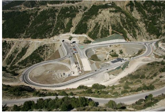
Εικόνα 23: Κόμβος σύνδεσης Εγνατίας Οδού με υπάρχον οδικό δίκτυο (Πηγή: http://www.egnatia.eu )
