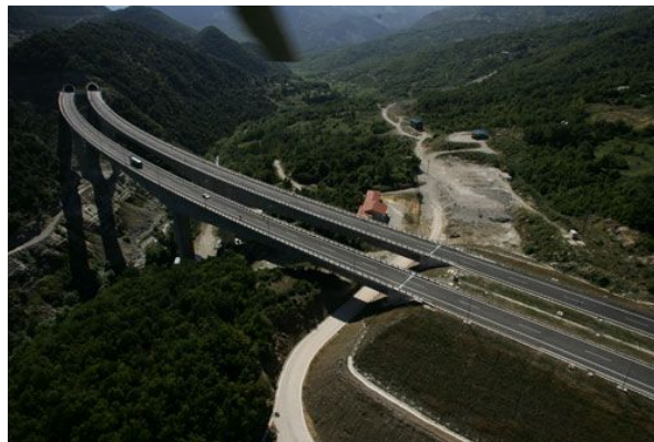
Εικόνα 24: Γέφυρα προβολοδόμησης της Εγνατίας Οδού (Πηγή: http://www.egnatia.eu )
